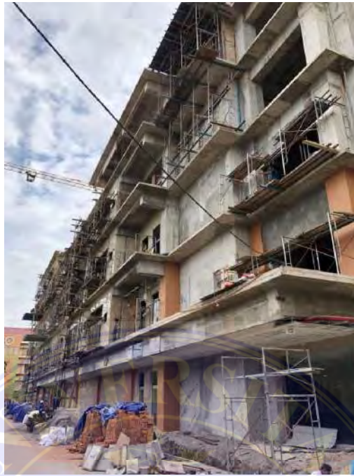
Tampak gedung saat proses pembangunan
