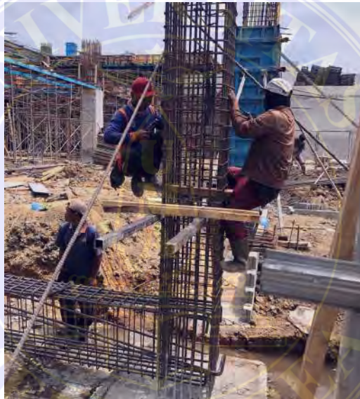
Proses perakitan tulangan kolom
