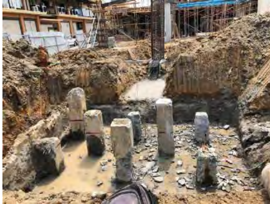
Proses perakitan pondasi Pile Cap
