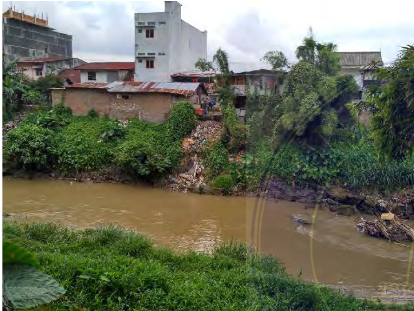
Terjadi penyempitan aliran ditambah lagi pembuangan sampah disekitar sungai (Sumber : Data Lapangan)
