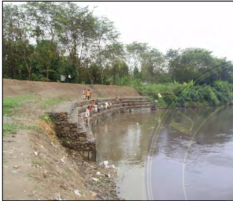
Perkuatan Tebing Tanggul Kiri Sungai Deli dengan Bangunan Bronjong Batu daerah sekitar Labuhan Deli (Sumber : Data Lapangan)
