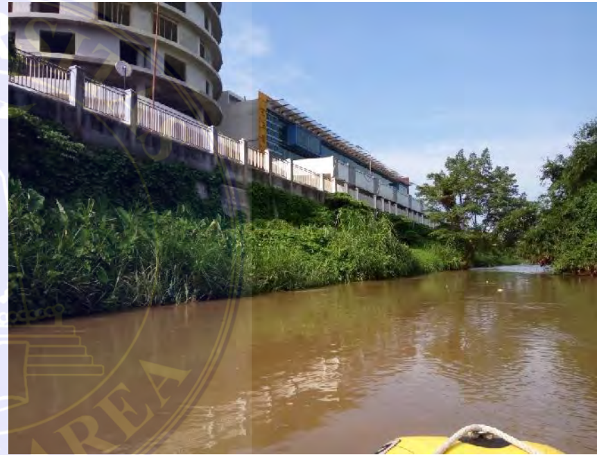
Berdirinya Bangunan yang tinggi dapat membuat air meluap (Sumber : Data Lapangan)
