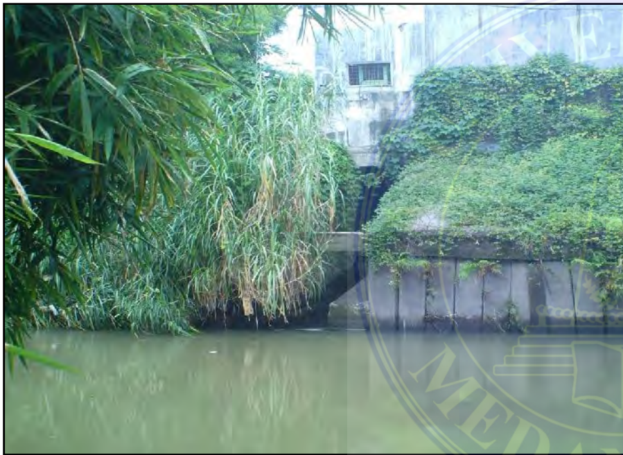
Bangunan Perkuatan Tebing Sungai Deli dengan Turap Beton Kombinasi serta Bangunan Out Let Drainase (Sumber : Data Lapangan)
