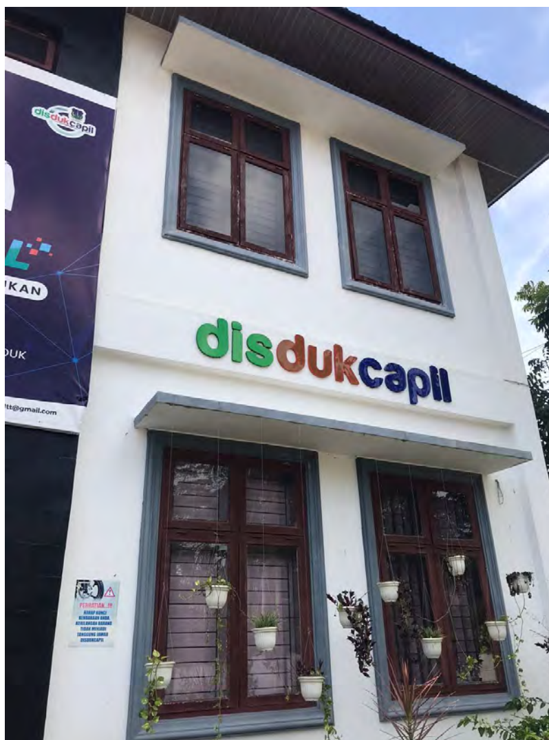
Gambar 1. Kantor Disdukcapil Kota Tebing Tinggi (Sumber: Dokumen Pribadi, 2020)
