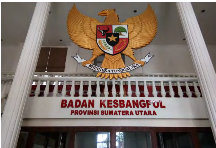
Gambar 2. Gedung Badan Kesatuan Bangsa dan Politik Provinsi Sumatera Utara Sumber : Dokumentasi Pribadi Peneliti
