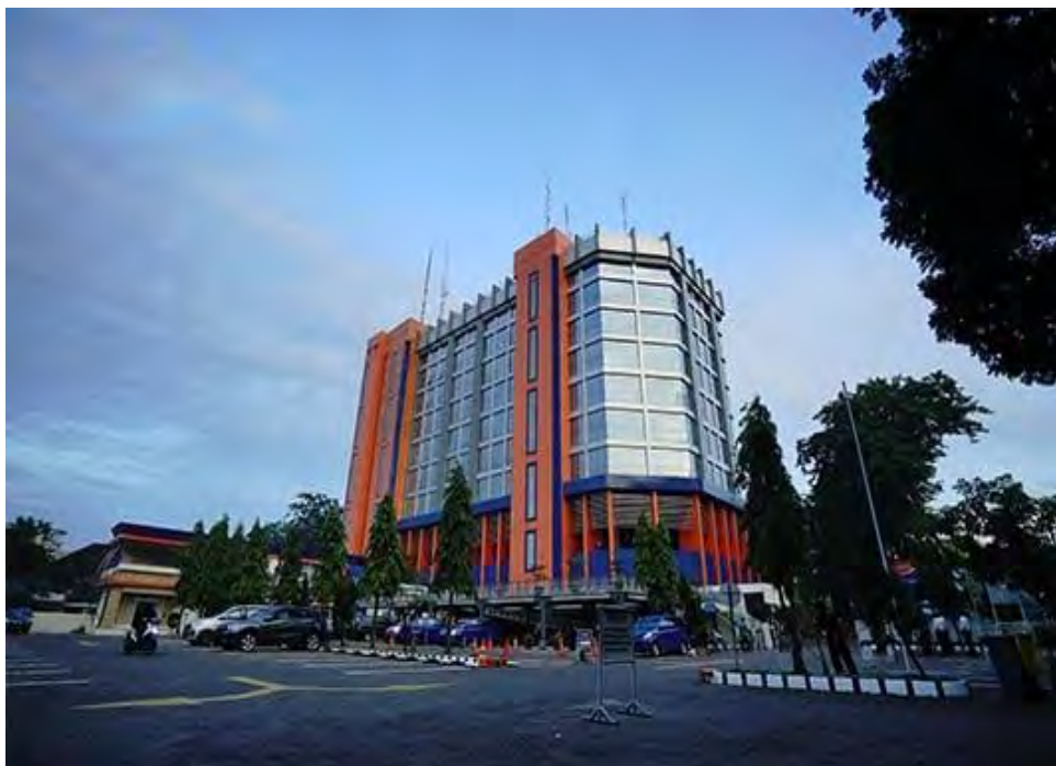
Gambar 1. Gedung BPKAD Provinsi Sumatera Utara Sumber : Dokumentasi Pribadi Peneliti
