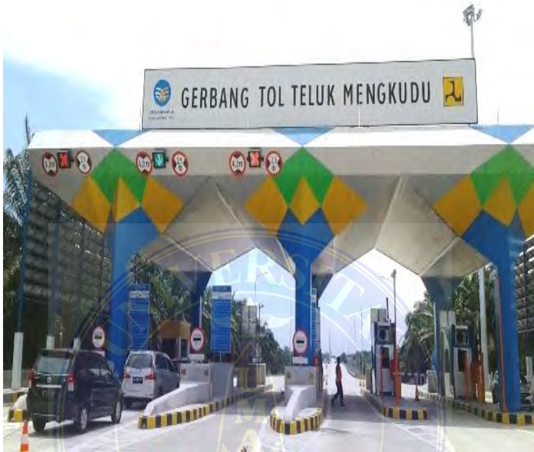
Gambar 3.1 gerbang tol Teluk Mengkudu.
