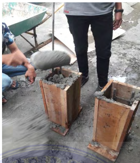
Gambar 3.8 Pengecoran Benda Uji
