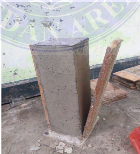
Gambar 3.9 Pembongkaran Bekisting
