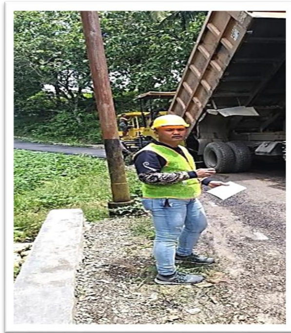
Gambar 1 : Pembongkaran Material Aspal Dari Dump Truck – Finisher
