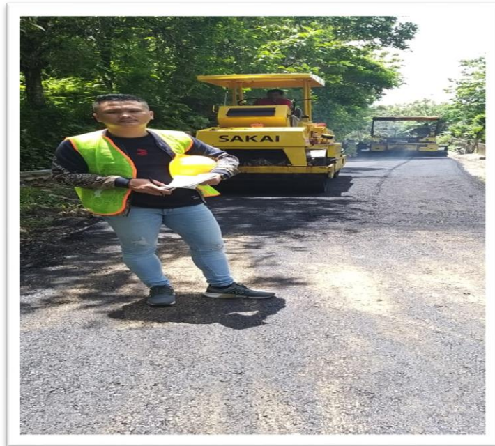
Gambar 6 : Hasil Akhir Pelaksanaan Pekerjaan Perkerasan Aspal
