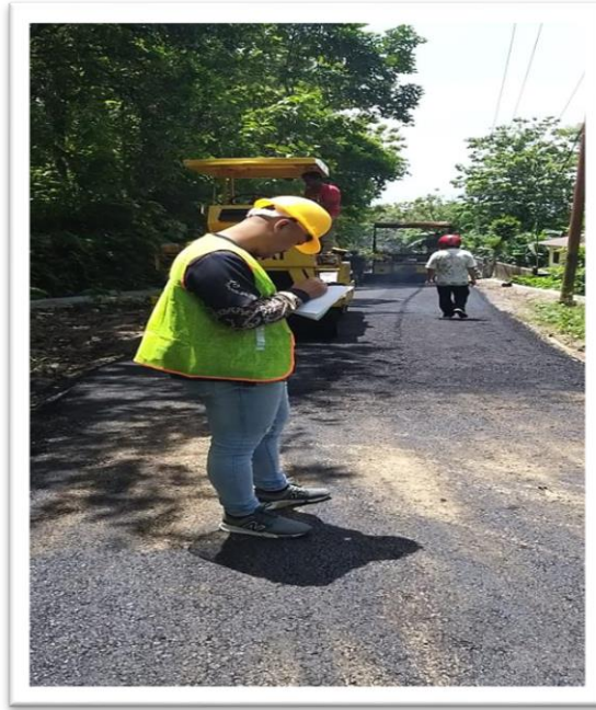
Gambar 3 : Penghamparan Material Aspal Dilokasi Kerja
