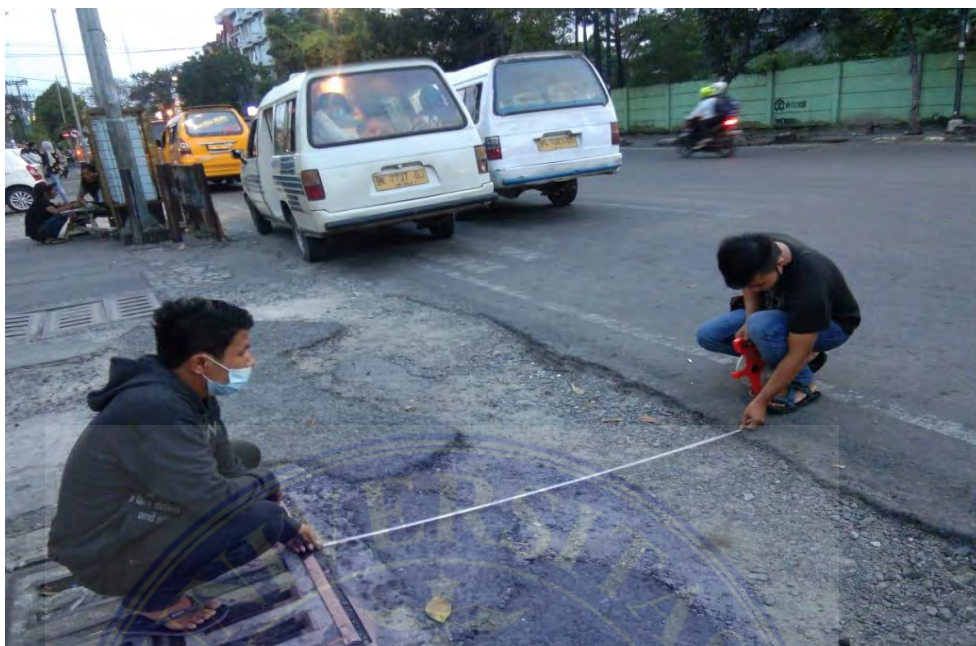
Pengukuran Dimensi Ruas Jalan
