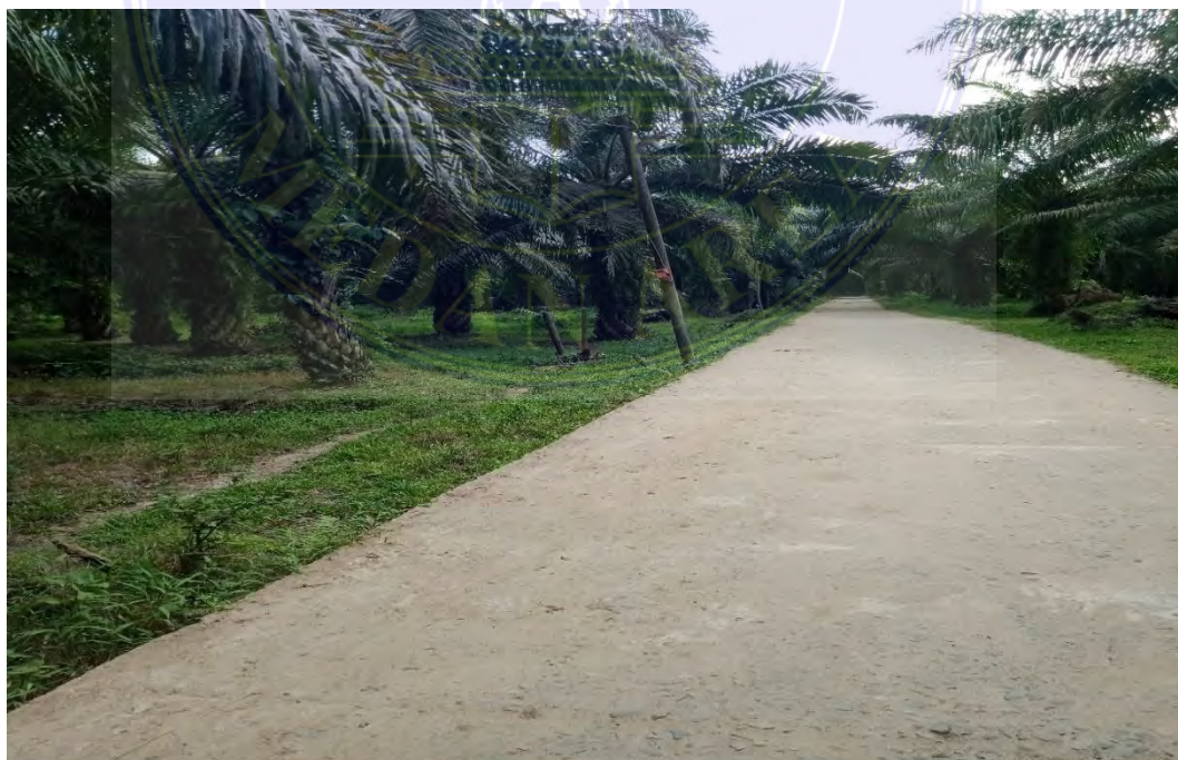
Kondisi Jalan Rabat Beton Huta II Sei Merbau Kecamatan Ujung Padang Kabupaten Simalungun. (( Kamis, 20 Februari 2020, Pukul 15.00 WIB)
