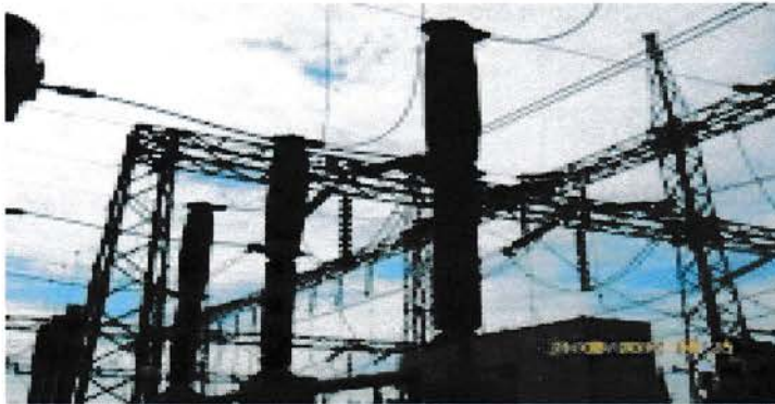
Gambar 2.16 : Pemutus Tenaga dengan Gas SF6 pada GI Namorambe
