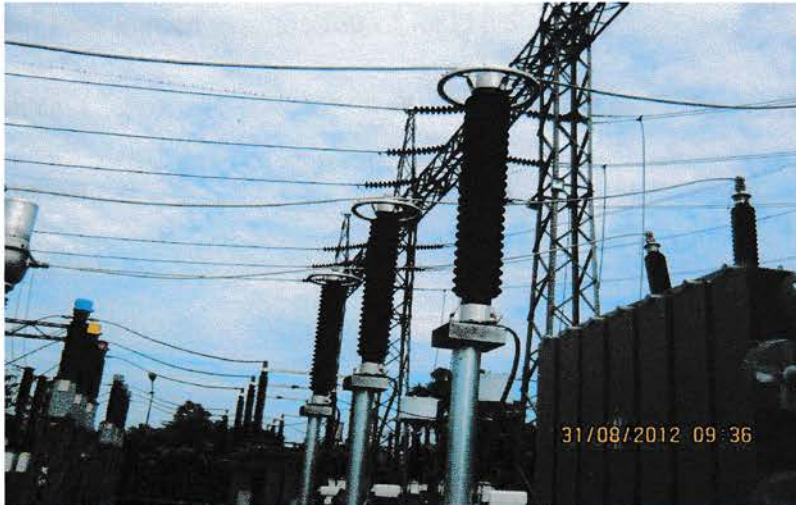
Gambar 2.9 : Transformator Tegangan ( PT )
