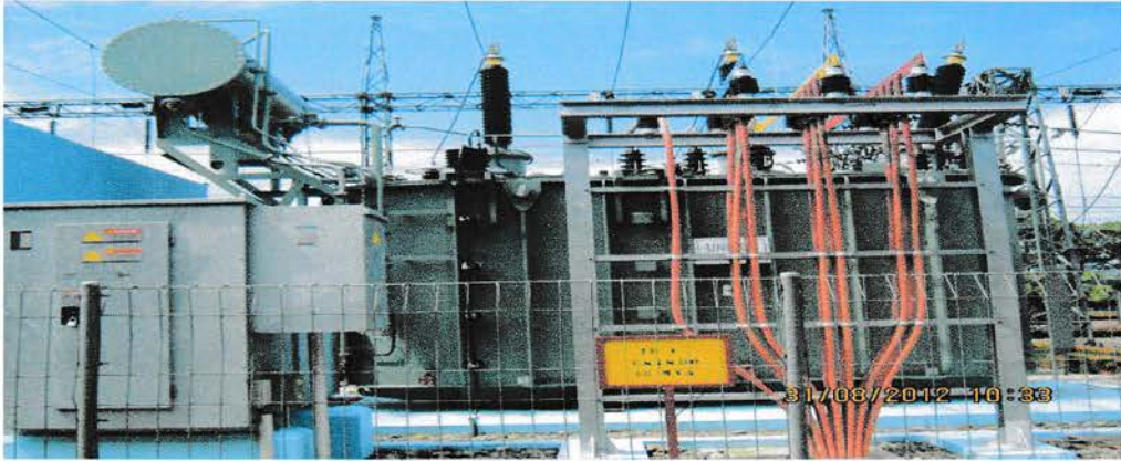
Gambar 2.1 : Trafo Daya 60 MVA di GI Namoranbe
