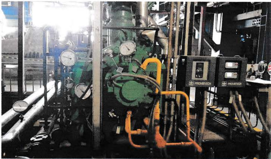
Gambar 3. 5. BFP PLTU Pangkalan Susu
