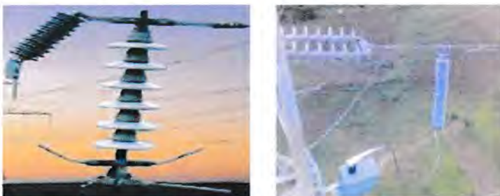
Gambar 2.14 Arrester di GIS
