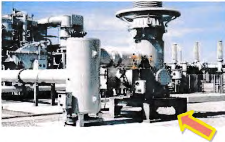
Gambar 2.15 Arrester di Saluran Transmisi
