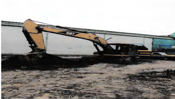
Gambar 3.9 Excavator Sumber : dokumentasi lapangan.
