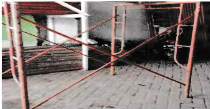
Gambar 3.7 Scaffolding / Perancah Sumber : Dokumentasi lapangan 2020
