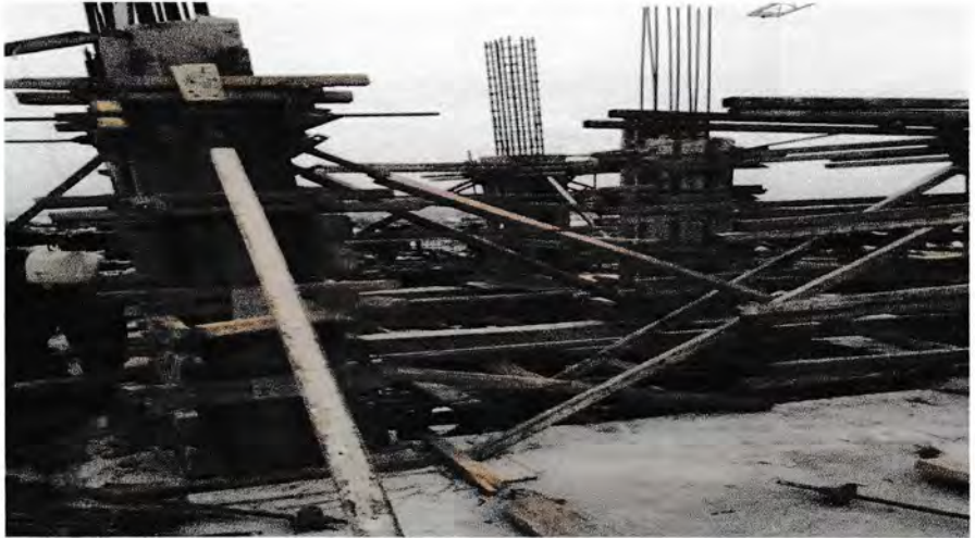
Gambar 3.8 Bekisting Sumber : Dokumentasi lapangan 2020
