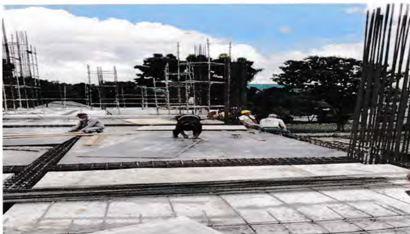
Gambar 4.9 Proses pemasangan bekisting Sumber : Dokumentasi lapangan 2020
