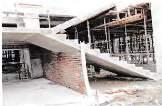
Gambar 4.7 Pembongkaran Bekisting Tangga. Sumber : Dokumentasi lapangan 2020
