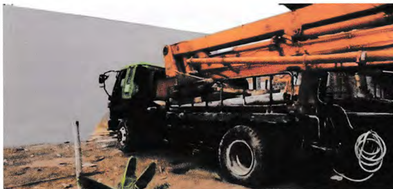
Gambar 3.2 Concret Pump Sumber : Dokumentasi lapangan 2020
