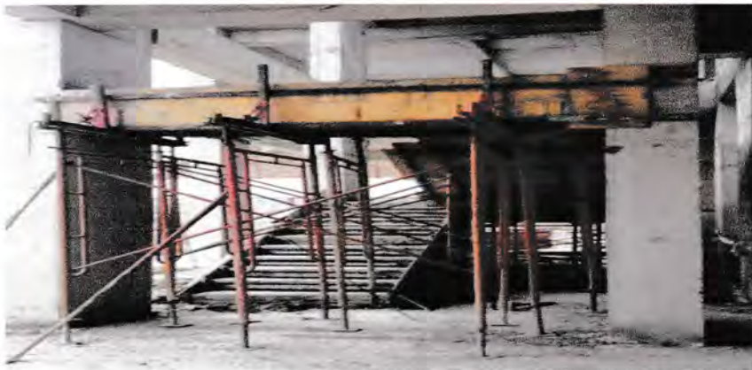
Gambar 4.2 Pemasangan Scaffolding Tangga Sumber : Dokumentasi lapangan 2020
