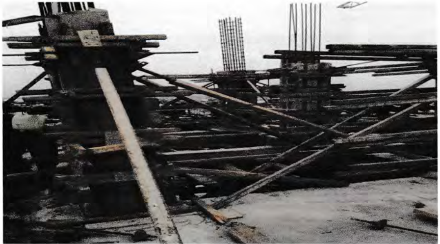
Gambar 3.8 Bekisting Sumber : Dokumentasi lapangan 2020
