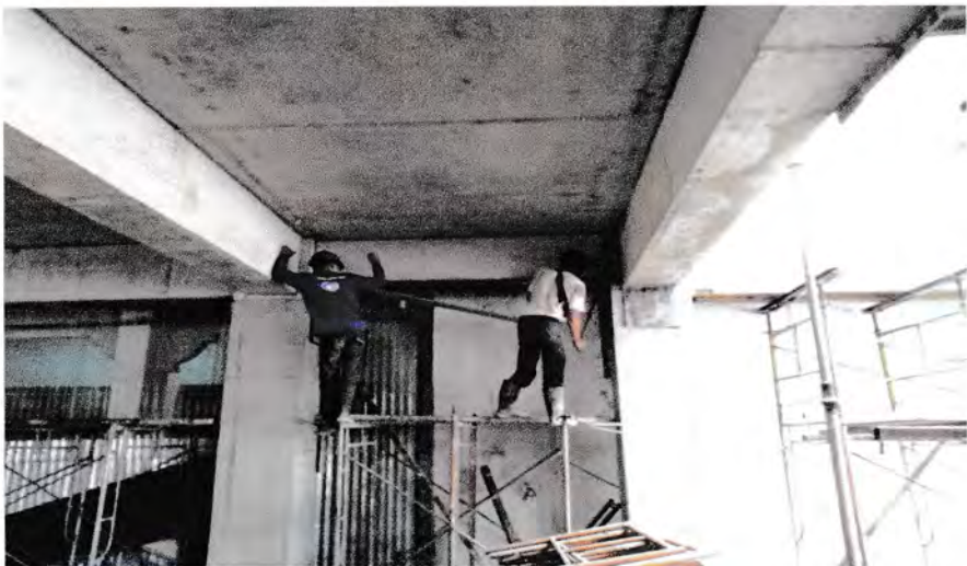
Gambar 4.12 Proses Pelepasan Bekisting Sumber : Dokumentasi lapangan 2020
