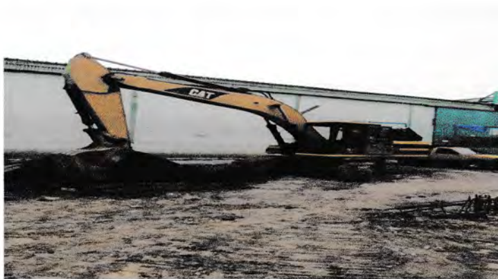
Gambar 3.9 Excavator Sumber : dokumentasi lapangan.
