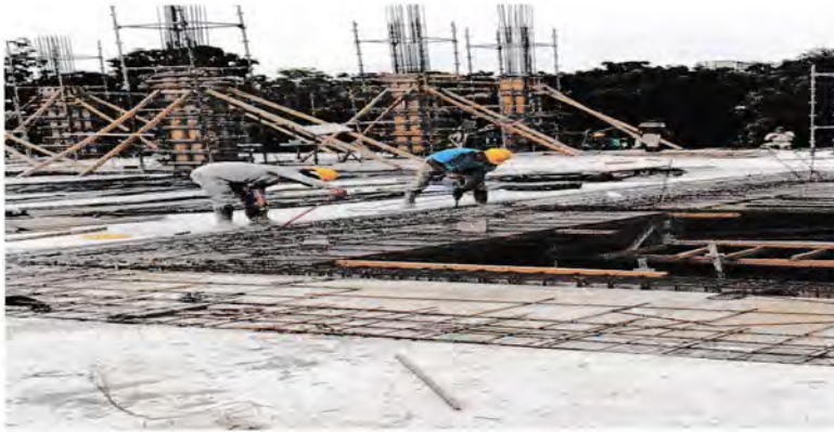
Gambar 4.8 Proses Pekerjaan Plat lantai Sumber : Dokumentasi lapangan 2020
