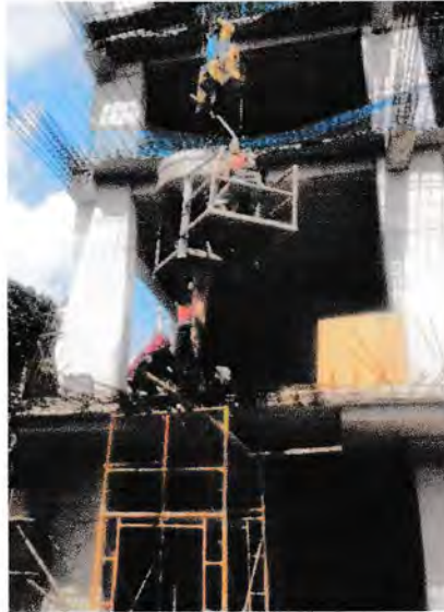
Gambar 4.6 Pengecoran Tangga Sumber : Dokumentasi lapangan 2020
