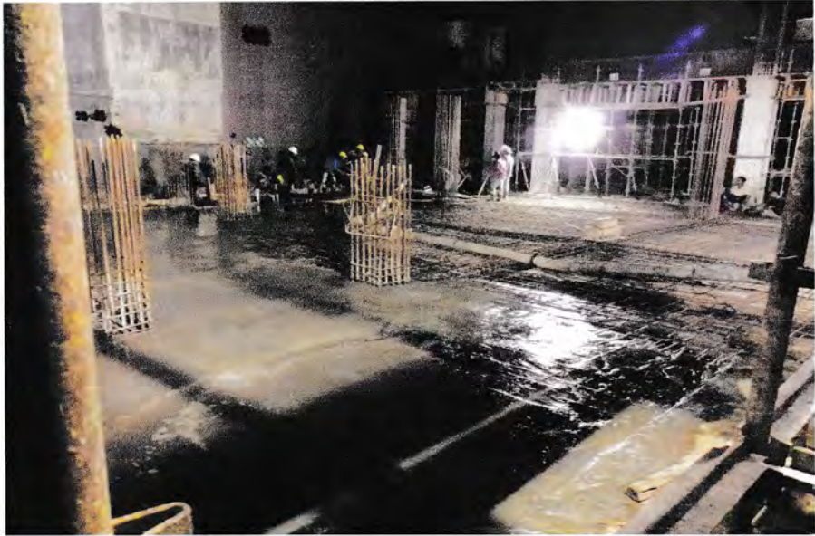
Gambar 4.11 Proses pengecoran plat lantai 2 Sumber : Dokumentasi lapangan 2020
