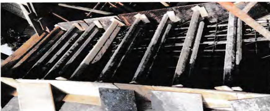
Gambar 4.4 Pemasangan Tulangan Tangga Sumber : Dokumentasi lapangan 2020
