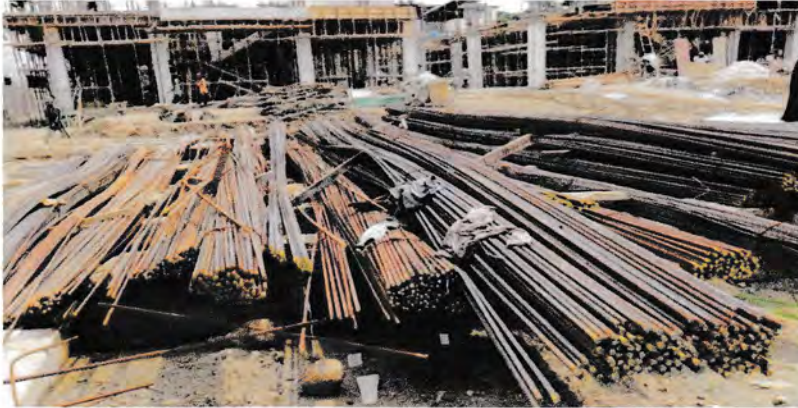
Gambar 3.13 Besi Tulangan Sumber : Dokumentasi Lapangan 2020
