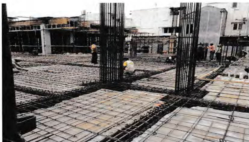
Gambar 4.10 Proses pembesian plat lantai 2
