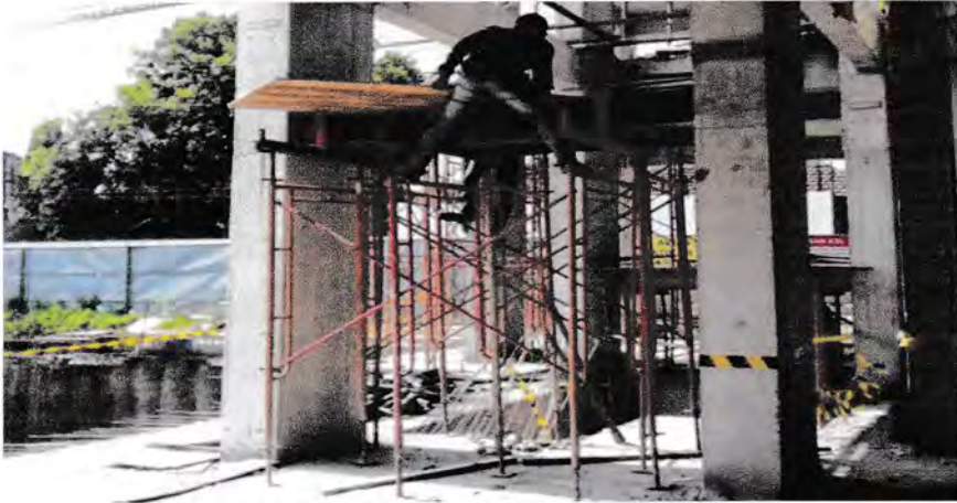
Gambar 4.3 Pemasangan Bekisting Tangga Sumber : Dokumentasi lapangan 2020
