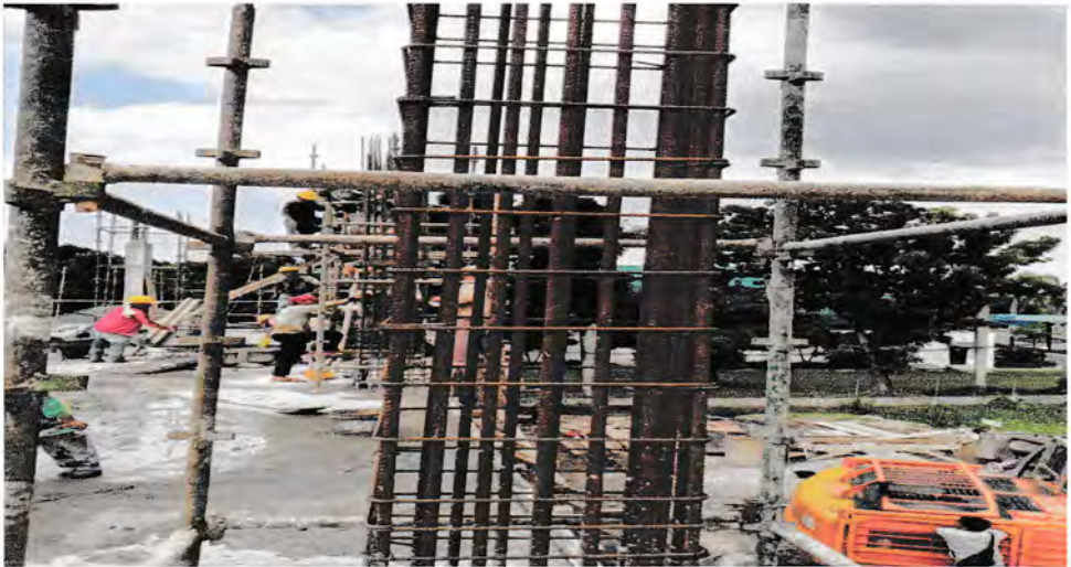
Gambar 4.1 Penulangan kolom Sumber : Dokumentasi lapangan 2020
