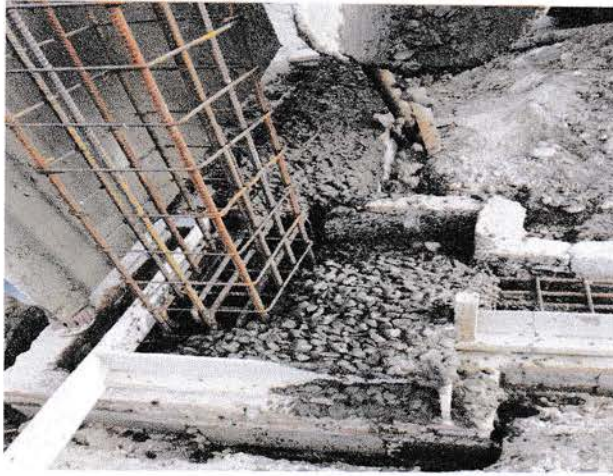
Gambar 4.3 Pengecoran Pilecap Sumber: Dokumentasi Pribadi
