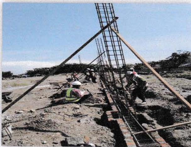
Gambar 4.4 Pembesian Balok Sloof Sumber : Dokumentasi Pribadi
