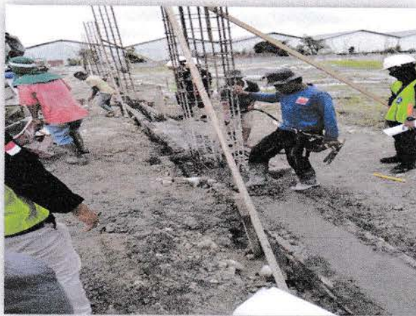
Gambar 4.7 Pemasangan Tulangan Kolom Sumber: Dokumentasi Pribadi
