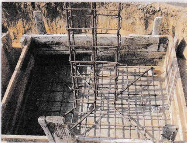
Gambar 4.2 Pemasangan Bekisting Pilecap Sumber: Dokumentasi Pribadi
