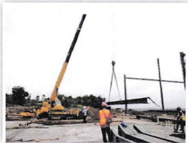
Gambar 3.4 Mobile Crane Sumber : Dokumentasi Pribadi
