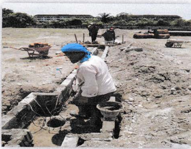
Gambar 4.5 Pemasangan Bekisting Bata Hebel Sumber : Dokumentasi Pribadi
