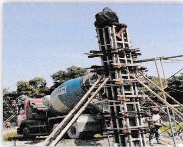
Gambar 4.10 Penuangan Beton ke Bekisting Kolom
