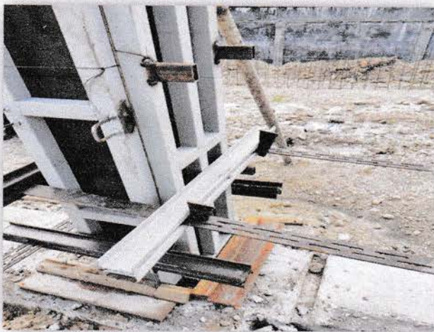
Gambar 4.9 Bekisting Kolom Sumber: Dokumentasi Pribadi
