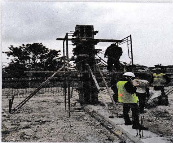
Gambar 4.8 Bekisting Kolom Sumber: Dokumentasi Pribadi
