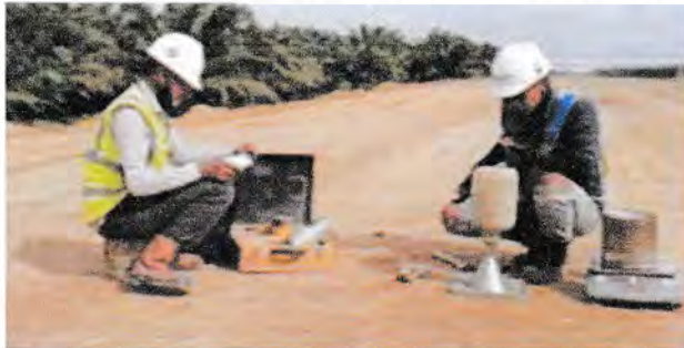
Gambar 4.31 Tes uji sand cone
