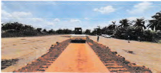
Gambar 4.20 Pelaksanaan Trial Compaction menggunakan vibrator roller
