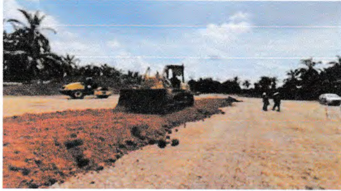
Gambar 4.22 Penghamparan dengan bulldozer
