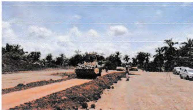
Gambar 4.23 Pemadatan dengan sheep foot roller
