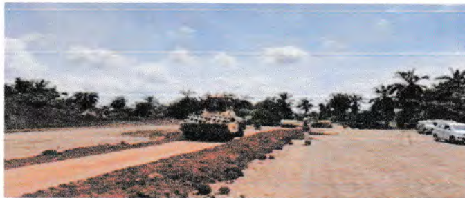
Gambar 4.21. Pelaksanaan Trial Compaction menggunakan sheep foot roller
