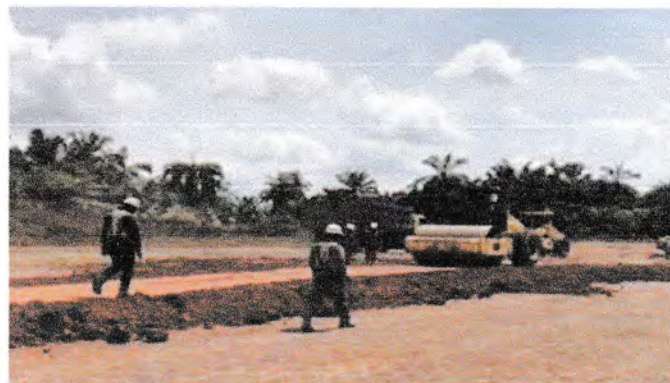
Gambar 4.24 Pemadatan dengan vibro roller
