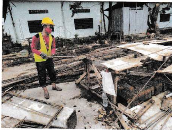
Gambar 3.7 Bar Bending (Sumber : dokumentasi lapangan)
