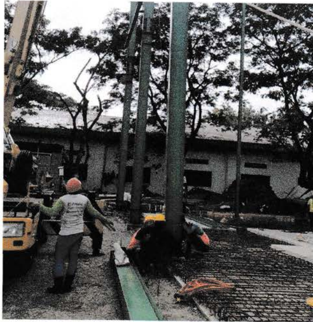
Gambar 4.27 Pekerja memasang angkur kolom baja WF (Sumber : dokumentasi lapangan)
