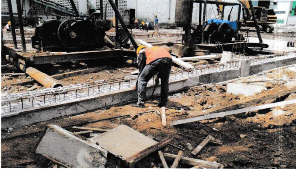
Gambar 4.22 Pembongkaran Bekisting Tie Beam
