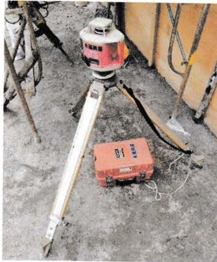
Gambar 3.3 Waterpass (Sumber : dokumentasi lapangan)
