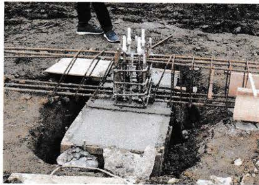
Gambar 4.13 Pengecoran Pile Cap
