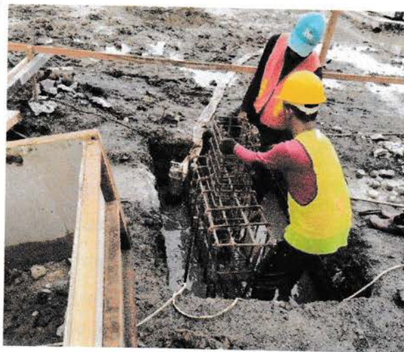
Gambar 4.11 Pemasangan pedestal pada pile cap
