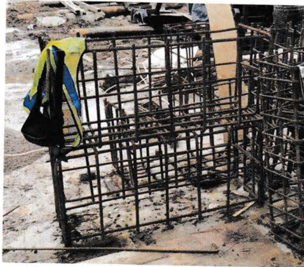
Gambar 4.9 Tulangan Pile Cap (Sumber : dokumentasi lapangan)
