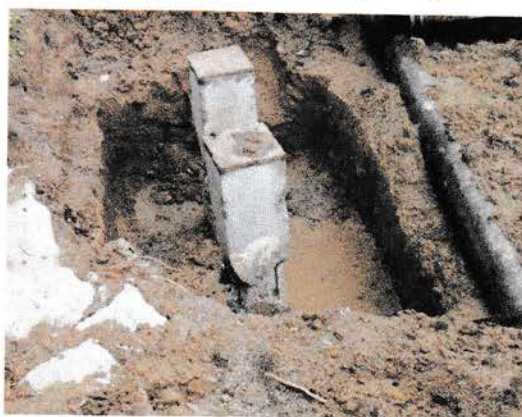
Gambar 4.8 Pembobokan tiang pancang (Sumber : dokumentasi lapangan)
