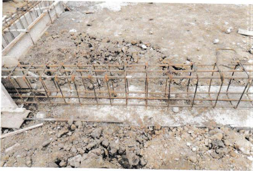
Gambar 4.18 Tulangan Tie Beam (Sumber : dokumentasi lapangan)
