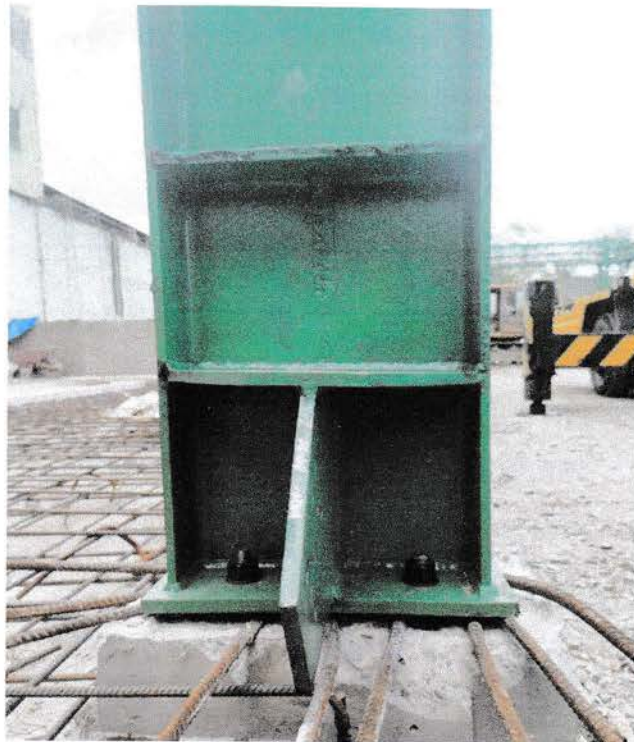
Gambar 4.28 Hasil pemasangan kolom baja WF (Sumber : dokumentasi lapangan)
