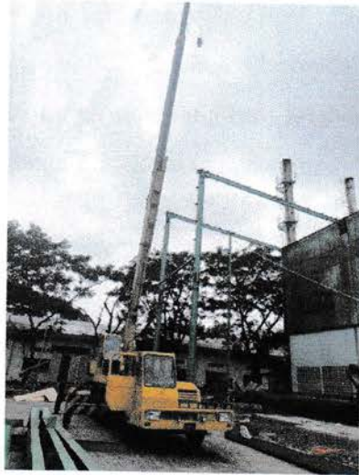
Gambar 3.9 Truck Crane (Sumber : dokumentasi lapangan)
