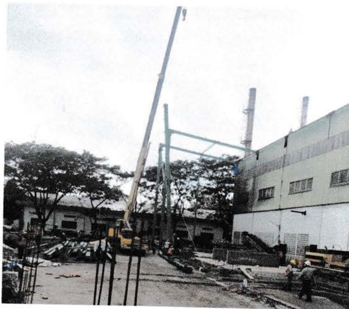
Gambar 4.26 Proses pengangkatan kolom baja WF
