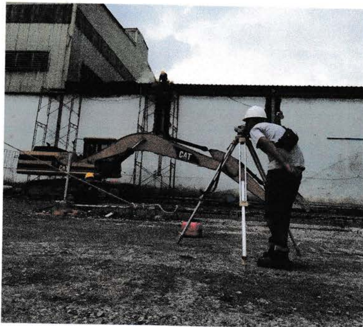
Gambar 4.25 surveyor mengecek elevasi kolom
