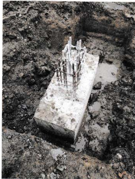
Gambar 4.14 Hasil dari pengecoran pile cap setelah bekisting dilepas (Sumber : dokumentasi lapangan)
