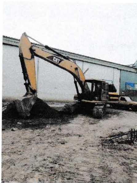
Gambar 3.4 Excavator (Sumber : dokumentasi lapangan)
