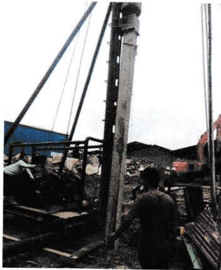
Gambar 4.3 Pemasangan tiang pancang
