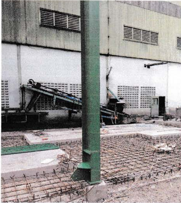
Gambar 4.34 Kolom Baja WF Yang Telah Selesai Dipasang
