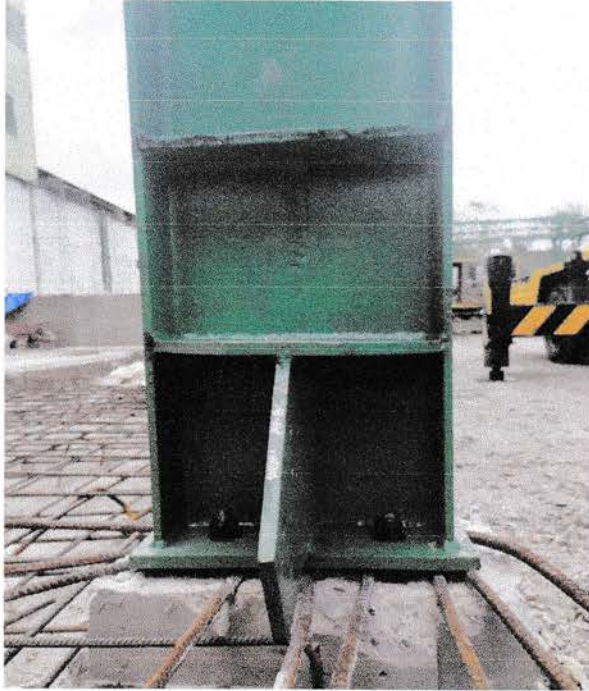
Gambar 4.32 Baut Kolom Baja WF Pada Angkur
