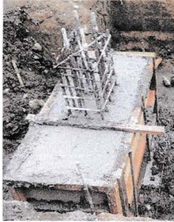
Gambar 4.14 Pengecoran PileCap
