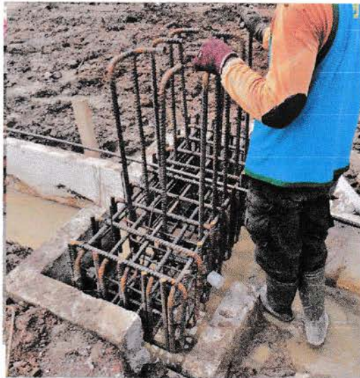
Gambar 4.12 Pemasangan angkur dan pedestal pada pilecap
