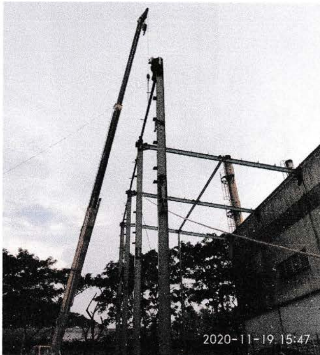
Gambar 4.30 Proses Pemasangan Kolom Baja WF
