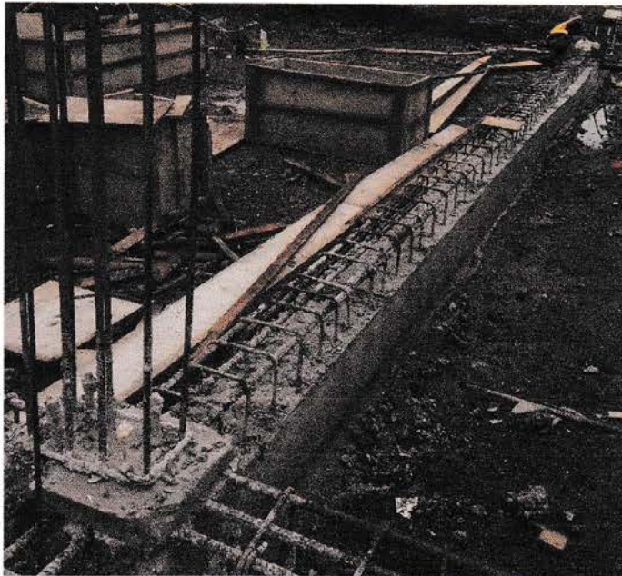
Gambar 4.23 Pembongkaran Bekisting Tie Beam
