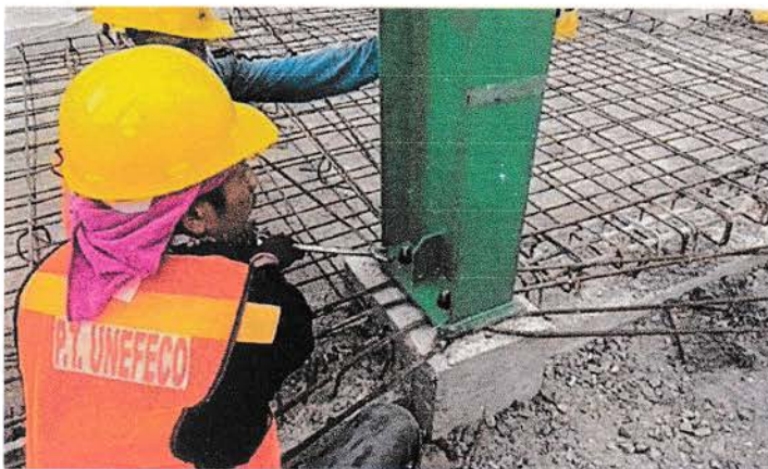
Gambar 4.31 Pekerja Memasang Baut Kolom Baja WF Pada Angkur
