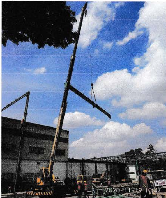
Gambar 4.29 Pengangkatan Kolom Baja WF
