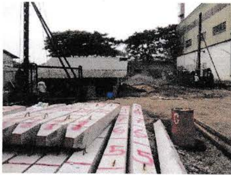
Gambar 3.11 Tiang Pancang (Sumber : Dokumentasi Pribadi)
