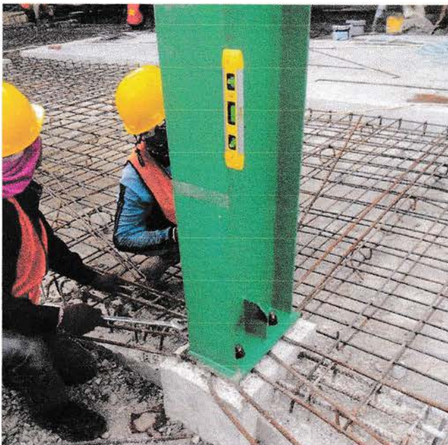
Gambar 4.33 Pengukuran Kelurusan Kolom Menggunakan Waterpass
