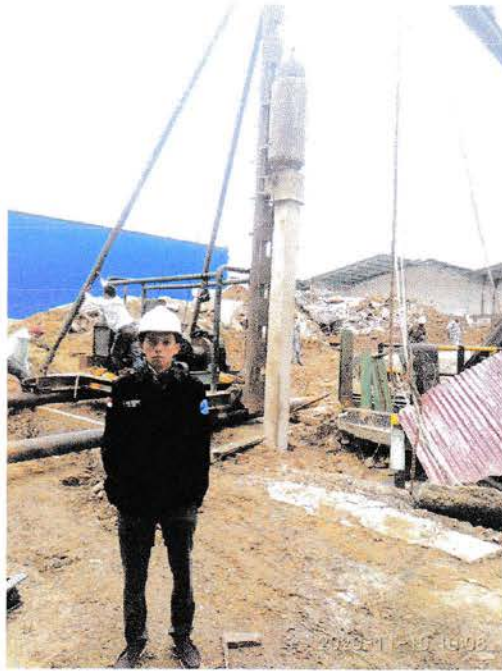
Pemasangan Tiang Pancang
