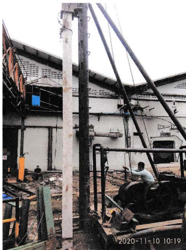
Gambar 4.11 Pemasangan tiang pancang
