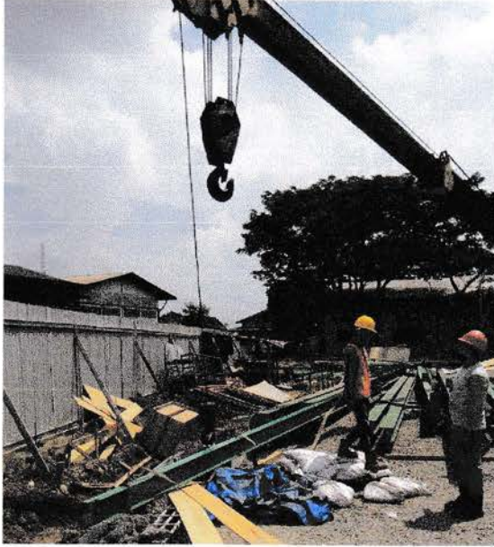
Gambar 4.28 Pemasangan Tali Pada Kolom Baja WF
