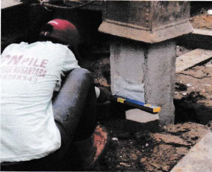
Gambar 4.13 Pengecekan penurunan tiang
