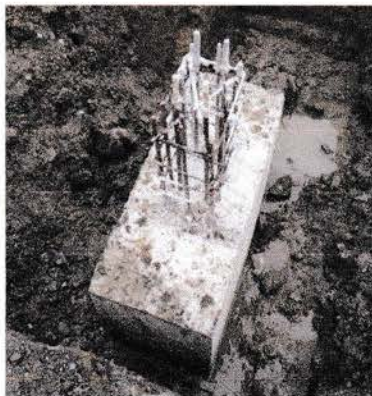
Gambar 4.15 Hasil dari pengecoran pilecap setelah bekisting dilepas
