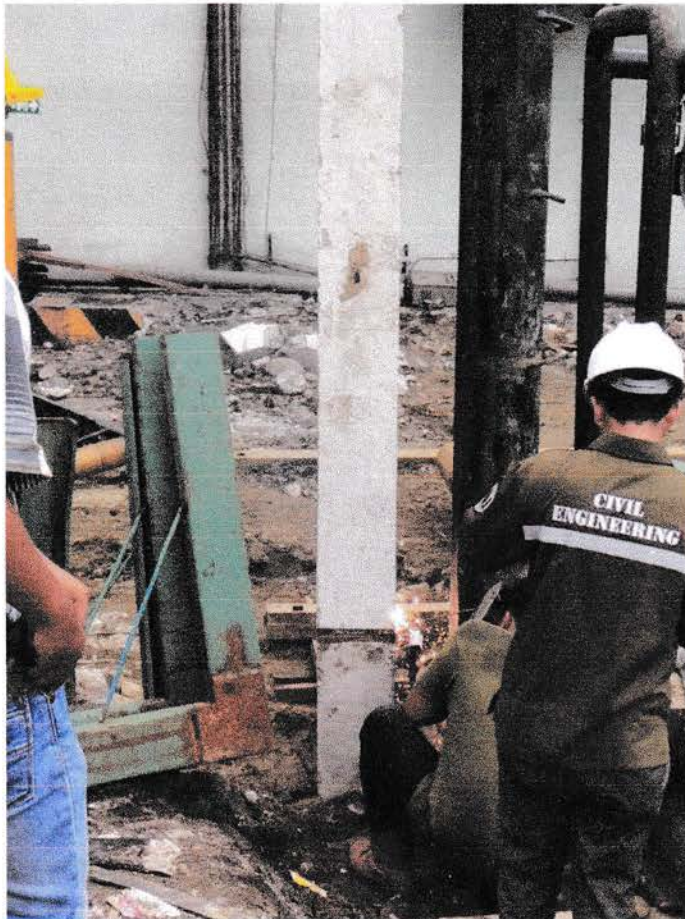
Gambar 4.12 Penyambungan tiang lower dan upper
