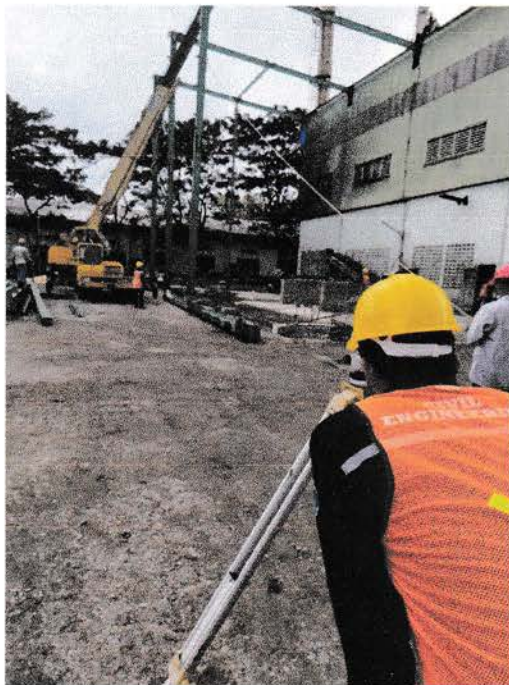
Menentukan elevasi menggunakan alat Waterpass
