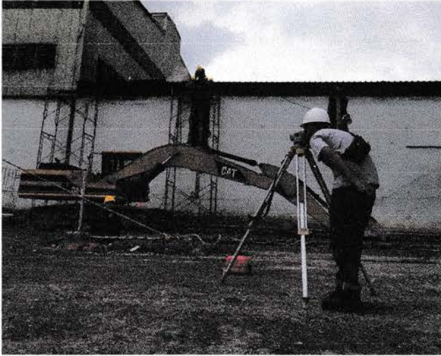
Gambar 4.27 Surveyor Mengecheck Elevasi Kolom
