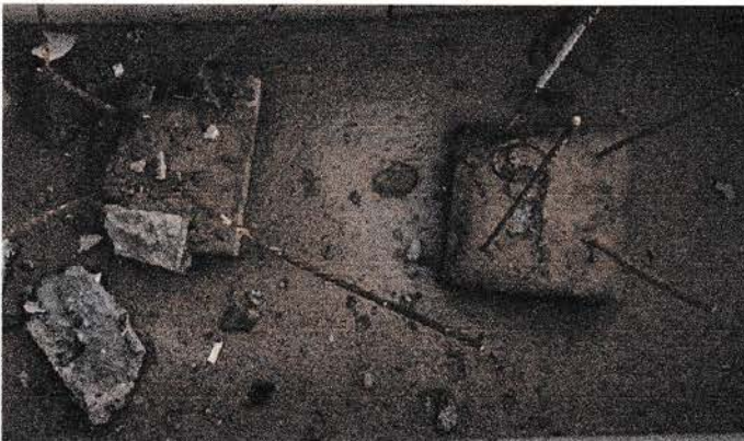
Gambar 4.16 Pembobokan tiang pancang
