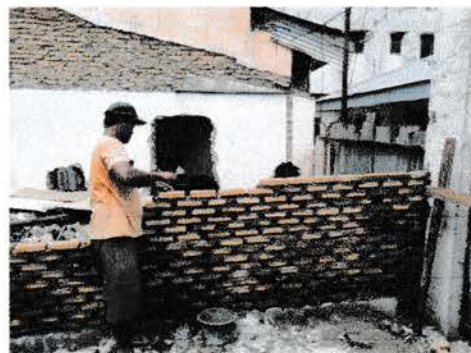
Gambar 4. Pemasangan Dinding bagian kamar
