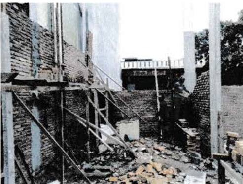
Gambar 3. Pemasangan Dinding bagian garasi
