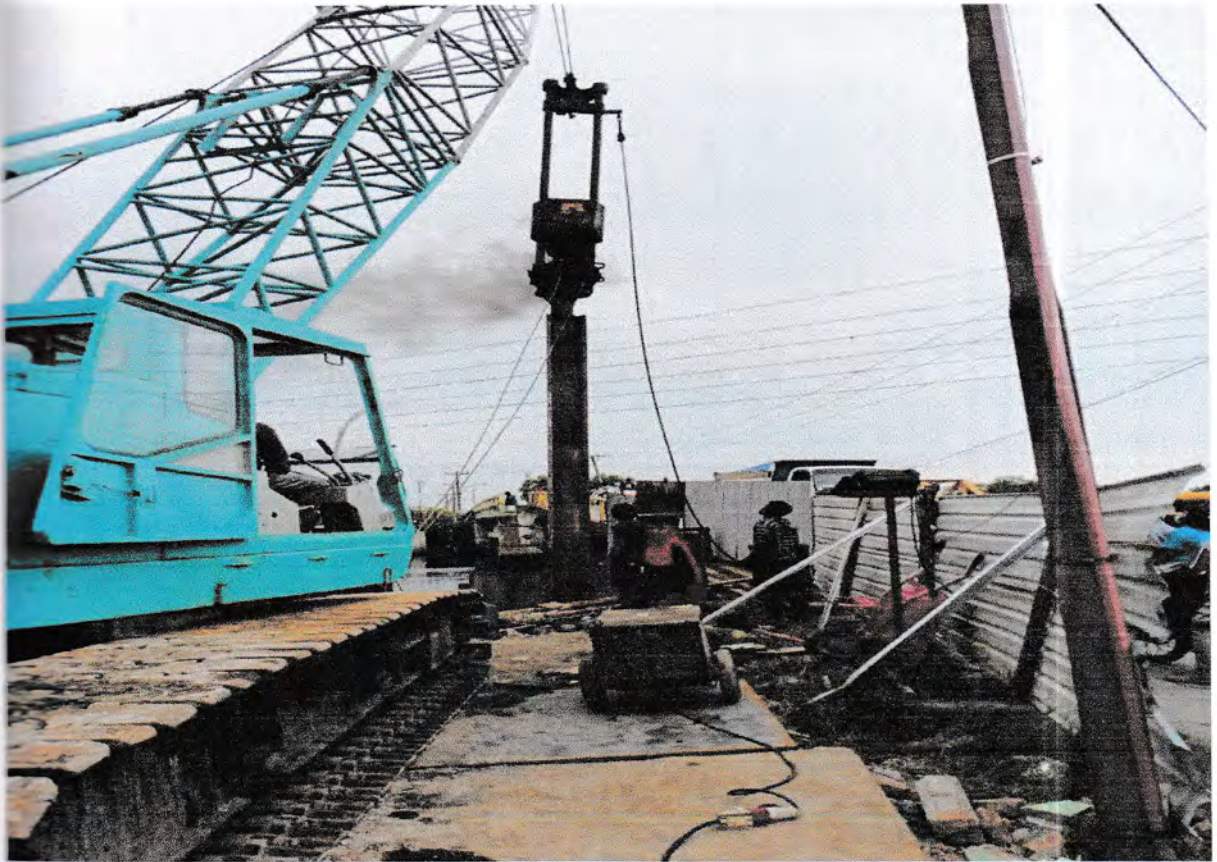
Gambar 3.3 crane yang digunakan dalam pelaksanaan proyek
