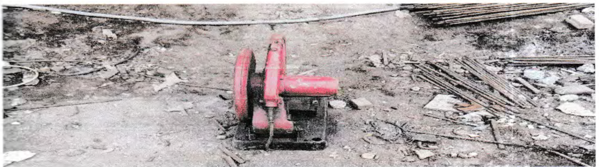
Gambar 3.8 bar cutter digunakan untuk memotong besi proyek
