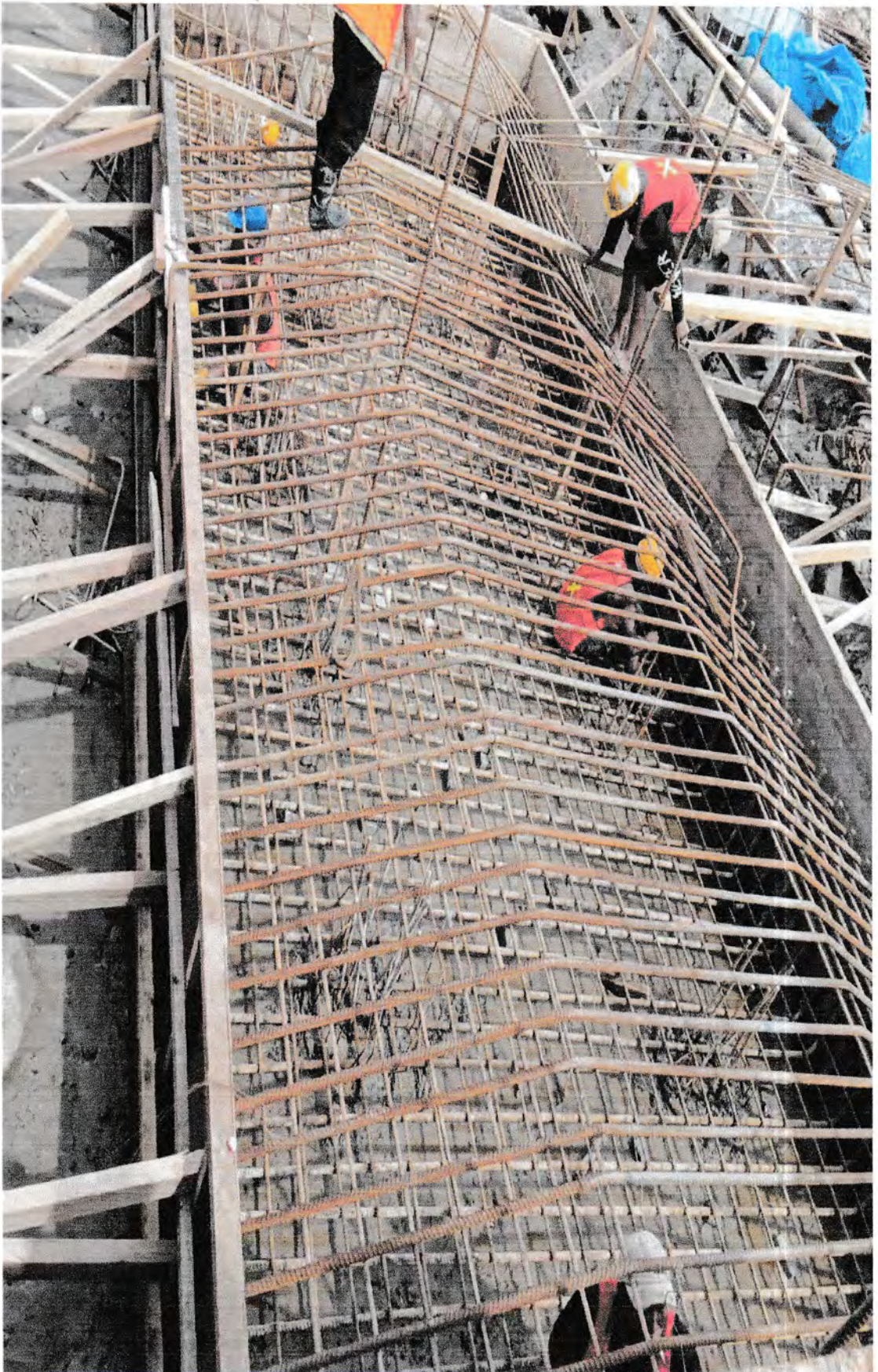
Gambar 4.5 proses pembesian.
