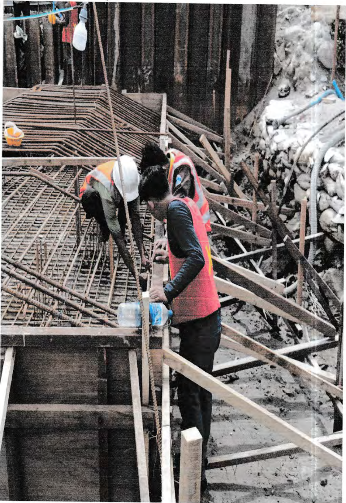
Gambar 4.7 proses pemasangan kawat baja.
