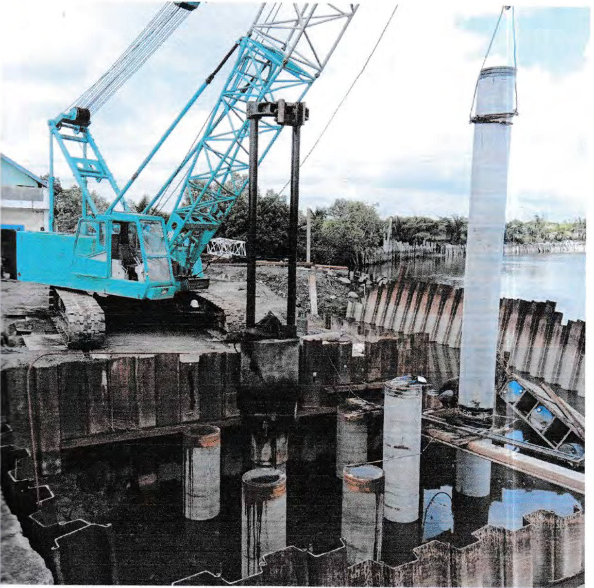
Gambar 4.1 Proses pemancangan tiang pancang menggunakan crane.
