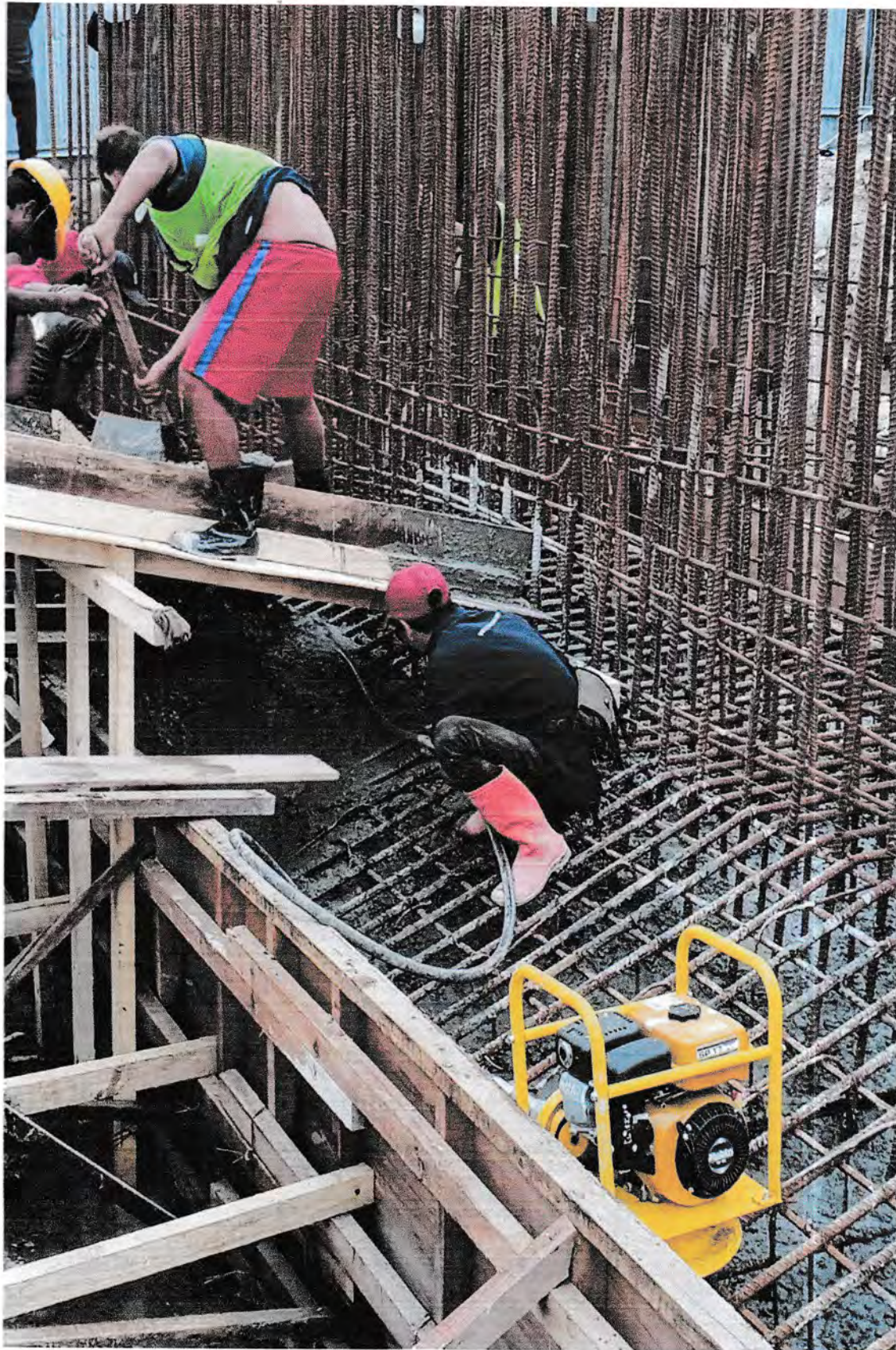
Gambar 4.10 Pemasangan beton dengan vibrator.
