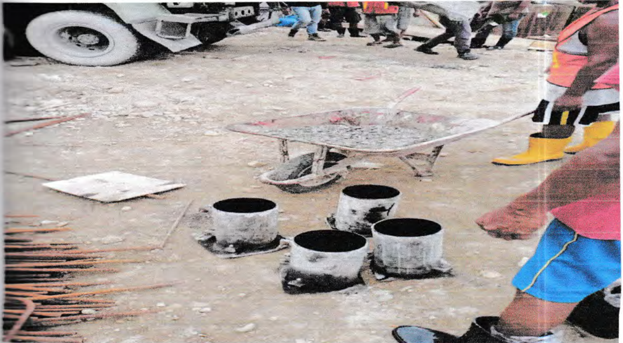
Gambar 3.11 Pembuatan Beton Untuk Diuji Kuat Tekan
