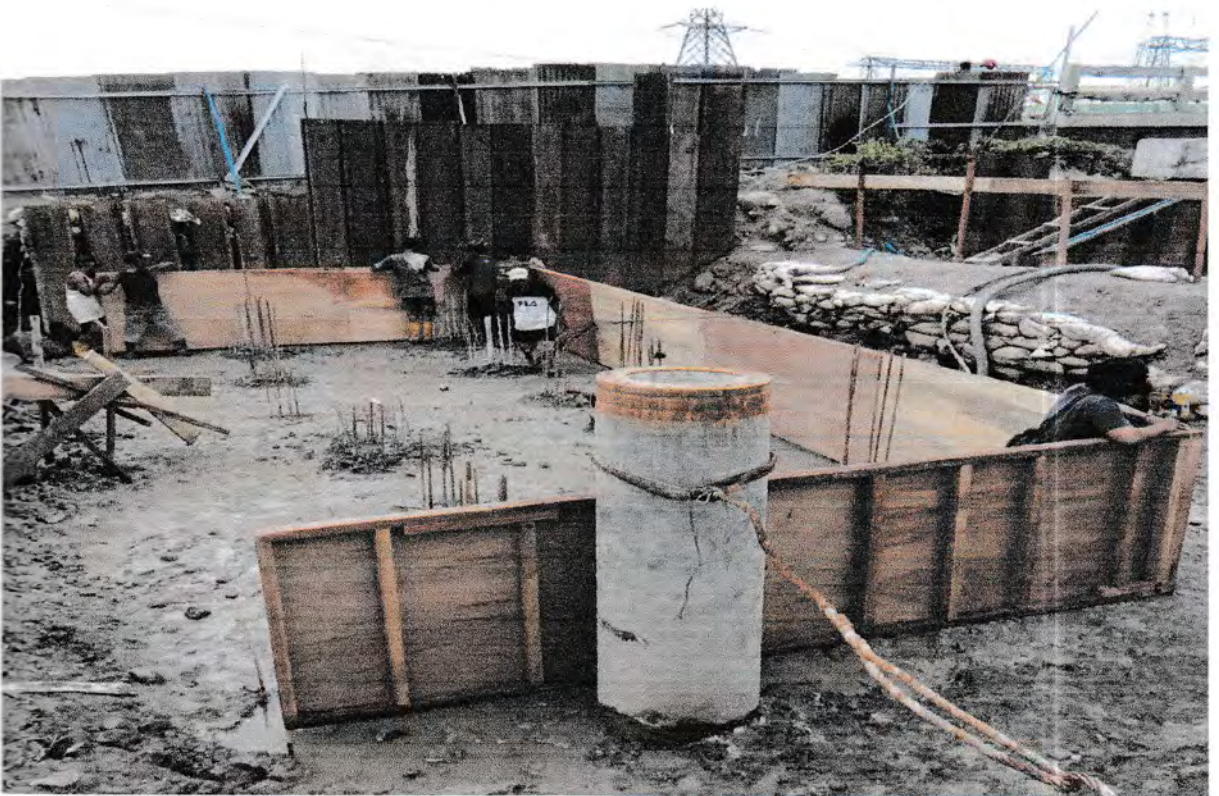
Gambar 4.4 Pemasangan Bekisting
