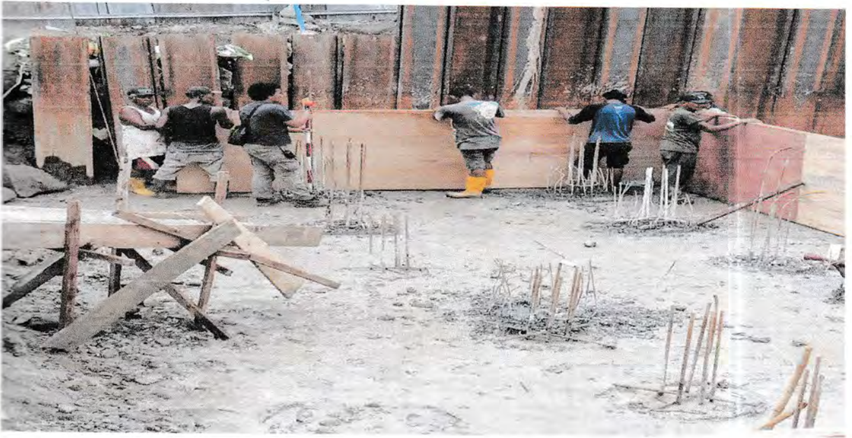
Gambar. 4.3 Pemasangan Bekisting
