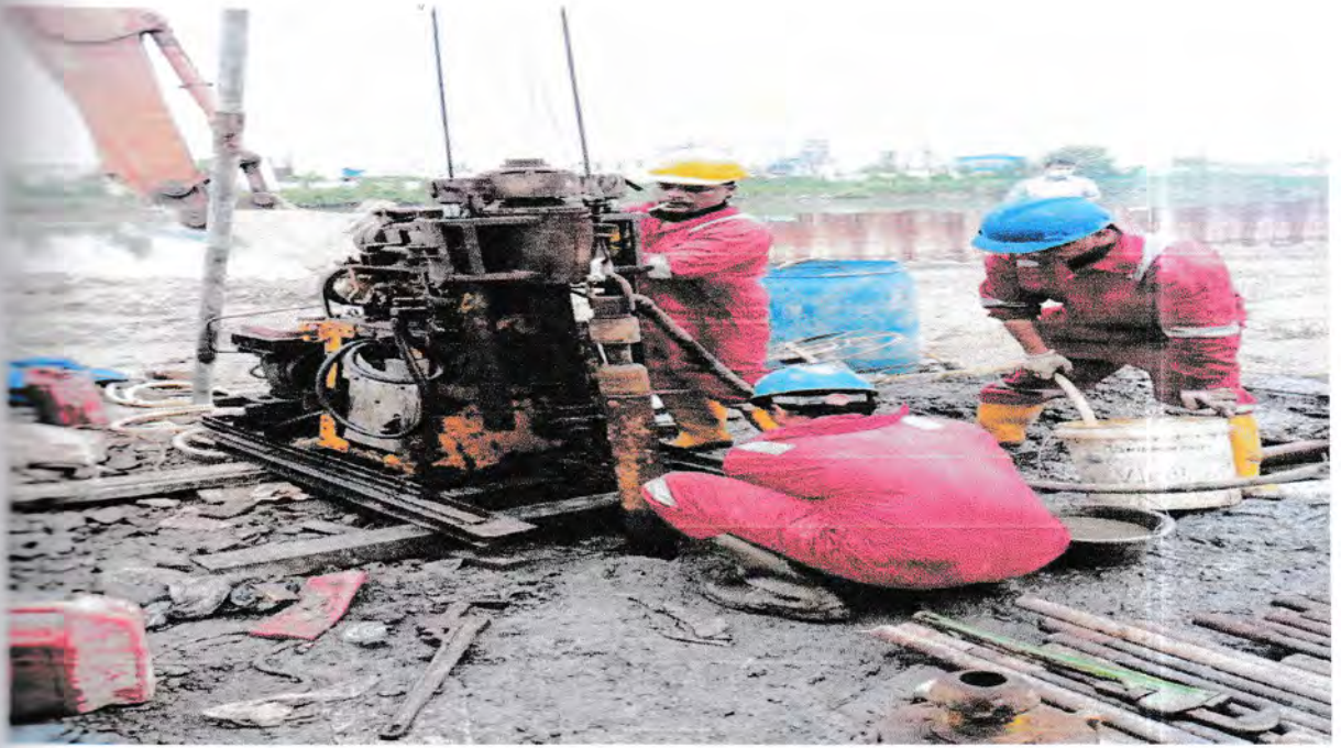
Gambar 3.4 mesin bor tanah yang digunakan untuk mengetahui kadar tanah.
