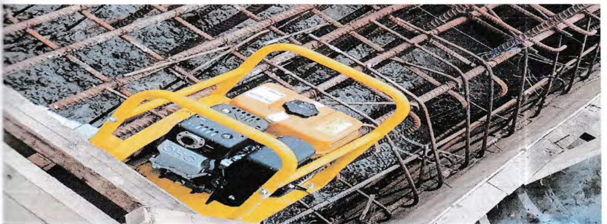
Gambar 3.5 vibrator yang digunakan untuk memecah dan memadatkan beton
