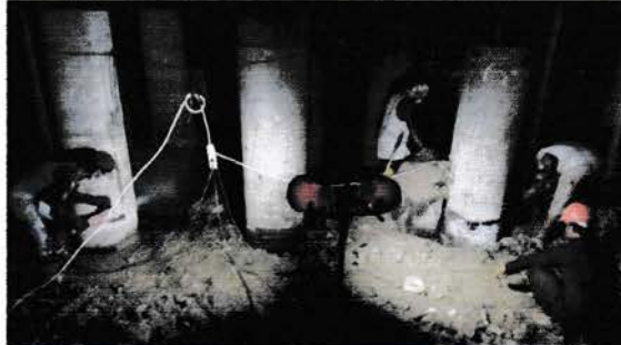
Gambar 4.5 Pemotongan Tiang Pancang Beton (Sumber: data lapangan)
