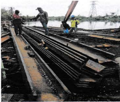
Gambar 3.14 Sheet pile baja
