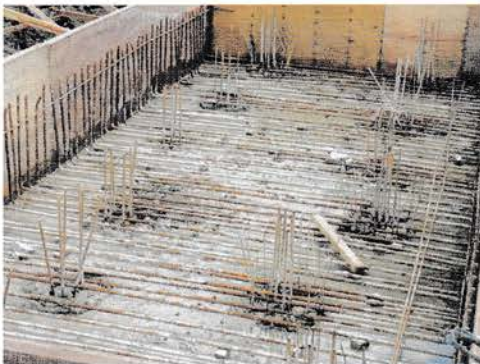
Gambar 4.8 Penulangan box culvert (Sumber: data lapangan)
