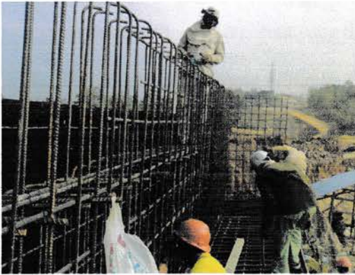
Gambar 4.11 Pekerjaan Penulangan pada Kepala Abutment (Sumber: data lapangan)
