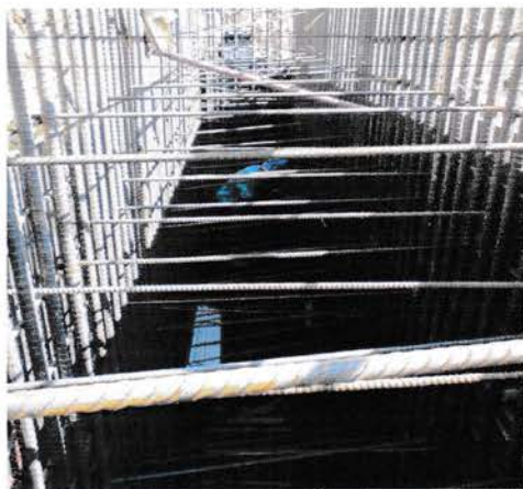
Gambar 4.9 Penulangan Pada Dinding Abutment (Sumber: data lapangan)
