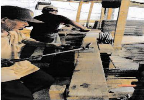
Gambar 3.4 Bar bending (Sumber: data lapangan)
