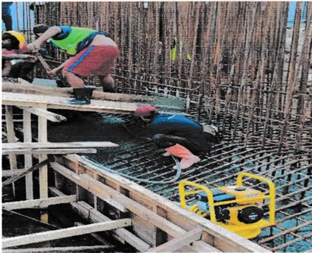
Gambar 4.12 Pekerjaan pengecoran (Sumber: data lapangan)
