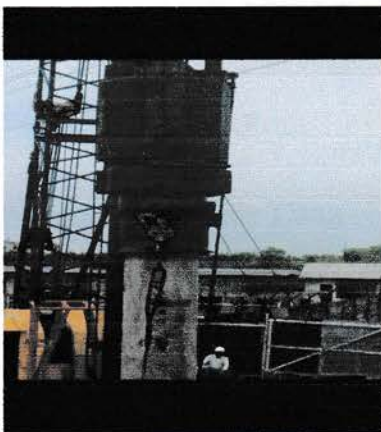
Gambar 4.3 Memasukan Tiang Pancang Beton
