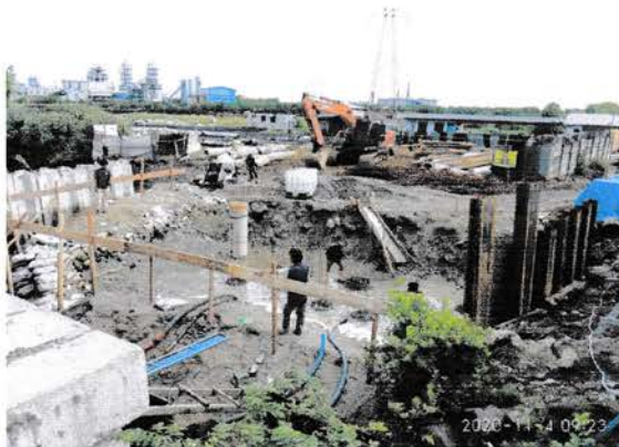
Gambar 4.6 Penambahan Tulangan Auxiliary Steel Bars (Sumber: data lapangan)
