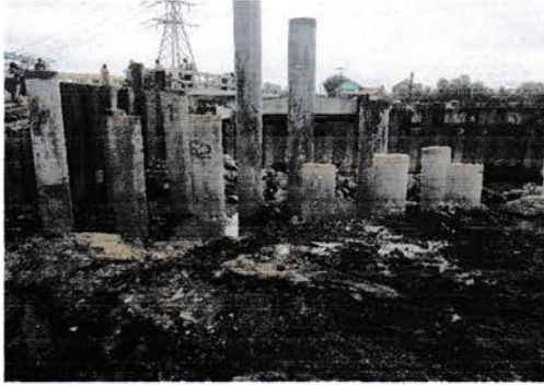
Gambar 3.13 Tiang pancang beton (Sumber: data lapangan)
