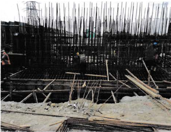
Gambar 4.10 Penulangan pada Wing Wall Abutmen
