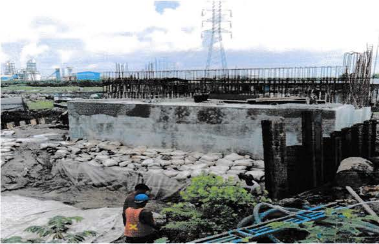
Gambar 4.13 Pembongkaran bekisting (Sumber: data lapangan)
