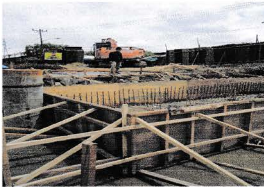
Gambar 4.7 Pengerjaan bekisting (Sumber: data lapangan)
