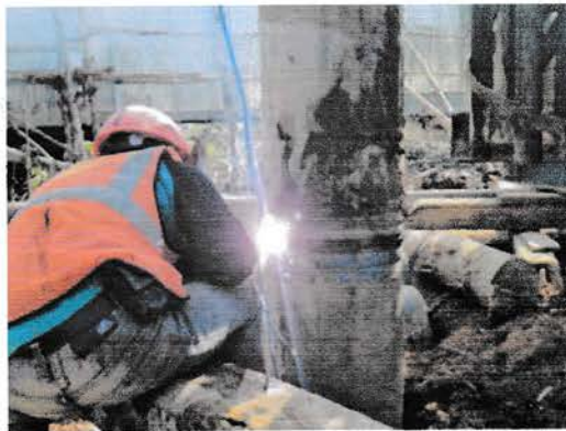
Gambar 4.4 Penyambungan Tiang Pancang Beton (Sumber: data lapangan)
