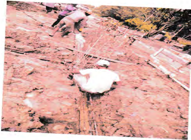
(Gambar 3.20 proses pemasangan sloof)
