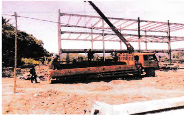
(Gambar 3.1.5 Truk crane)
