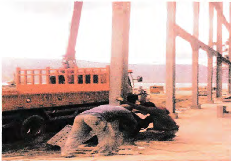
(Gambar 3.2.9 proses pemasangan kolom)
