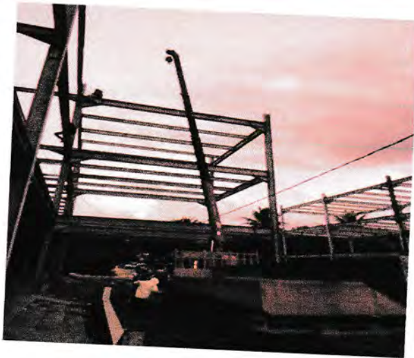
(Gambar 3.2.10 proses pemasangan balok)
