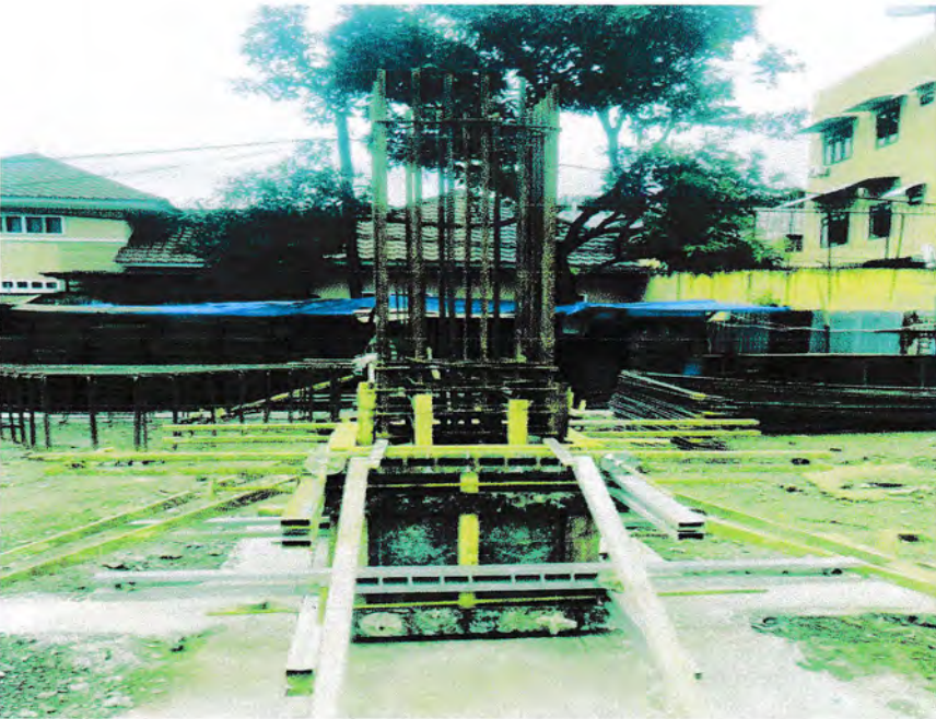
Gambar 2 bekisting kolom
