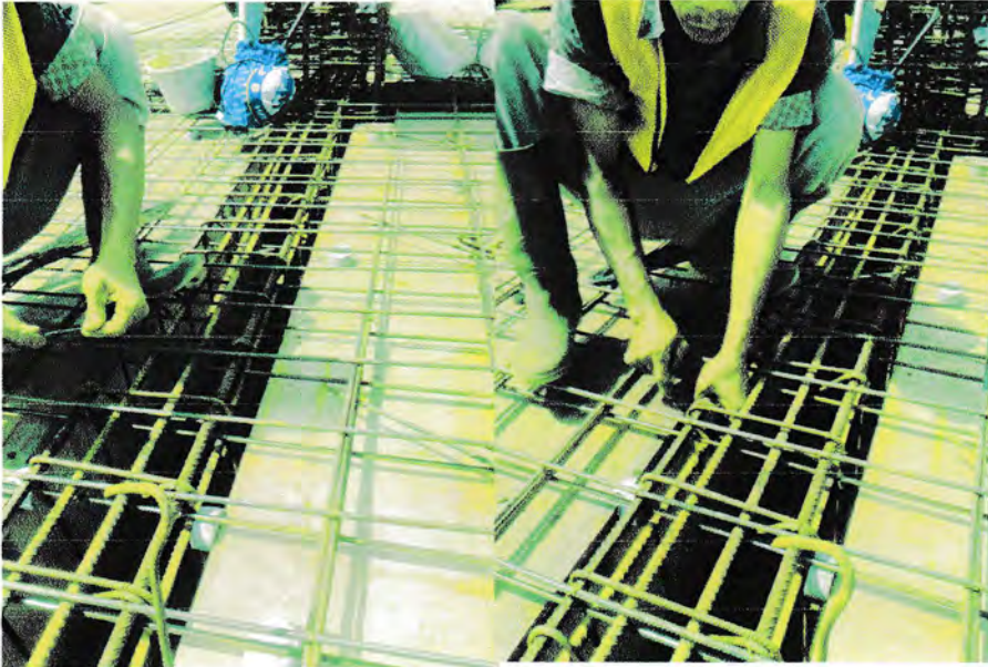
Gambar 4.3 Rakit pembesian dengan kawat
