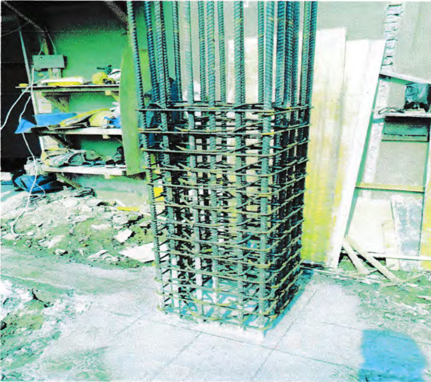
Gambar 1 Penulangan Kolom
