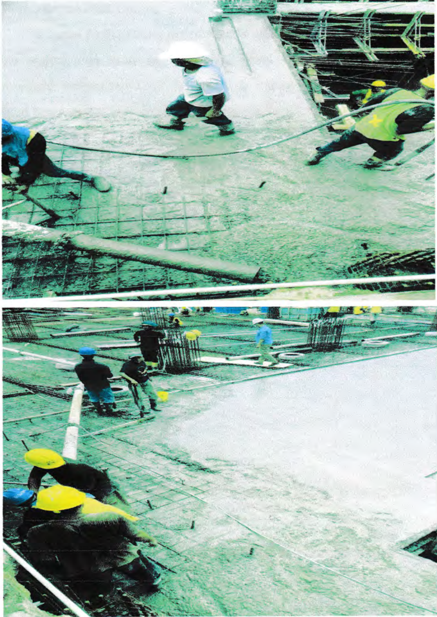
Gambar 4.7 Pekerjaan Pengecoran
