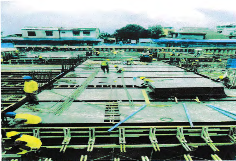
Gambar 4 Pemasangan Bekisting Lantai
