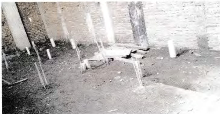
Gambar III.4 Besitulangan Kolom Praktis pada kamar mandi
