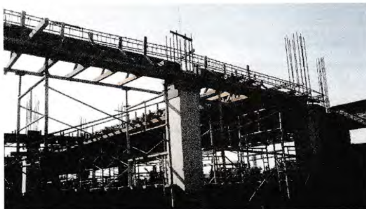
Gambar III.9 Pengerjaan sambungan Kolom dan balok sloof
