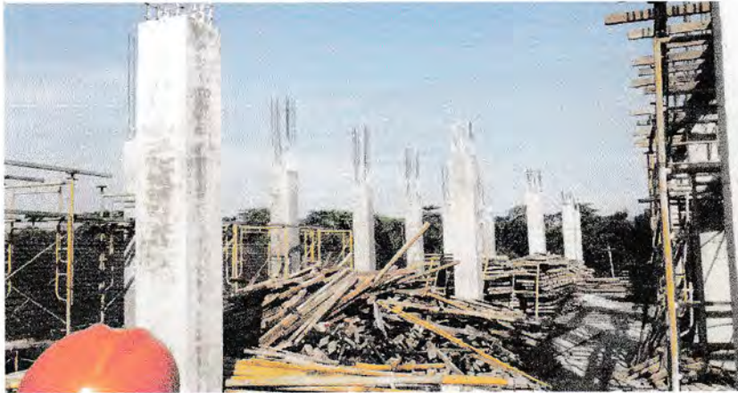
Gambar III.8 Kondisi Kolom bangunan setelah 28 hari.
