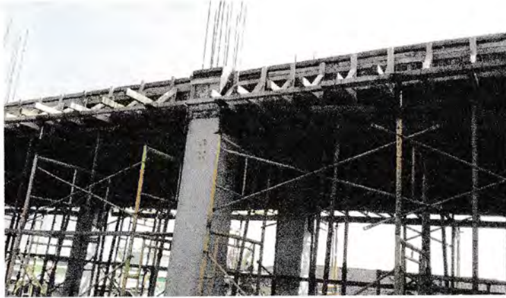
Gambar III.10 Pengerjaan sambungan Kolom dan Plat lantai
