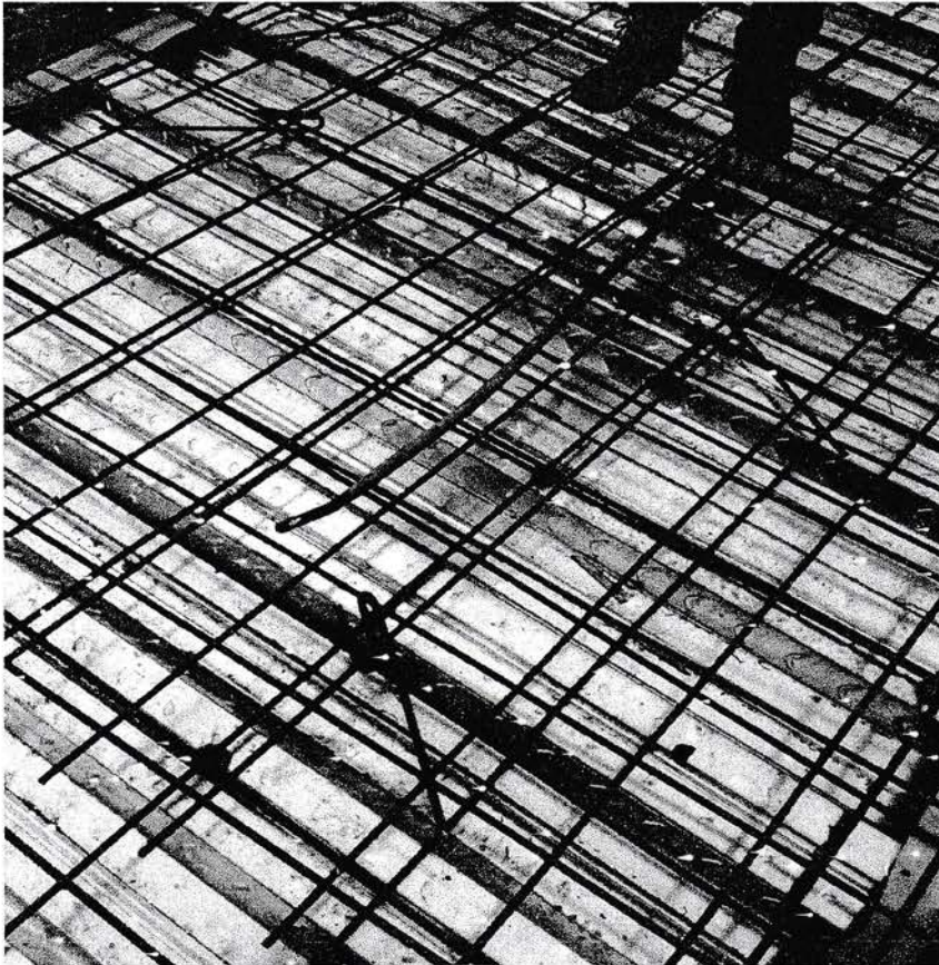
Gambar 3.12 Pembesian Plat Lantai
