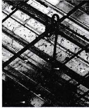
Gambar 3.20 Tulangan plat lantai
