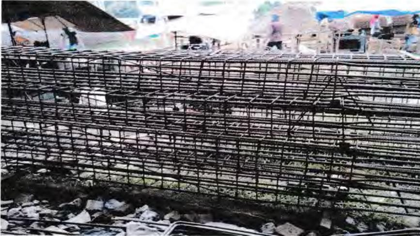
Gambar 3.17 Pekerjaan pemotongan dan pembungkakan tulangan
