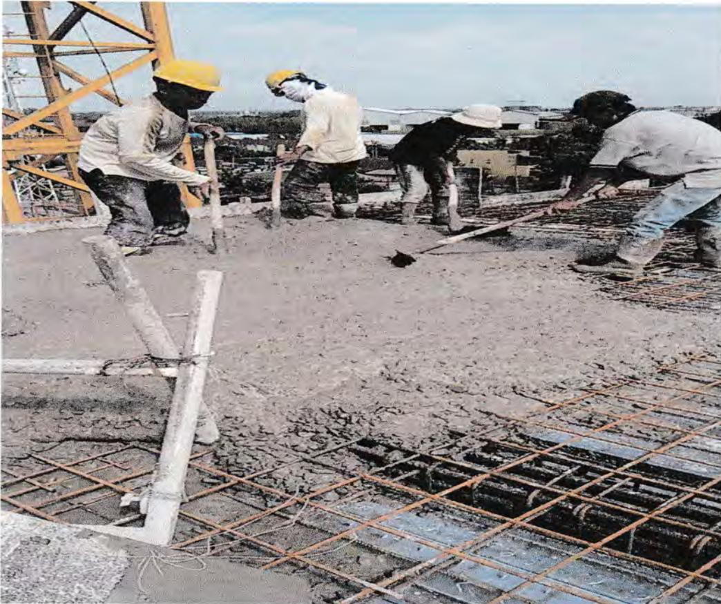
Gambar 3.13 Pengecoran Plat Lantai
