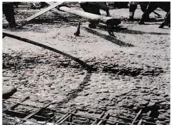
Gambar 3.3 Mesin Vibrator
