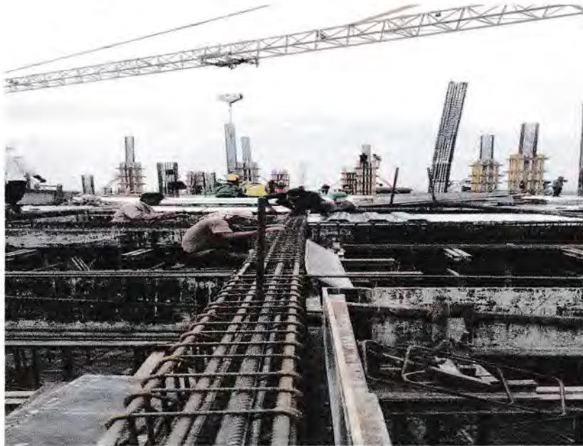
Gambar 3.11 Pemasangan Bekisting Balok dan Plat Lantai
