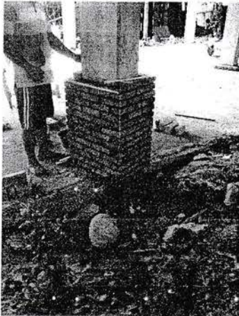
Gambar : 3.6. Pemasangan Bata Ekspos (Sumber : Doc. Pribadi, 2017)
