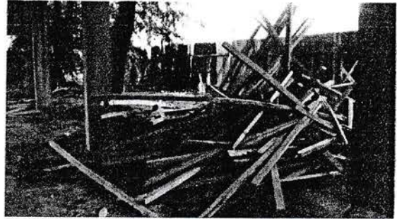
Gambar : 3.3. Pembongkaran (Sumber : Doc. Pribadi, 2017)
