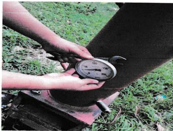
4.2.2.3 Pemasangan thermometer
