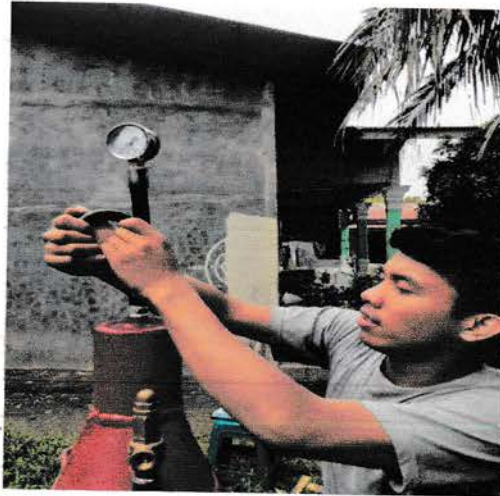
Gambar 4.2.2.4 Pemasangan sippon dan presure gauge
