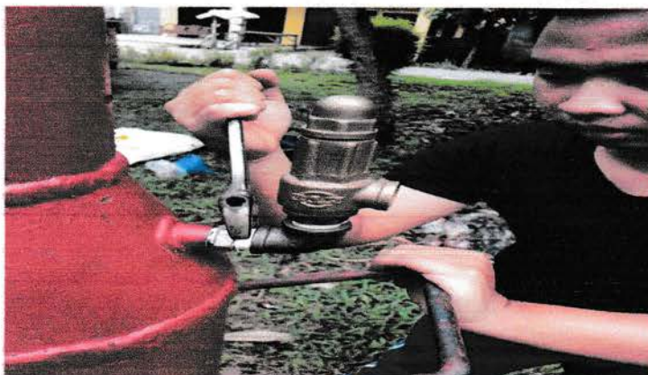
Gambar 4.2.2.1 Pemasangan safety valve
