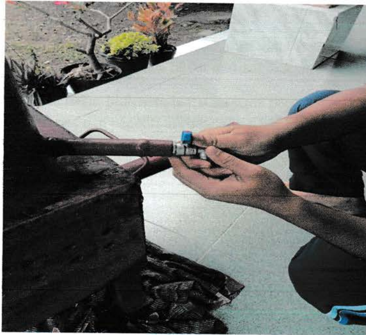
Gambar 4.2.2.6 pemasangan kran air
