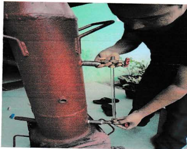
Gambar 4.2.2.5 pemasangan kaca sight glass
