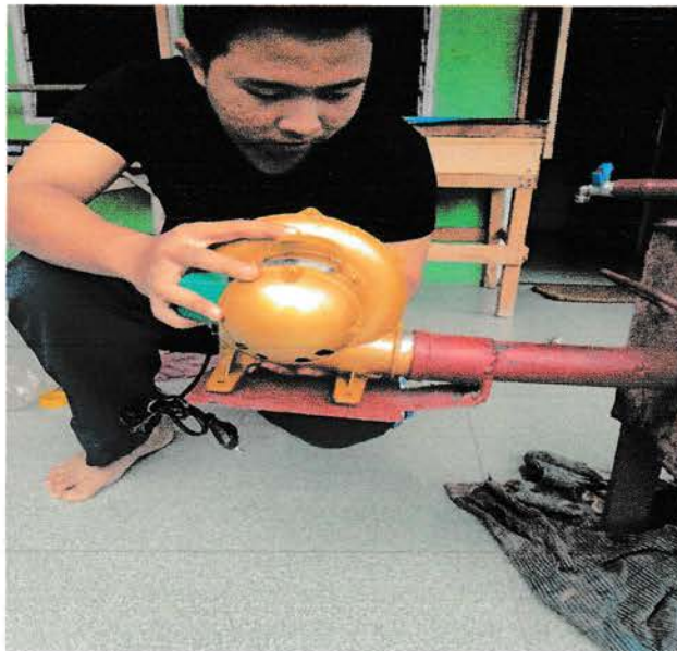
Gambar 4.2.2.7 pemasangan blower pada ruang bakar
