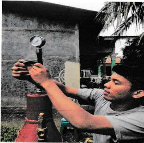
Gambar 4.2.2.4 Pemasangan sippon dan presure gauge
