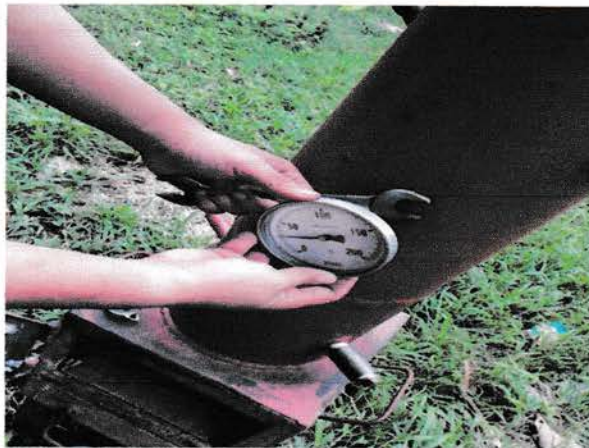
4.2.2.3 Pemasangan thermometer
