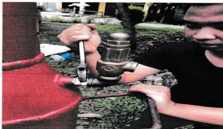
Gambar 4.2.2.1 Pemasangan safety valve
