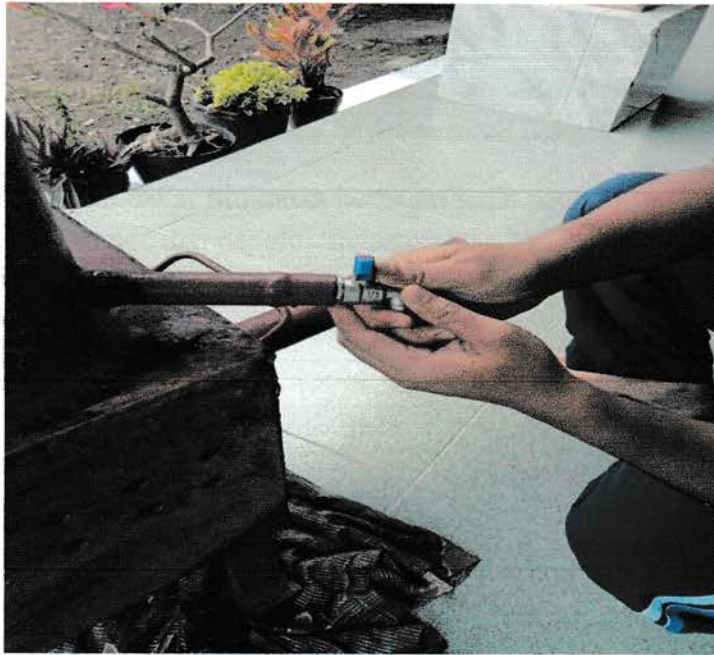
Gambar 4.2.2.6 pemasangan kran air
