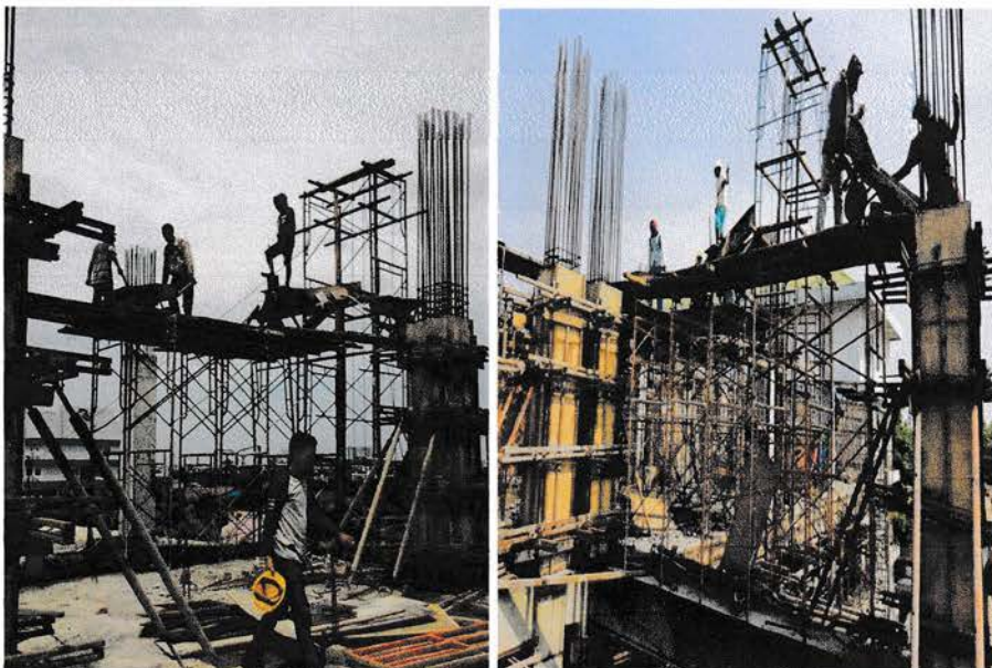
Gambar 3.2.3. Pengecoran Kolom
