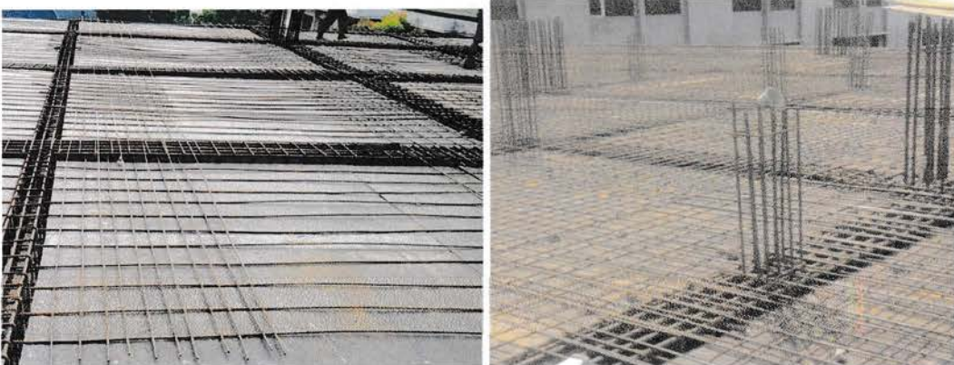
Gambar 3.2.9. Penulangan Plat Lantai
