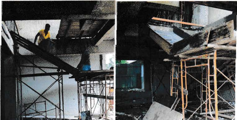
Gambar 3.2.14. Bekisting Tangga
