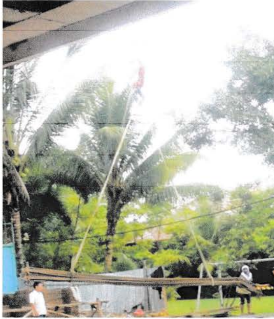
Gambar 3.2.7. Proses Pengangkatan Besi Tulangan
