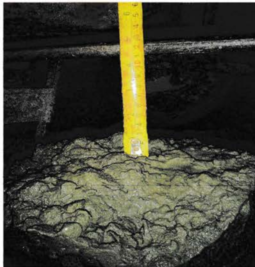
Gambar 3.2.10. Pengecekan nilai slump
