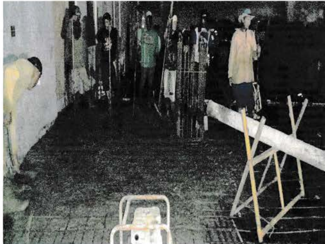
Gambar 3.2.13. Perataan Beton
