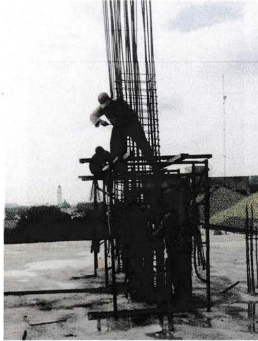
Gambar 3.2.1. Penulangan kolom
