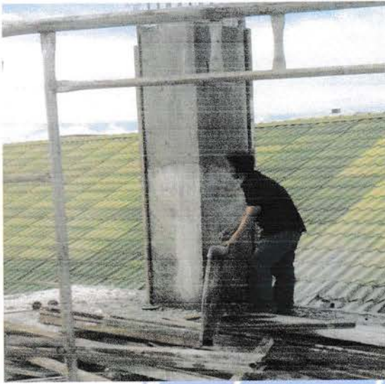
Gambar 1 : Pembongkaran bekisting kolom
