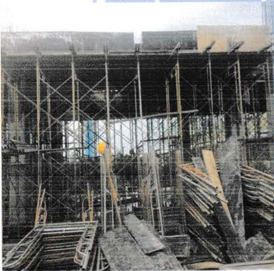
Gambar 3 : pemasangan bekisting balok
