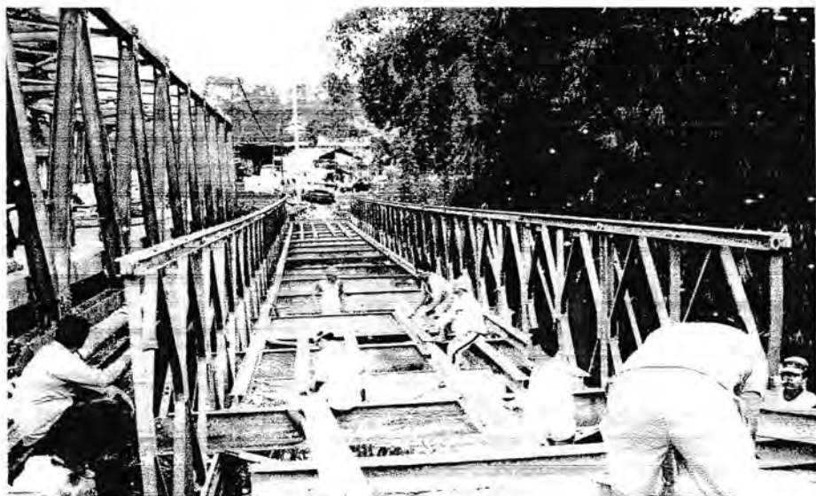
Gambar 3.1. Perbaikan Lantai Jembatan Sementara
