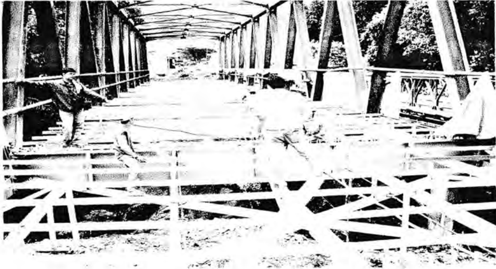
Gambar 3,5, Pekerjaan Pemasangan Begisting
