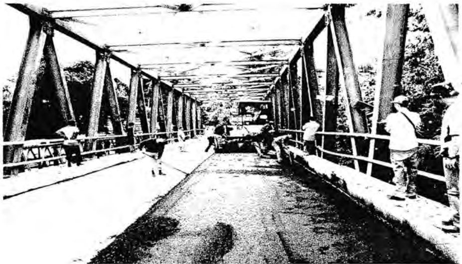
Gambar 3.11 Pekerjaan pengaspalan badan jembatan
