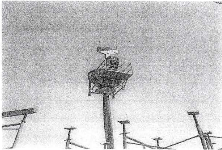
Gambar 5.6 : Pengecoran kolom dengan bucket cor
