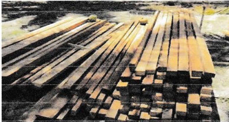
Gambar Kayu Perancah Sumber: Data Lapangan 2016
