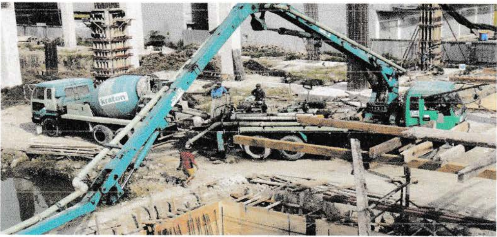
Gambar Concret Pump Sumber : Data Lapangan 2016
