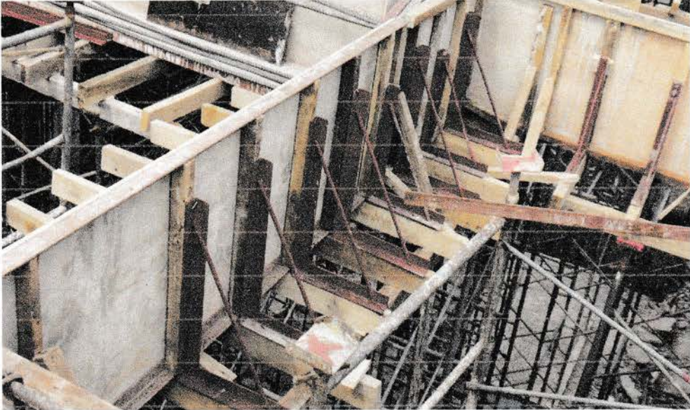
Gambar Bekesting Plat Lantai Sumber : Data Lapangan 2015
