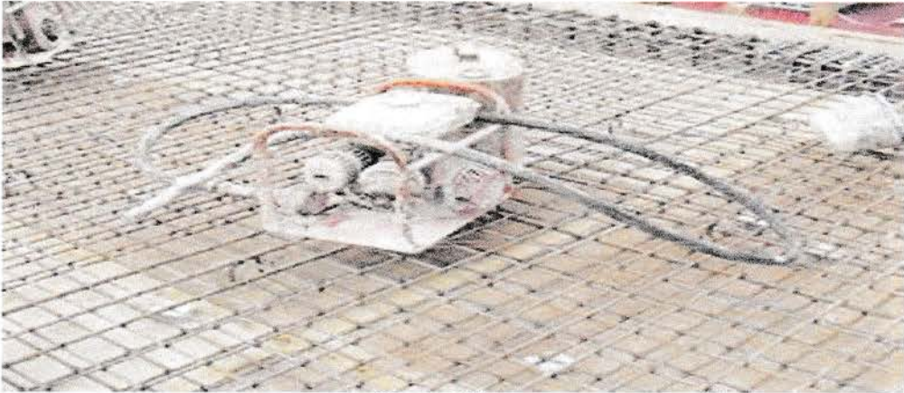
Gambar Vibrator Sumber : Data Lapangan 2016
