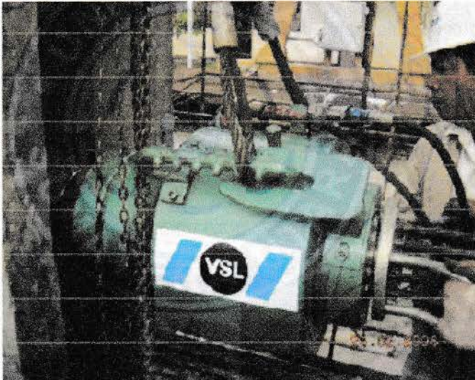
Gambar Hydrolic Jack SA 507 / ZPE – 7 / A (7S) Sumber : Data Lapangan 2016
