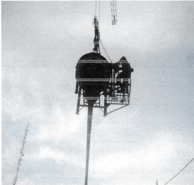
Gambar Bucket Cor Sumber : Data Lapangan 2016
