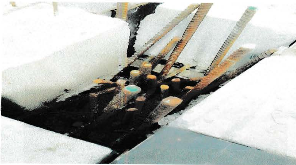
Gambar 2.6.4. Titik kumpul balok precast
