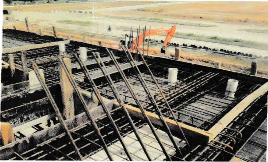
Gambar 2.7.2. Bekisting di posisi kamar mandi yang dilakukan pengecaoran balok Konvensional
