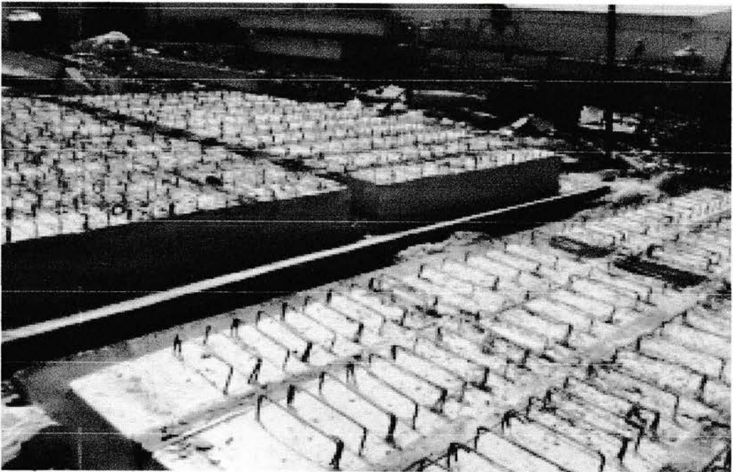
Gambar 4 . Balok Induk pecast siap dalam pengangkutan.
