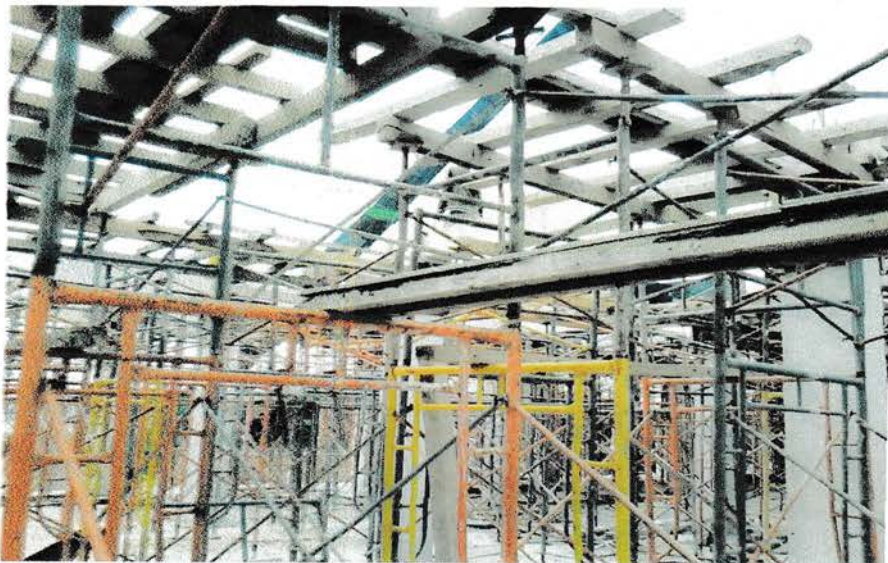
Gambar 2.7.1. Rekskapolding yang sudah dipasang dalam pembuatan Bekisting
