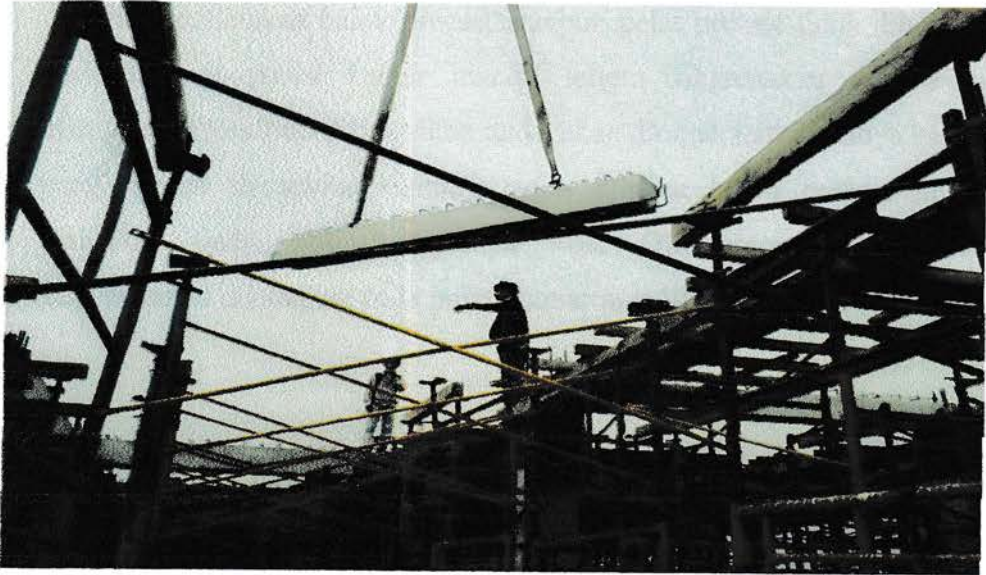
Gambar 2.6.3. proses perletakan balok precast
