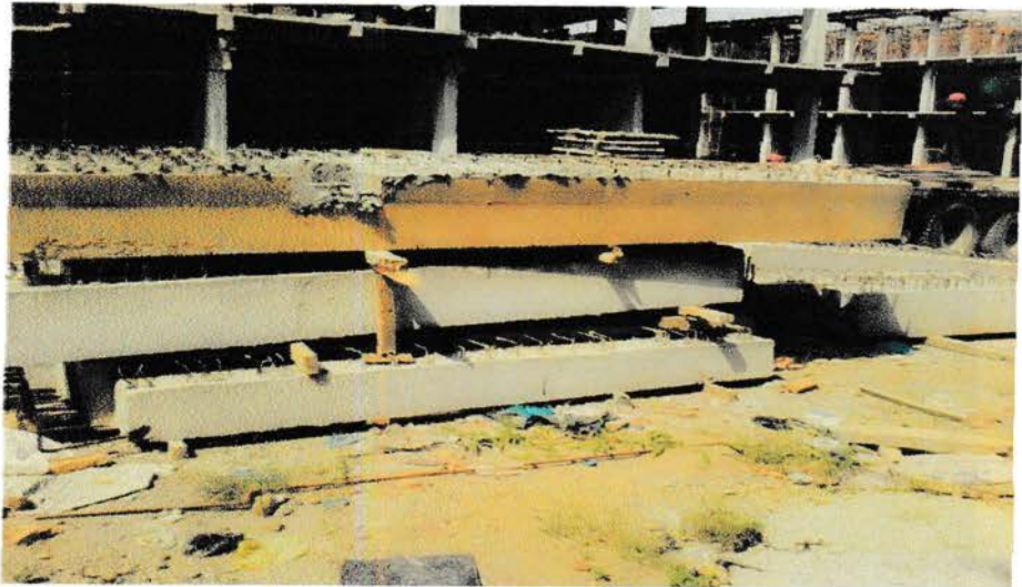
Gambar 2.6.1. beton precast siap dipasangkan pada konstruksi
