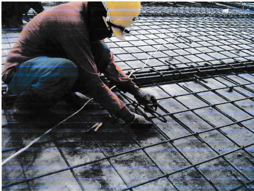
Gambar Pembesian Plat Lantai
