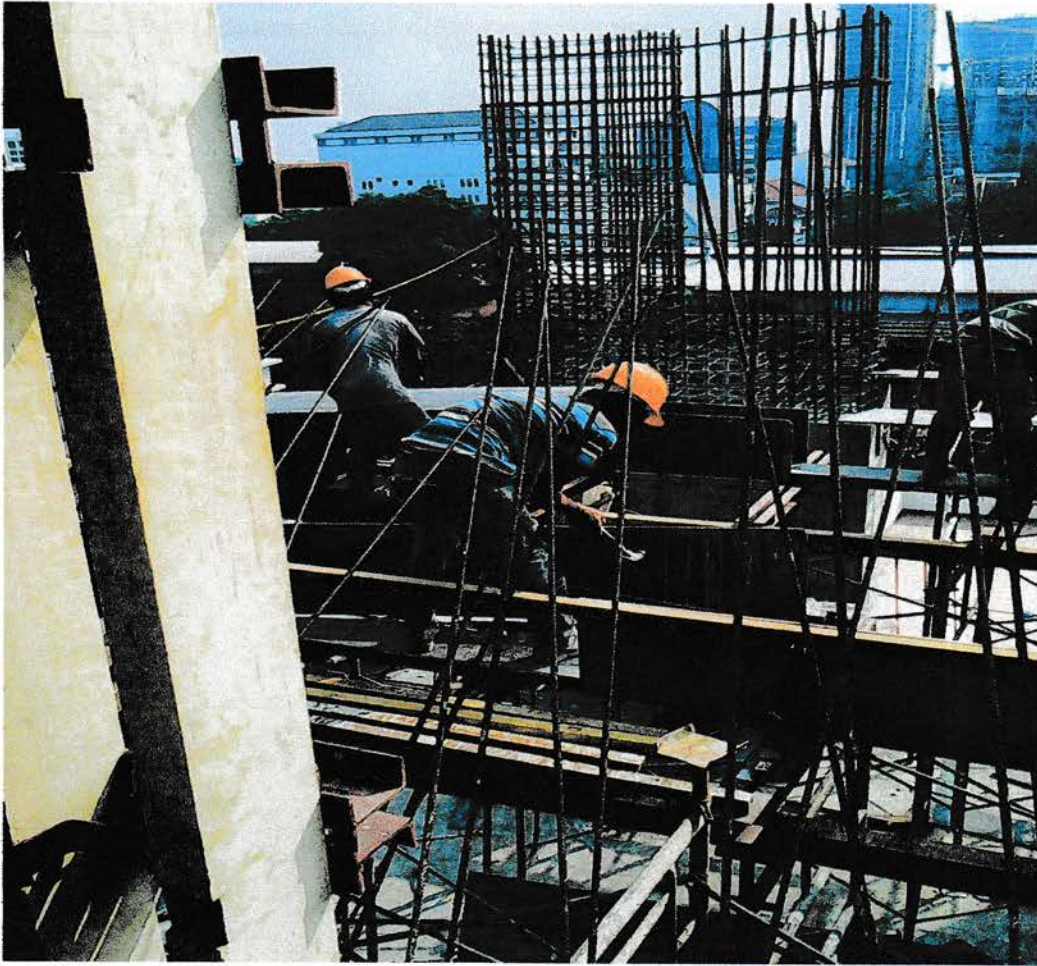
Gambar 3.13 Pemasangan Bekisting Balok dan Plat Lantai
