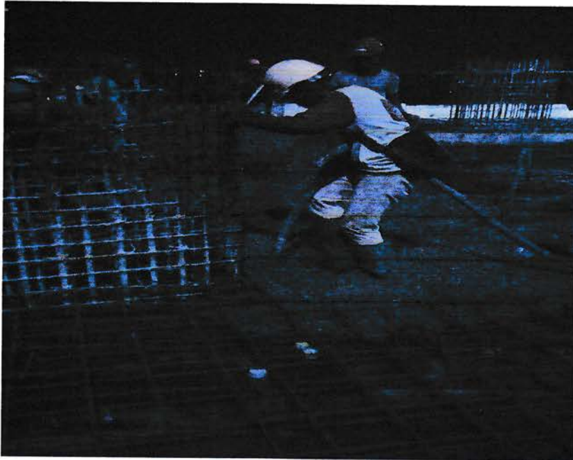
Gambar Pengecoran Plat Lantai
