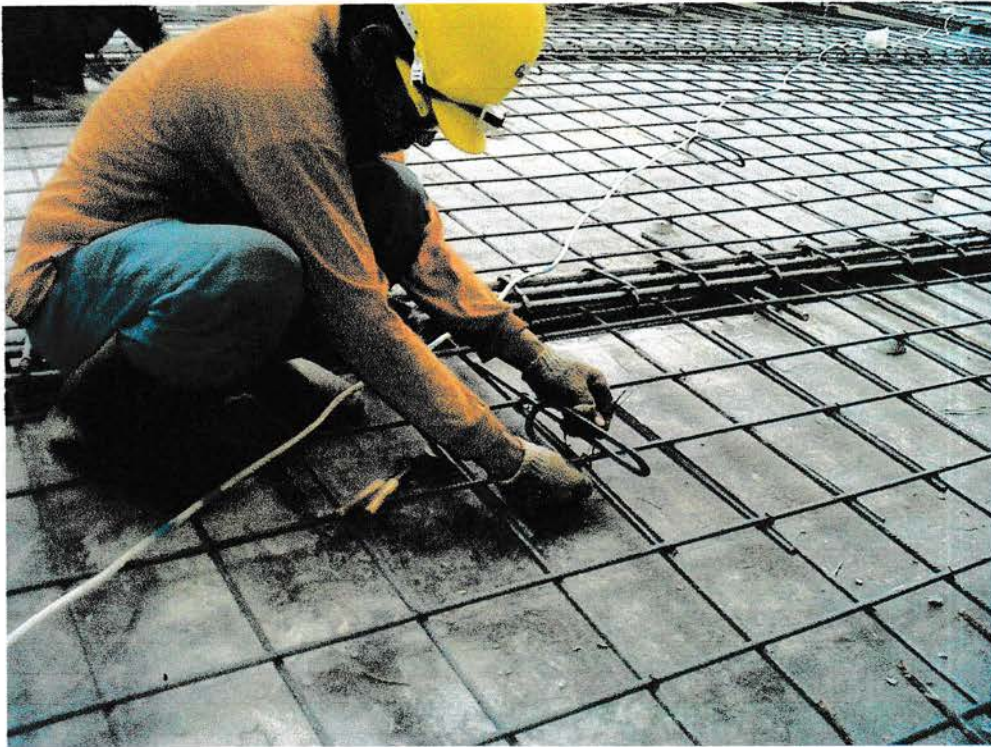
Gambar 3.14 Pembesian Plat Lantai
