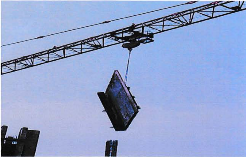
Gambar Pengangkatan Bekisting Kolom
