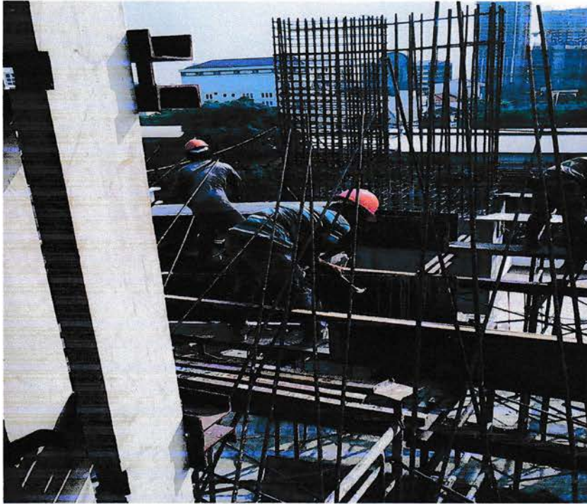
Gambar Pemasangan Bekisting Balok dan Plat Lantai
