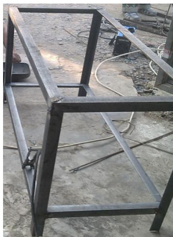
Gambar 3.2 pembuatan tiang alat uji
