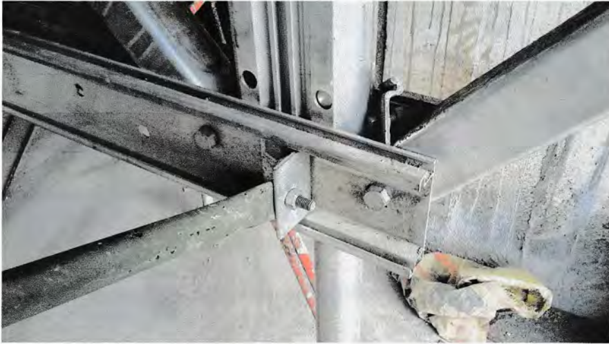
Gambar 4.26 Bekisting Lantai Sumber : Dari lapangan Tahun 2015
