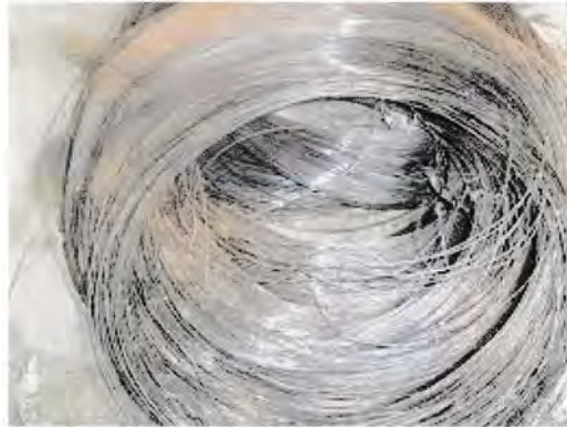
Gambar 4.7 Kawat Beton Sumber : Dari lapangan Tahun 2015
