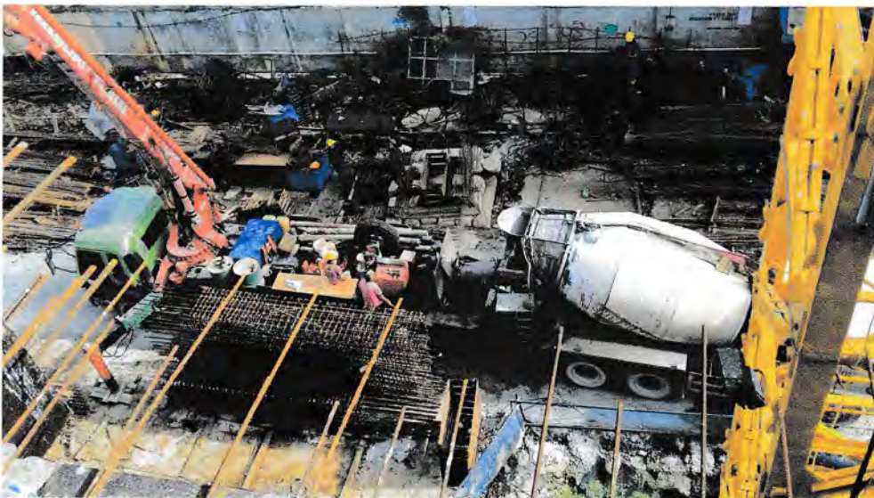
Gambar 4.6 Beton ready mix (Semen Merah Putra, Kraton)
