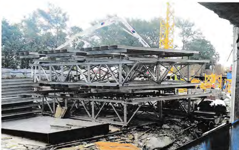
Gambar 4.17 Scaffolding Sumber : Dari lapangan Tahun 2015 Universitas Medan Area
