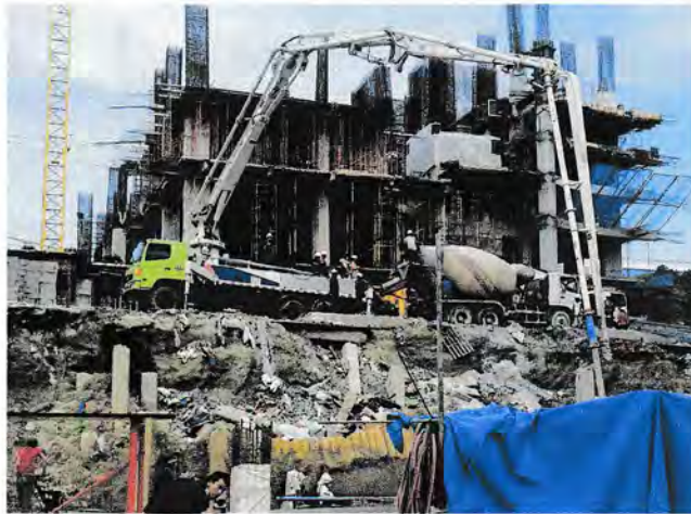
Gambar 4.16. Concret Pump Sumber : Dari lapangan Tahun 2015
