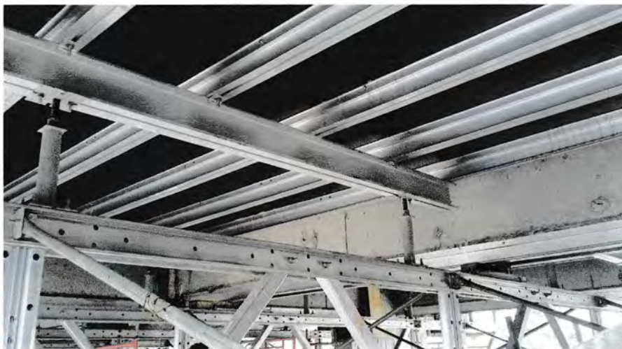
Gambar 4.25 Bekisting Lantai Sumber : Dari lapangan Tahun 2015 Universitas Medan Area
