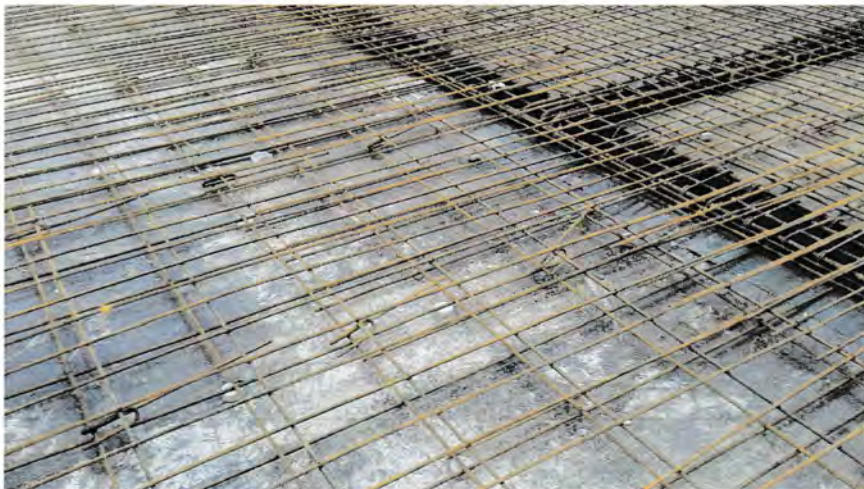
Gambar 4.31 Pembesian Plat Lantai Sumber : Dari lapangan Tahun 2015
