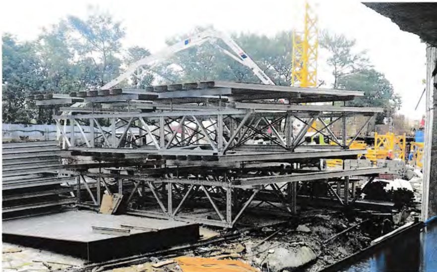
Gambar 4.23 Bekisting Lantai Sumber : Dari lapangan Tahun 2015
