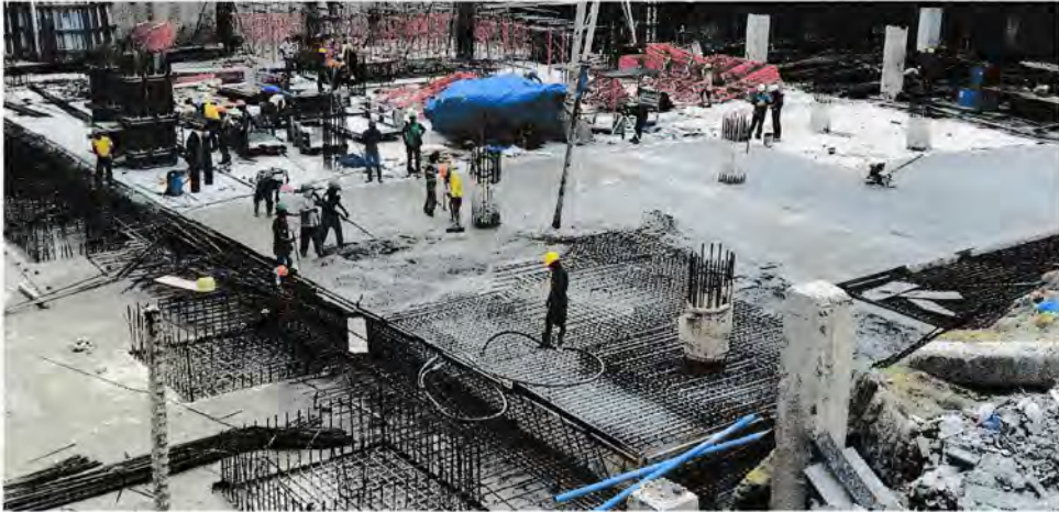
Gambar 4.30 Pengecoran Plat Lantai Sumber : Dari lapangan Tahun 2015
