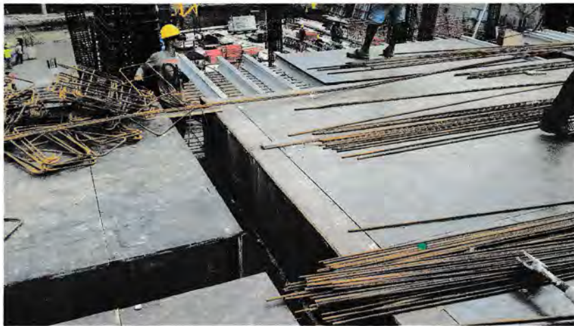
Gambar 4.29 Bekisting Plat Lantai Sumber : Dari lapangan Tahun 2015
