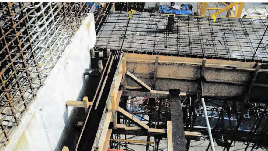
Gambar 4.28 Bekisting Baja ringan & Kayu Sumber : Dari lapangan Tahun 2015 Universitas Medan Area
