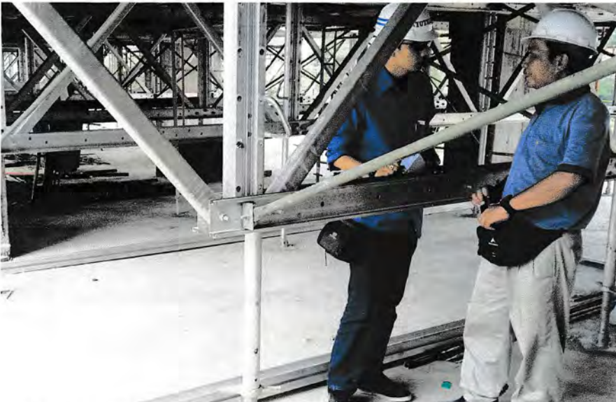
Gambar 4.27 Bekisting Lantai Sumber : Dari lapangan Tahun 2015
