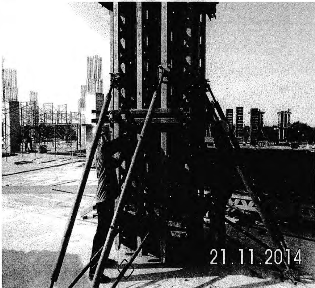
Gambar 5. Pemasangan Bakisting Kolom
