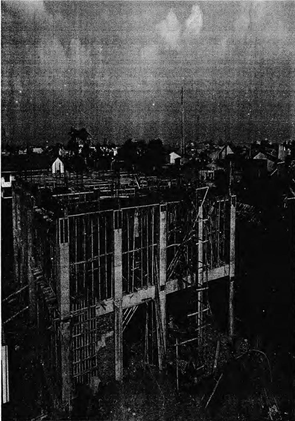
Gambar 20. Kolom Selesai Akhir
