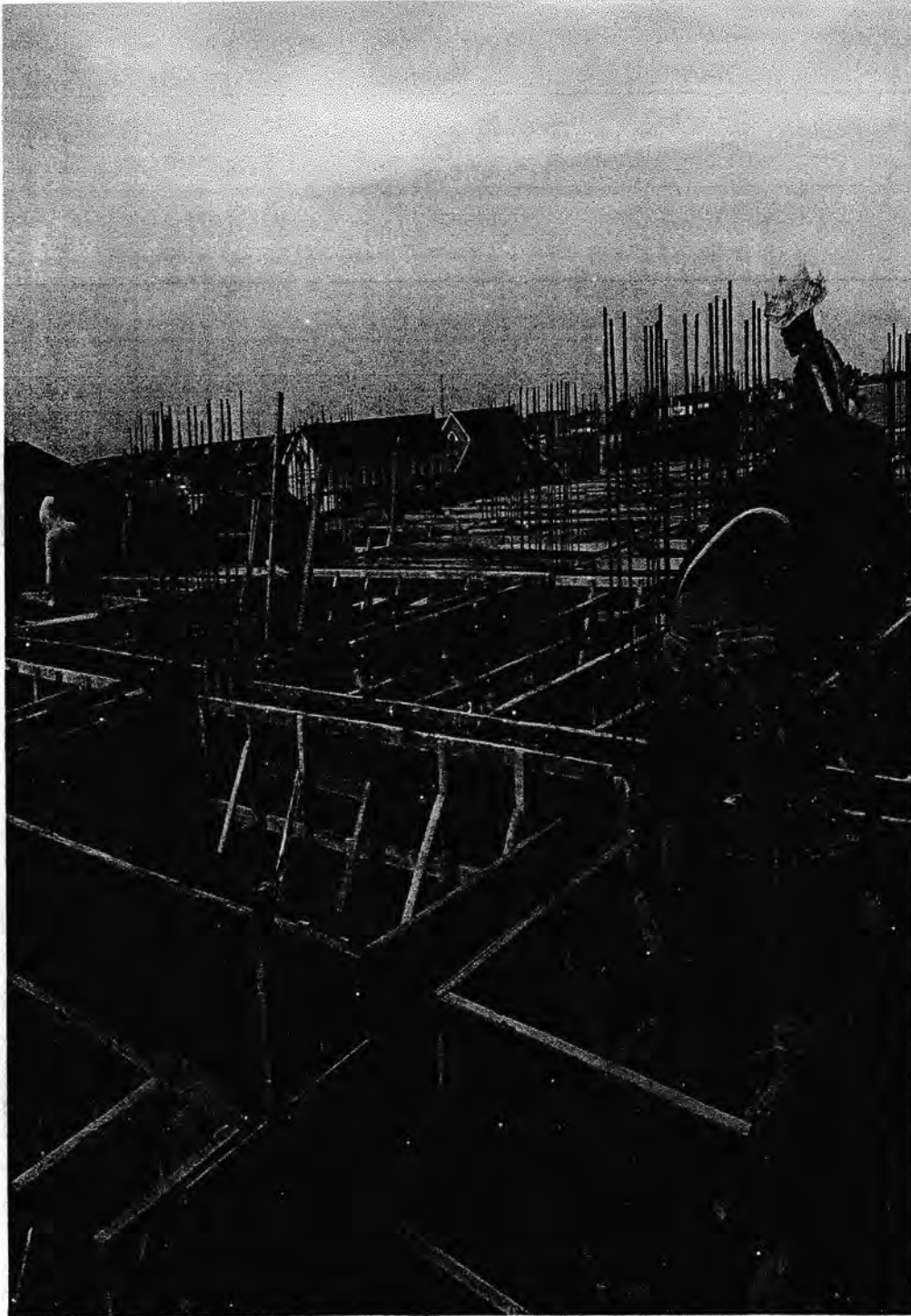
Gambar 16. Proses Bakisting Balok Tampak Atas Gedung Lokasi : Jalan Batu Sihombing kec.Percut Sei tuan Deli Serdang
