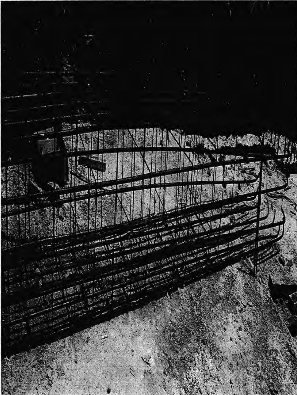
Gambar 3. Rangkaian Kolom
