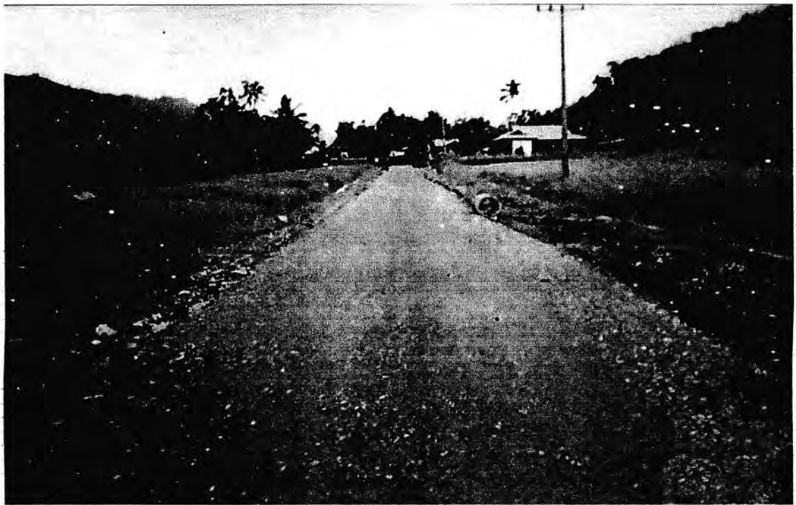
Gambar: STA 1+050 AC- BC Sebelum dikerjakan
