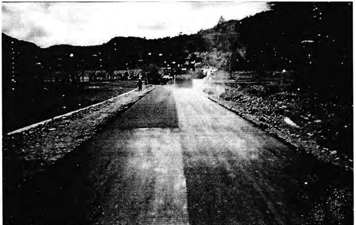
Gambar: STA 1+400 AC-WC Sedang dikerjakan
