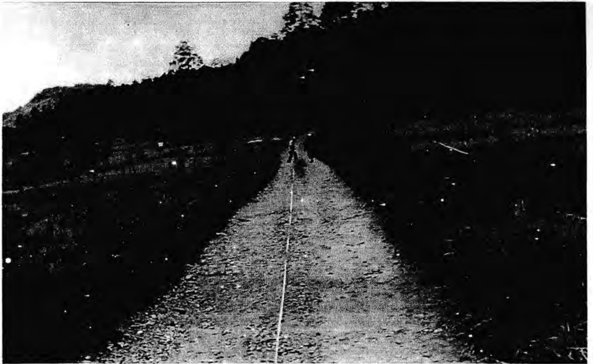
Gambar: STA 1+400 AC-WC Sebelum dikerjakan
