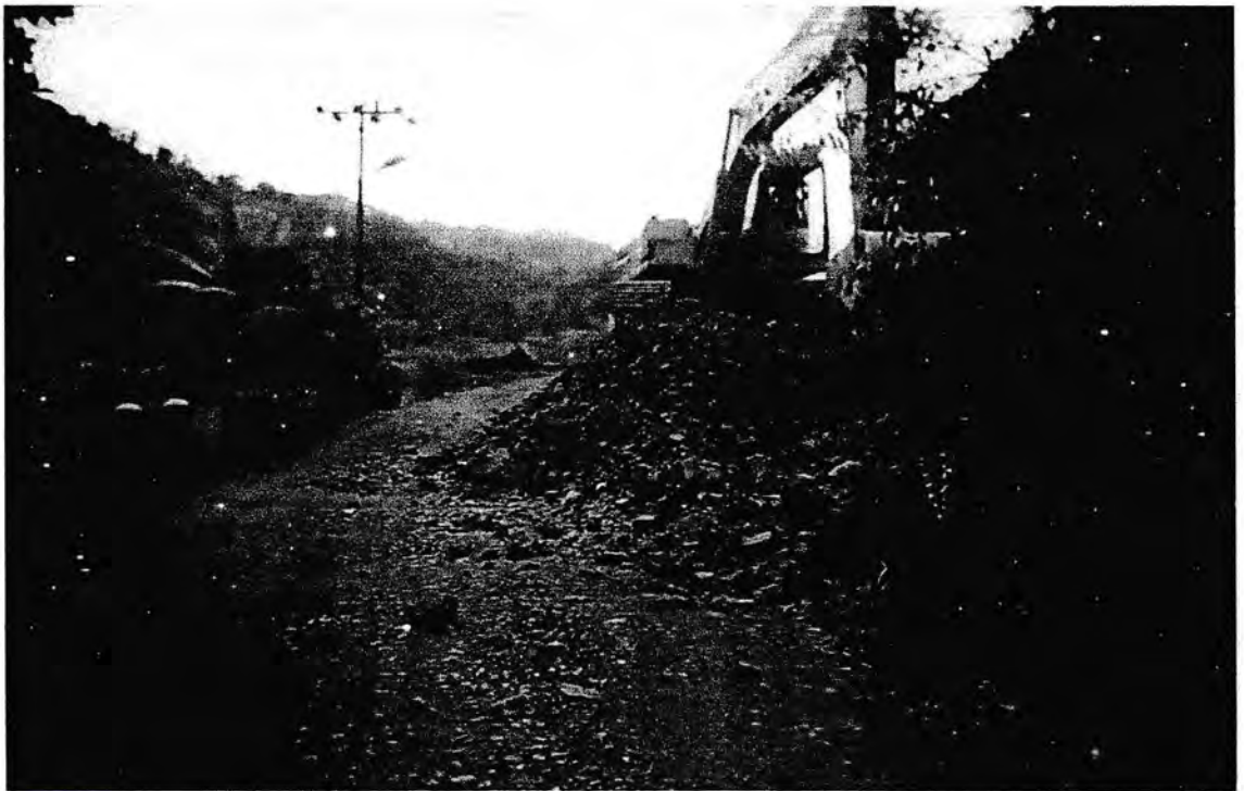
Gambar: Galian Batu Pada Dinding Jalan
