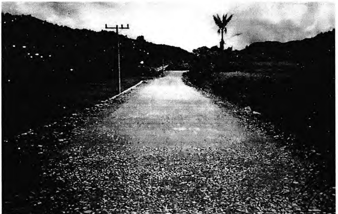
Gambar: STA 0+650 AC-WC Sebelum Dikerjakan
