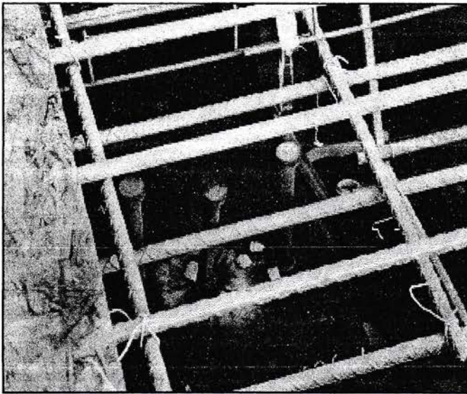
Gambar 2.7 Shear stud dipasang pada bagian atas gelagar pelat. Shear connector adalah kunci ingredient untuk mencegah slip dan membuat aksi komposit.
