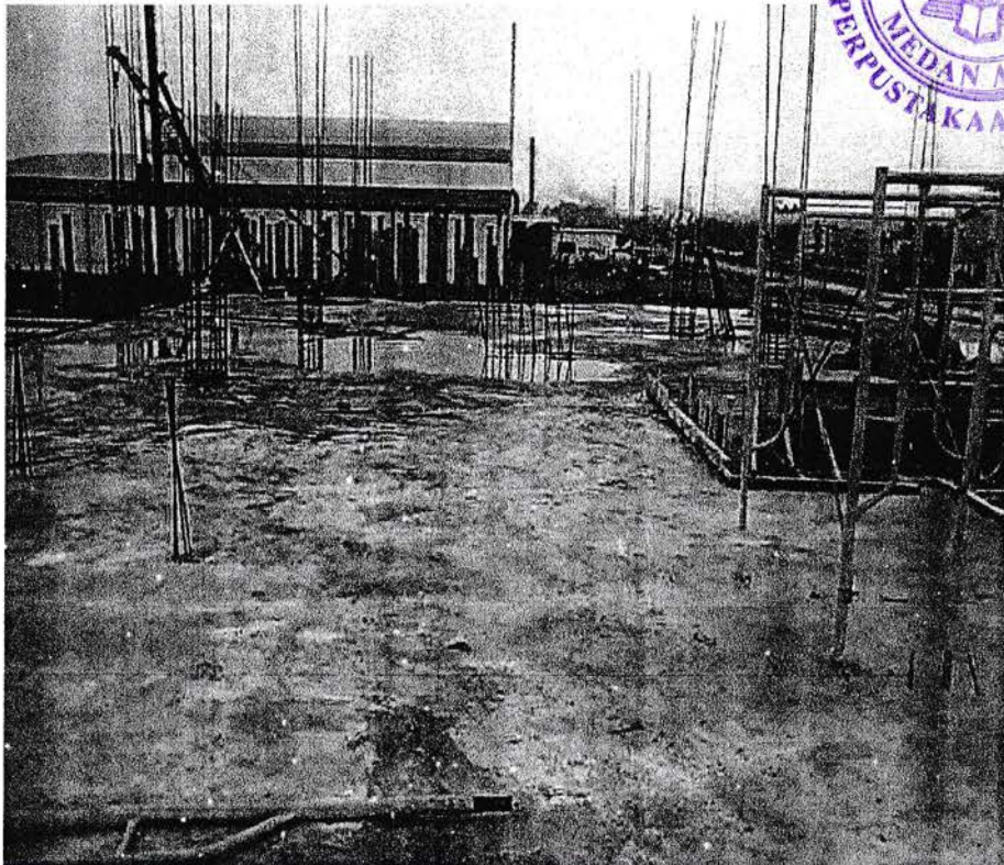
Gambar 3.1.3.8.b : Gambar Perawatan beton plat lantai
