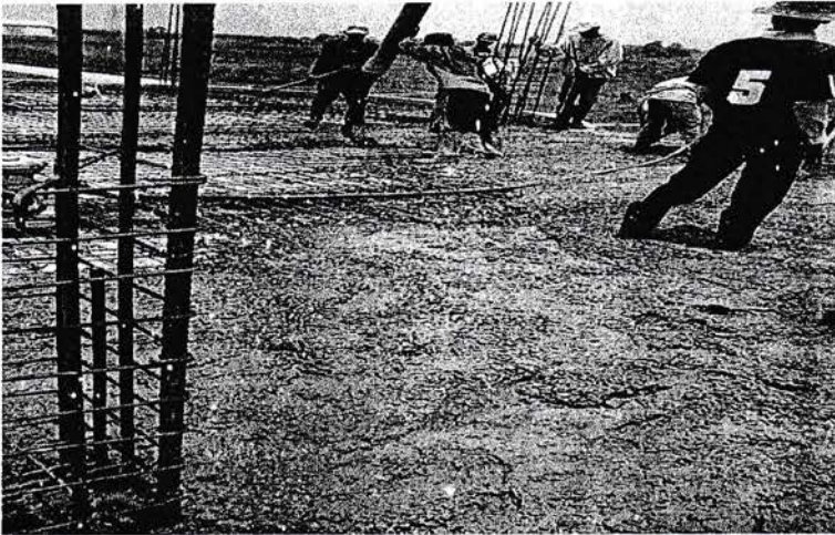
Gambar 3.1.3.5 : Gambar pengecoran pelat lantai
