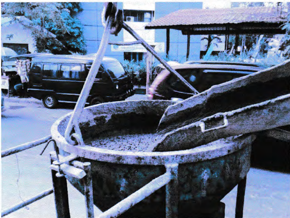
Gambar 16. Pengangkutan beton
