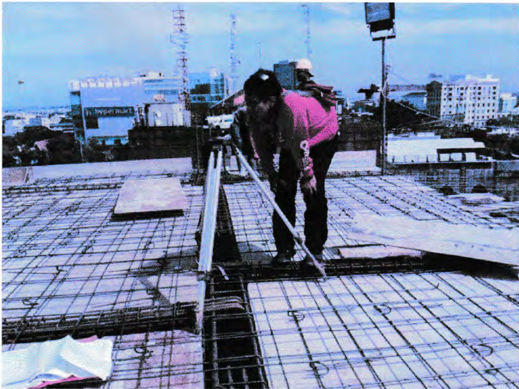
Gambar 9. Menentukan elevasi tebal plat lantai
