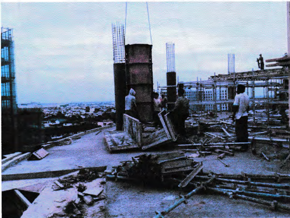
Gambar 36. Pembongkaran bekisting kolom
