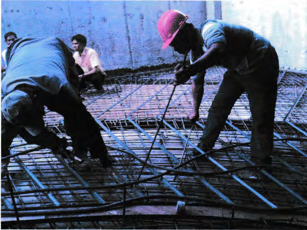
Gambar 39. Perakitan tulangan pada ramp
