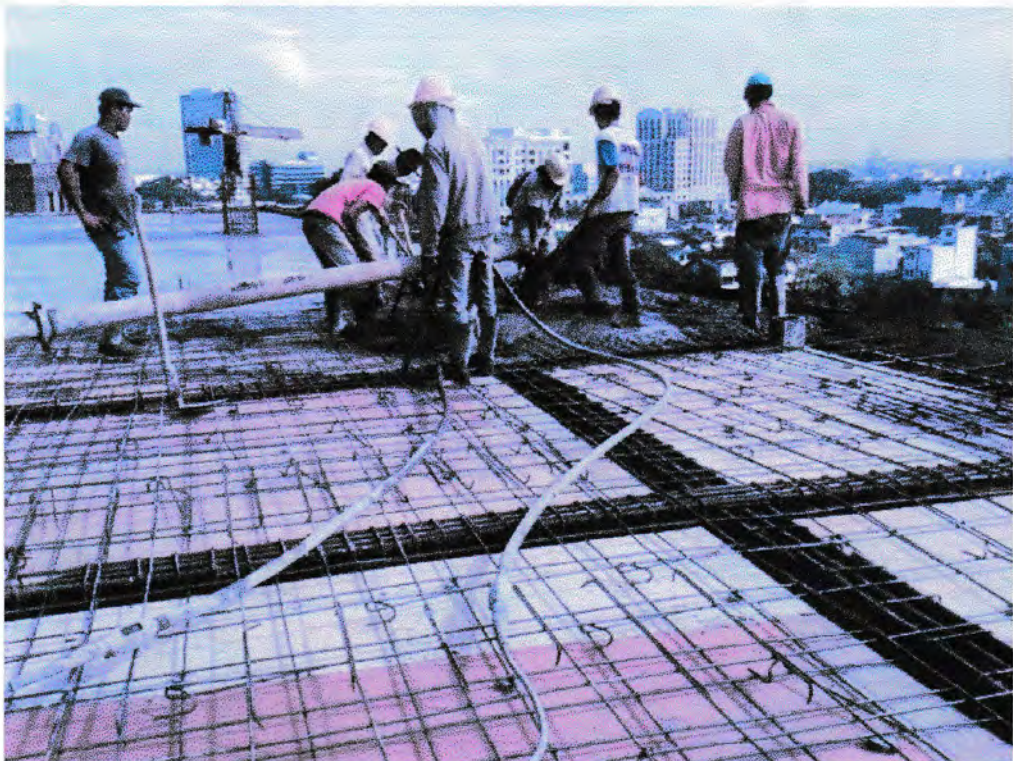
Gambar 10. Pengecoran plat lantai
