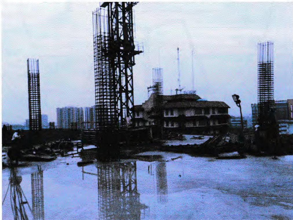
Gambar 22. Pemasangan / penempatan tulangan kolom
