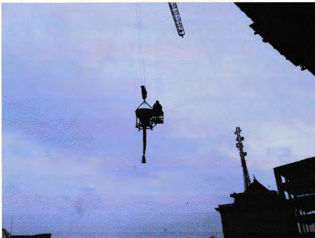
Gambar 18. Pengangkutan beton
