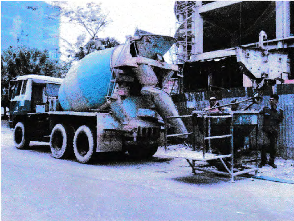
Gambar 17. Pengangkutan beton
