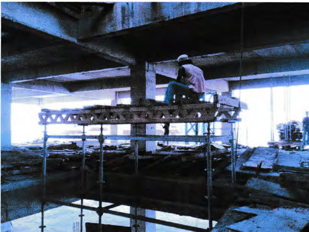
Gambar 40. Pemasangan scaffolding tangga
