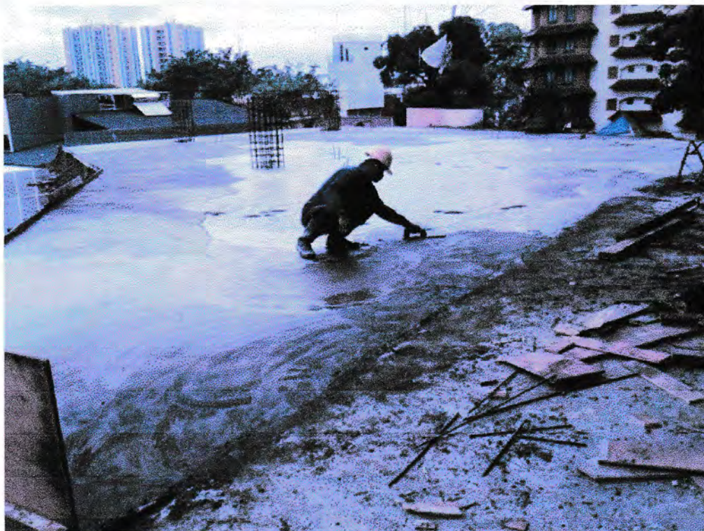
Gambar 12. Pengerjaan perataan pengecoran
