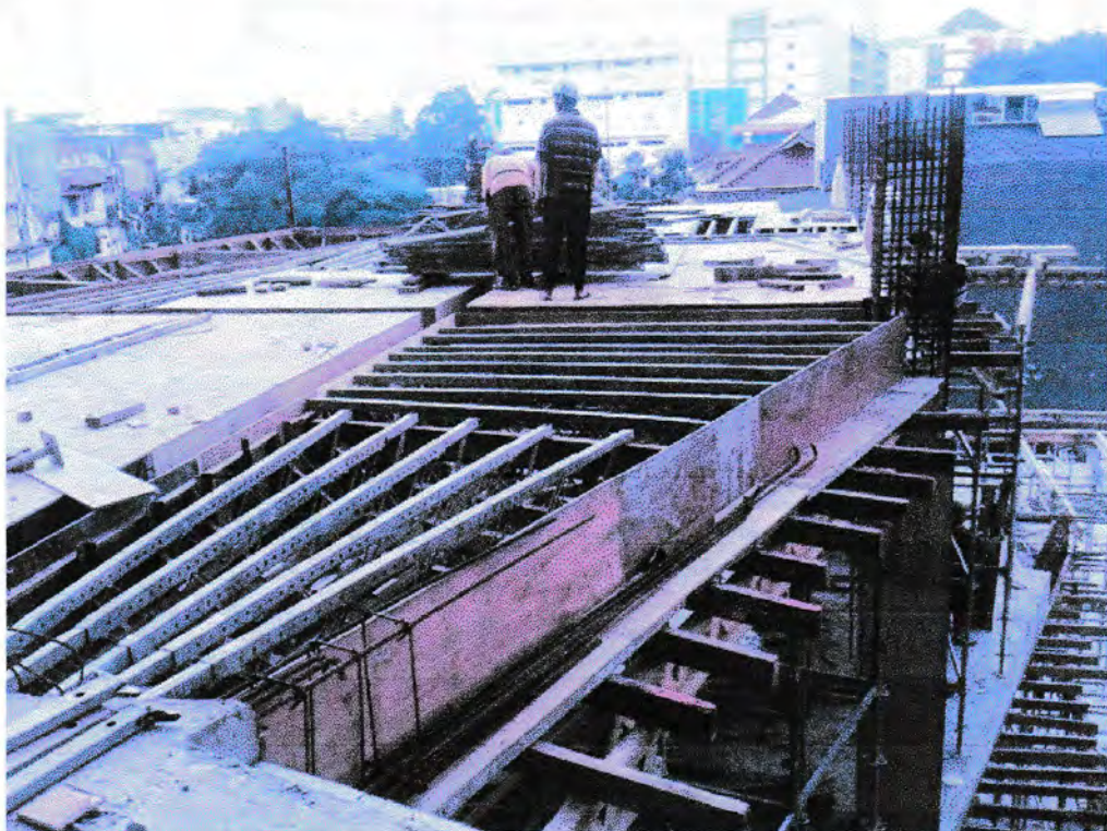
Gambar 6. Pemasangan scaffolding
