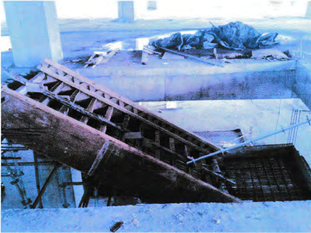
Gambar 41. Pemasangan scaffolding tangga
