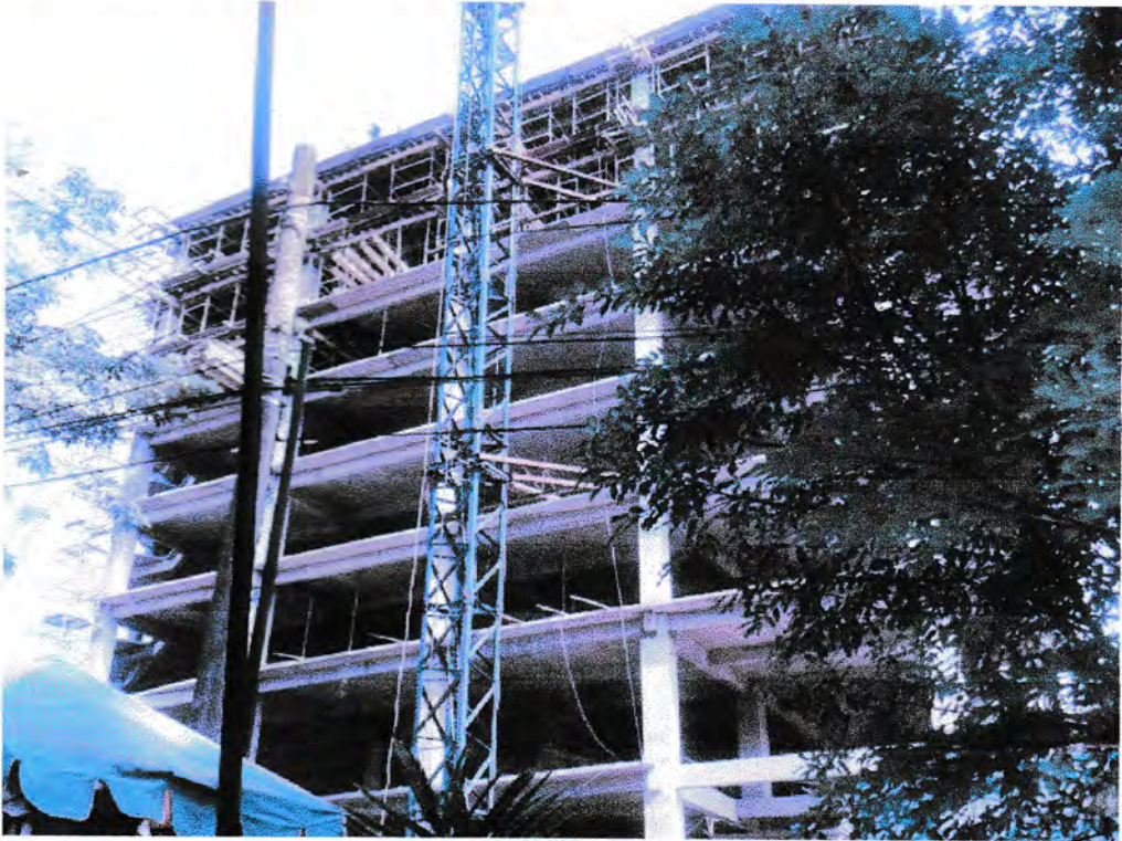
Gambar 47. Pembangunan struktur berjalan 70 %
