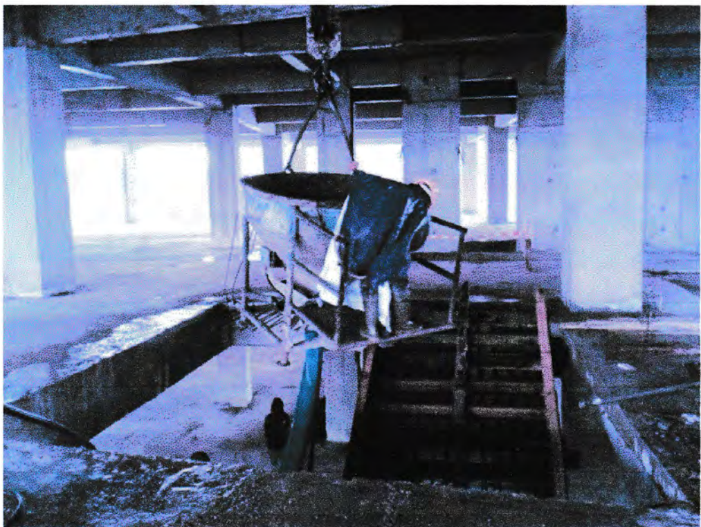
Gambar 42. Pengecoran tangga
