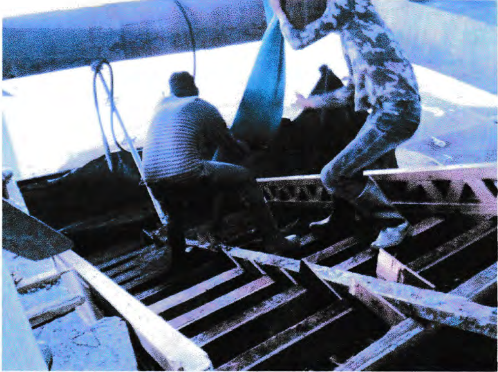
Gambar 43. Pengecoran tangga
