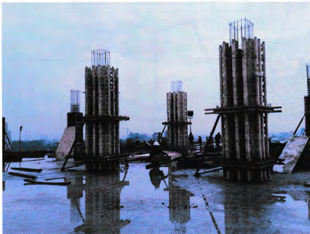
Gambar 34. Pemasangan bekisting kolom
