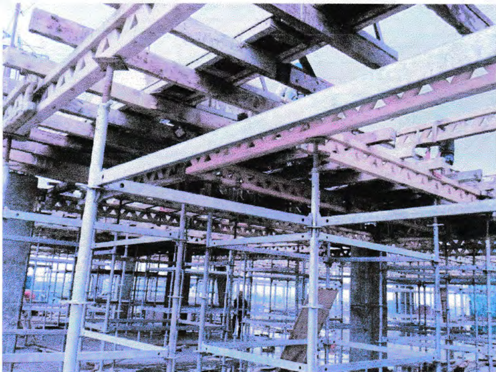
Gambar 4. Pemasangan scaffolding
