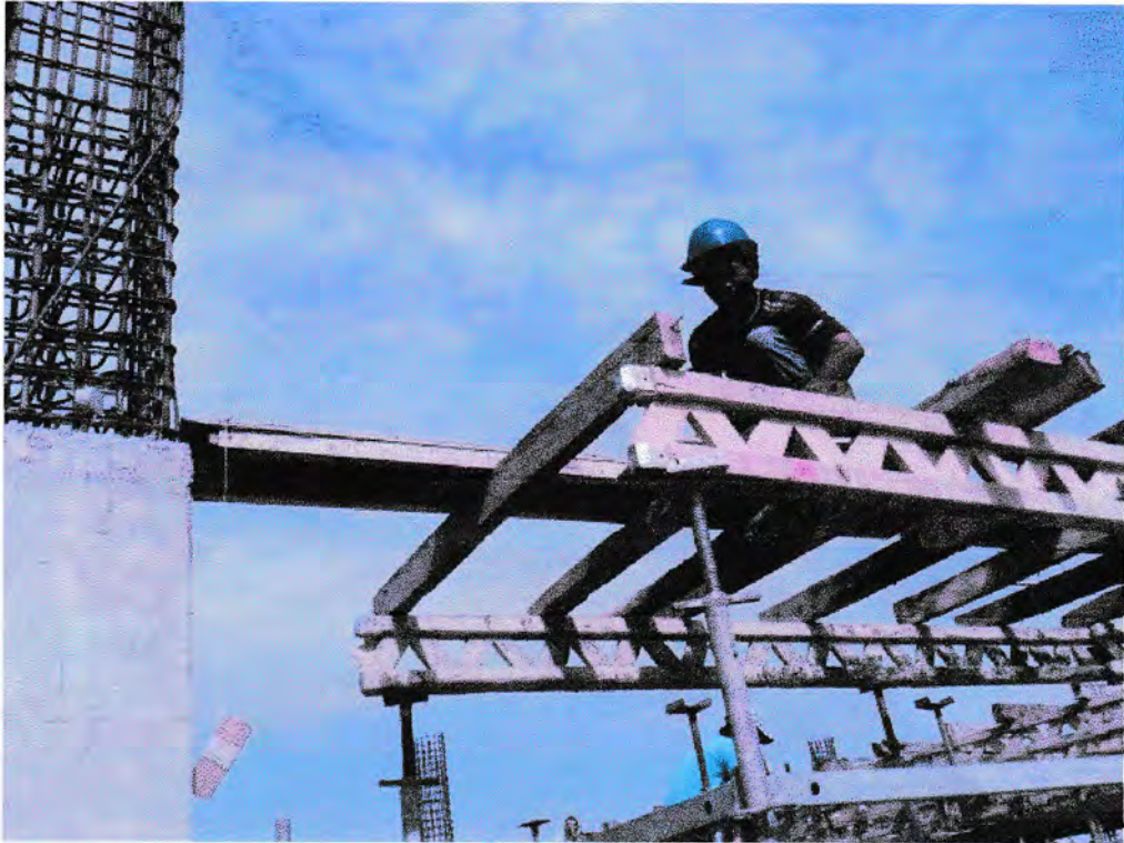
Gambar 3. Menentukan as balok pada kolom
