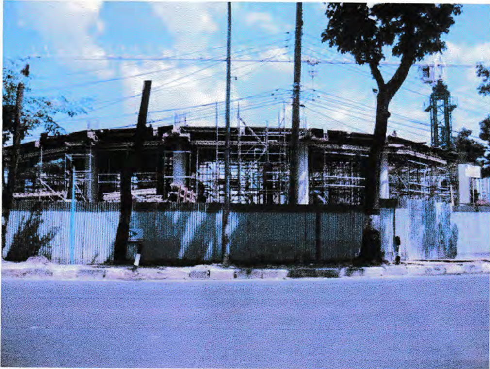
Gambar 47. Pembangunan struktur berjalan. 15%
