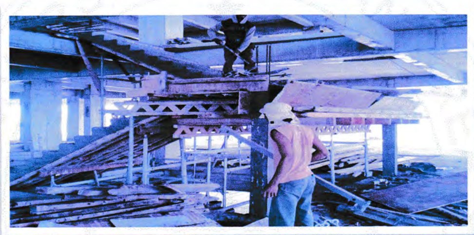
Gambar: 3.1.4.d pembongkaran bekisting pada tangga
