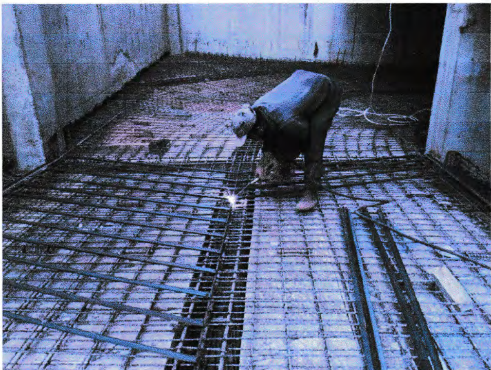
Gambar 38. Perakitan tulangan pada ramp
