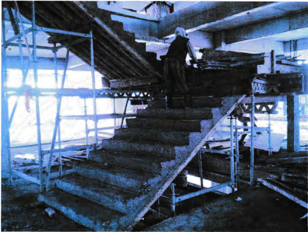
Gambar 45. Pembongkaran bekisting tangga
