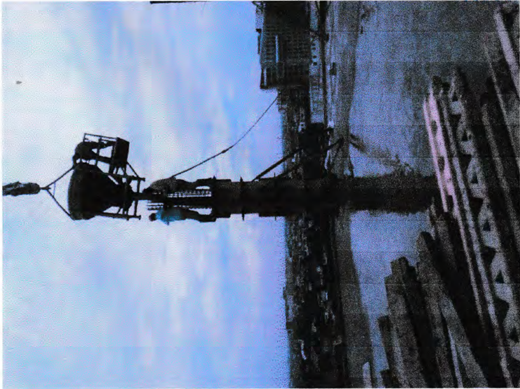
Gambar 35. Pengecoran kolom
