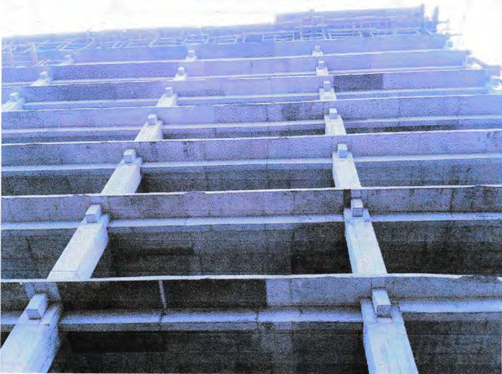
Gambar 47. Pembangunan struktur berjalan 70 %
