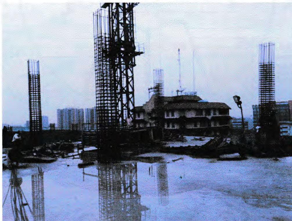
Gambar 22. Pemasangan / penempatan tulangan kolom
