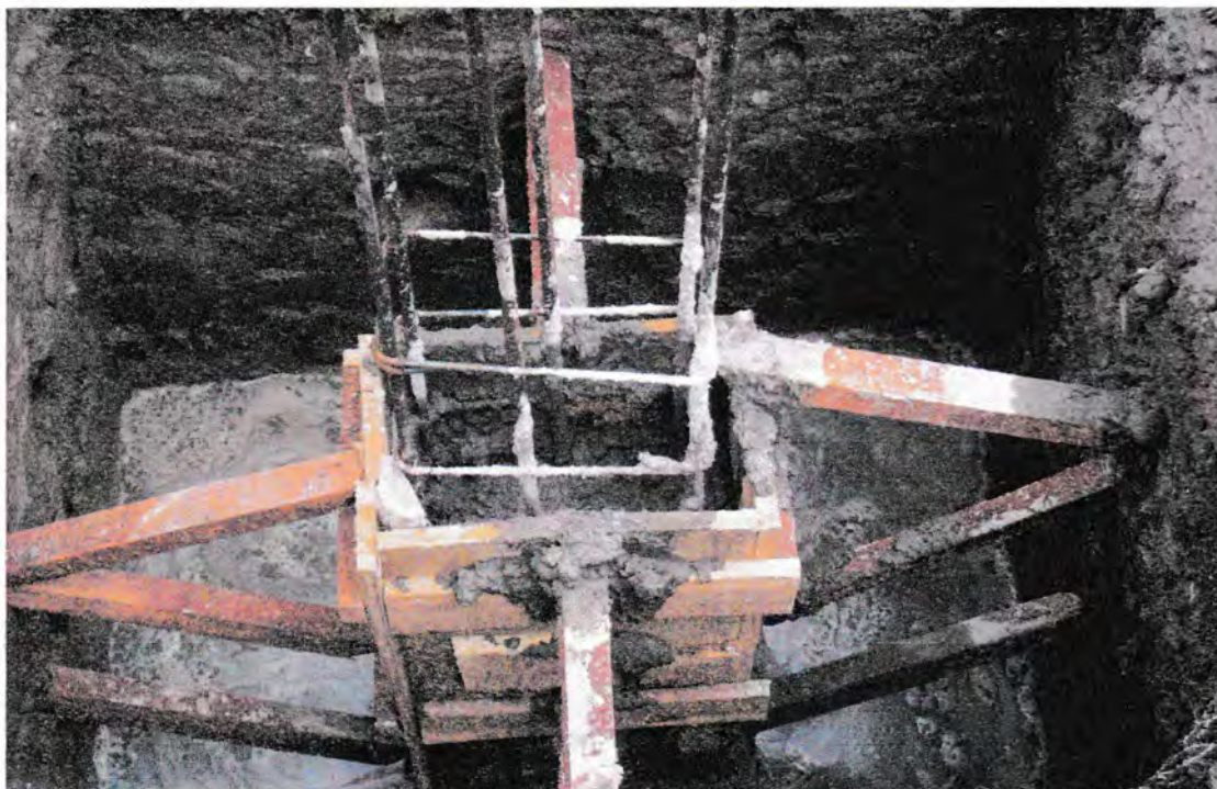
Gambar Pekerjaan Pengecoran Pondasi Tapak
