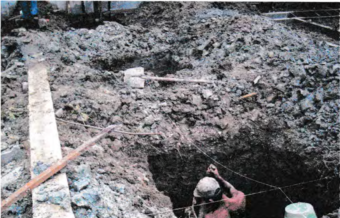
Gambar Pekerjaan Galian Pondasi Tapak
