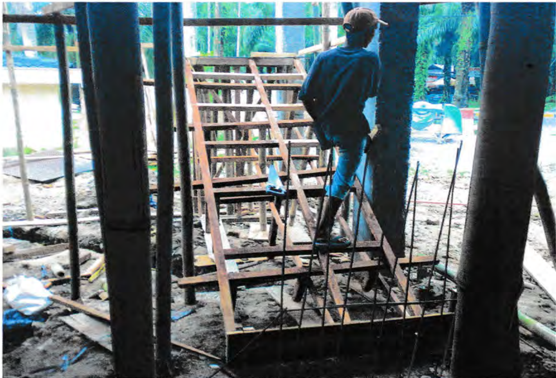
Gambar Pekerjaan Cetakan Tangga
