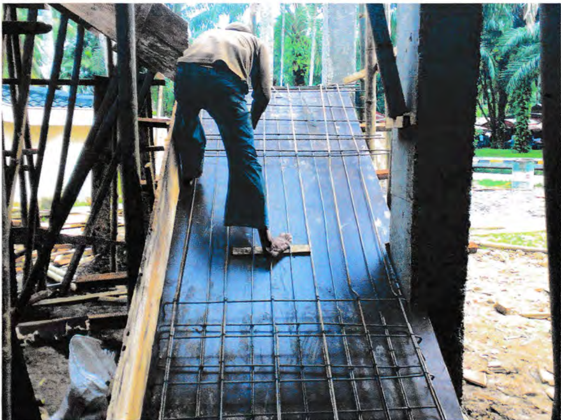
Gambar Pekerjaan Pembesian Tangga
