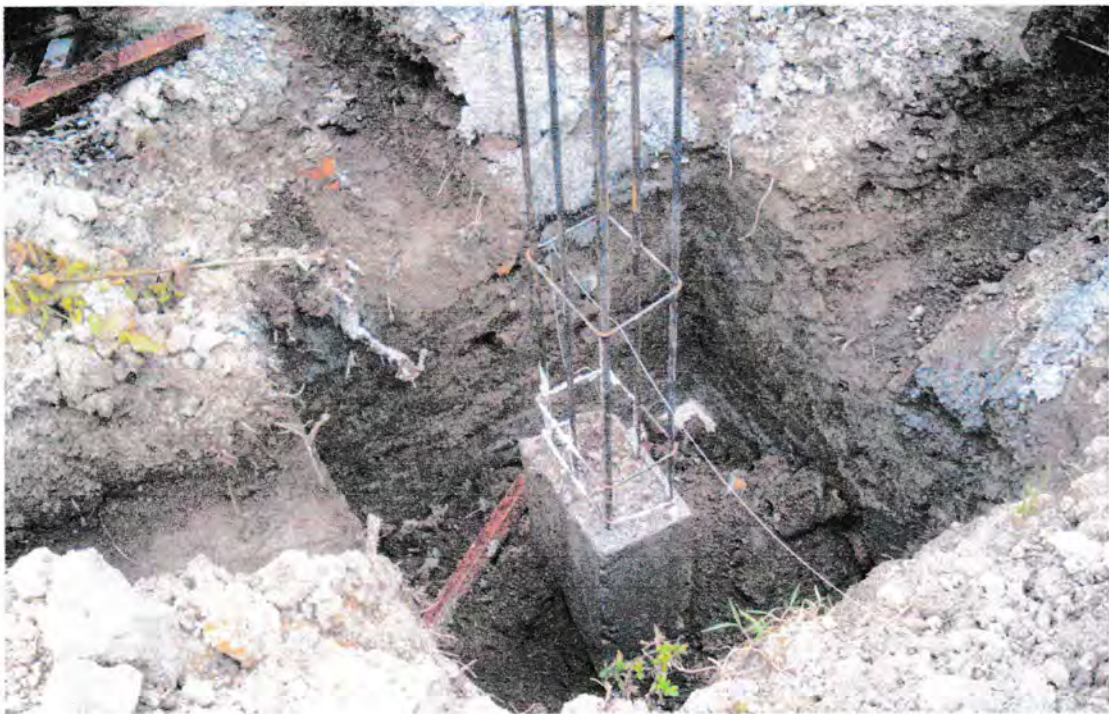
Gambar Pekerjaan Timbunan Pondasi Tapak
