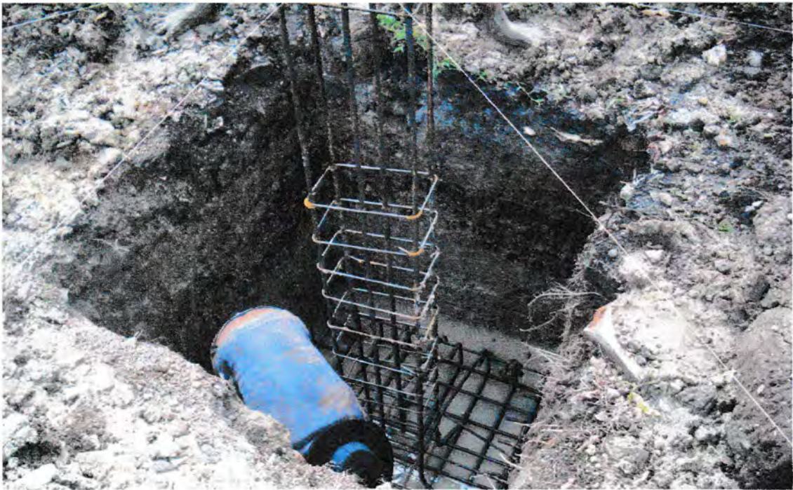
Gambar Pekerjaan Perletakan Tulangan Pondasi Tapak
