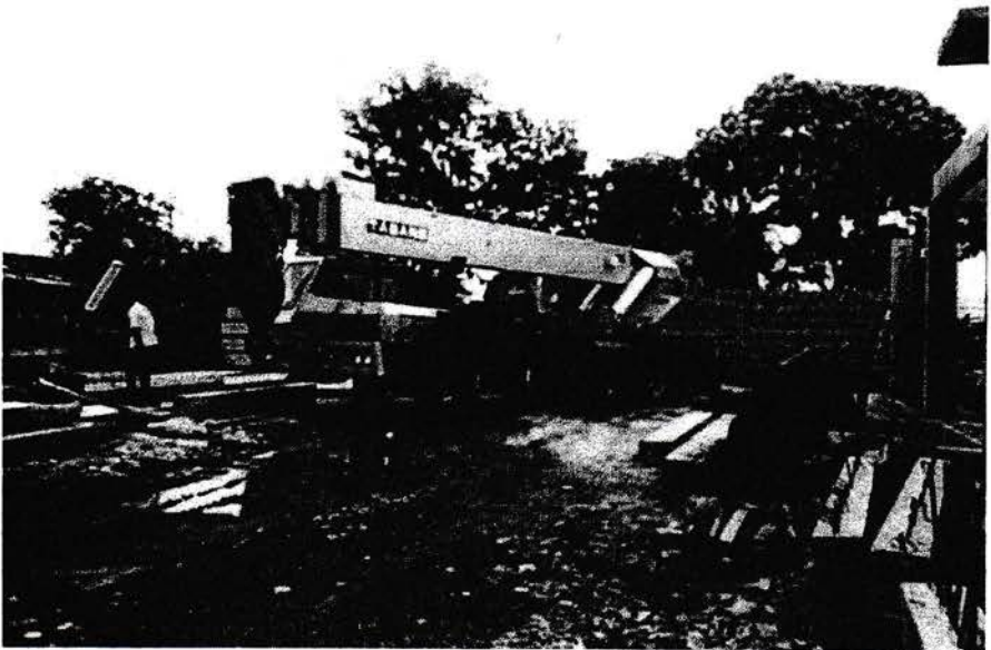
Gambar IV.5.2. Crane Mobile yang digunakan untuk mengangkat kolom.
