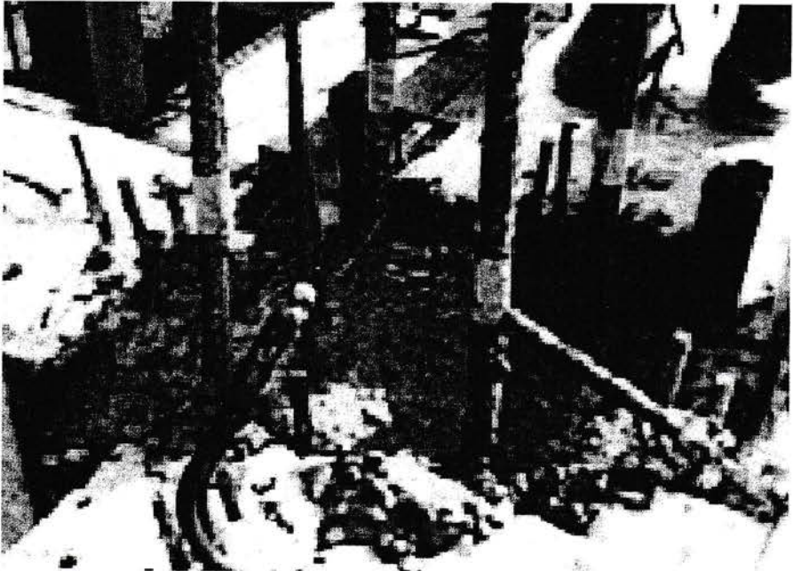
Gambar IV.10.5. Agregat yang telah selesai dituang ke dalam sambungan.
