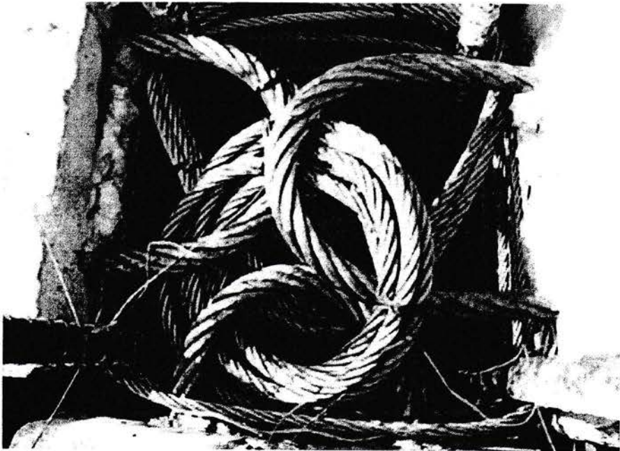
Gambar IV.9.7. Ikatan kabel seling pada bagian atas dari kabel seling balok.
