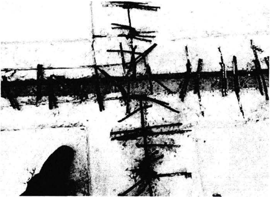
Gambar IV.12.1. Tulangan yang menjorok keluar dari lantai dikaitkan dengan tulangan lantai lainnya.
