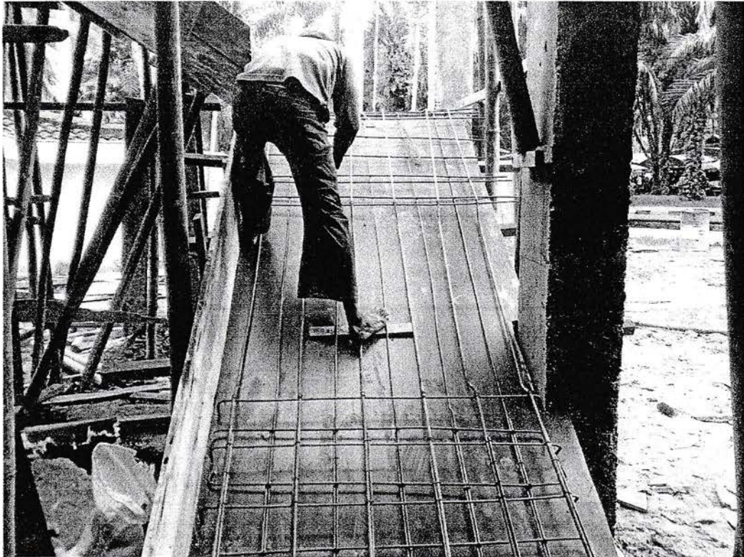
Gambar Pekerjaan Pembesian Tangga
