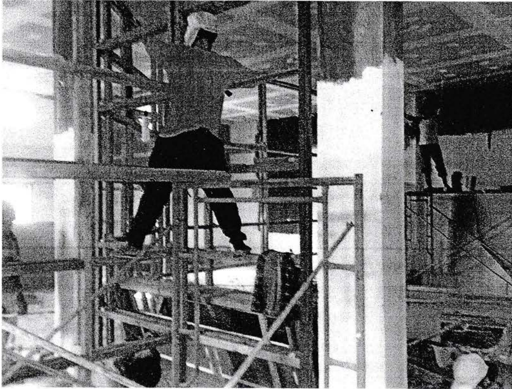
Gambar Pekerjaan Pemasangan Gypsum
