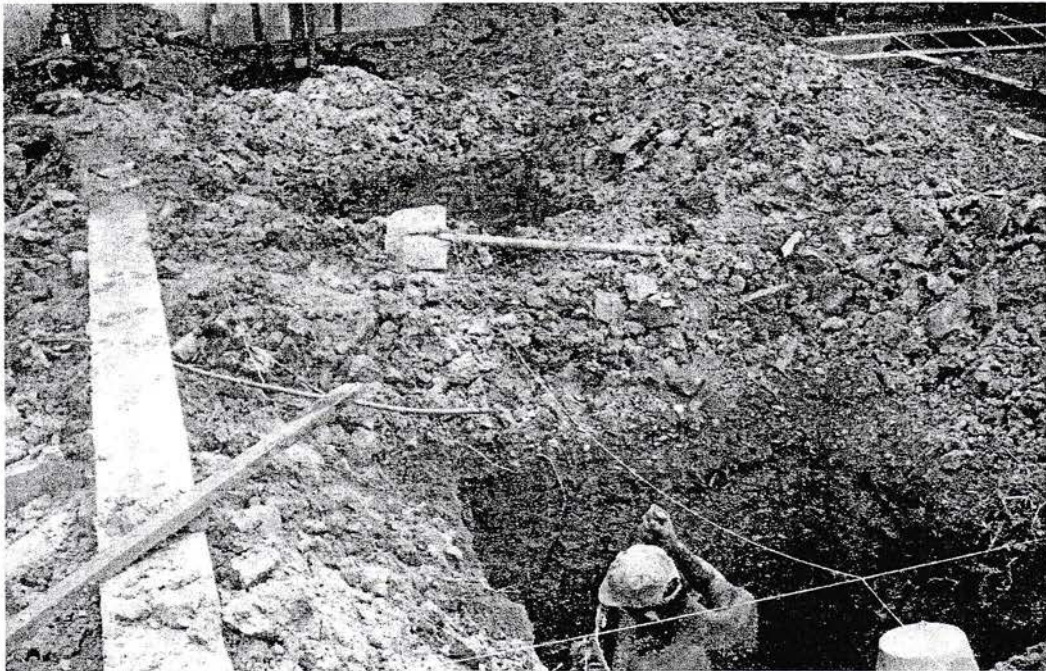
Gambar Pekerjaan Galian Pondasi Tapak
