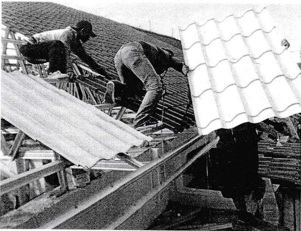
Gambar Pekerjaan Pemasangan Penutup Atap
