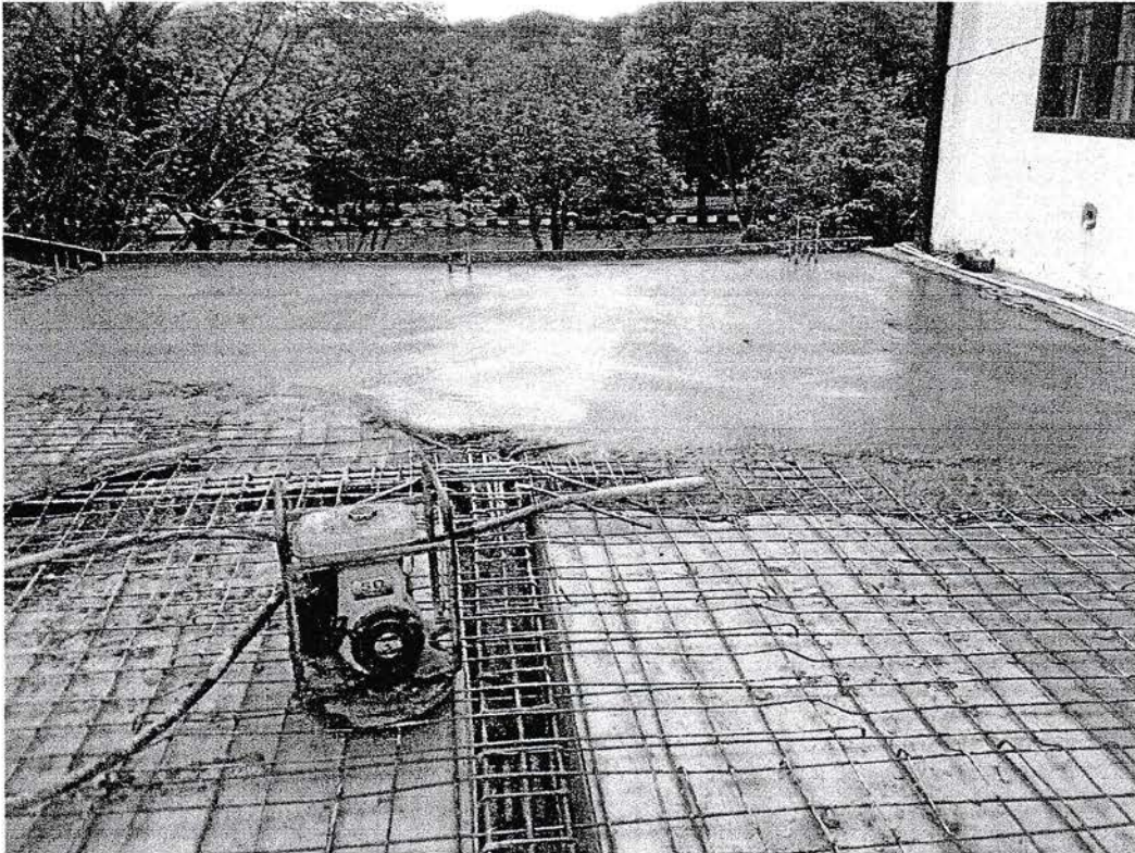
Gambar Pekerjaan Pengecoran Lantai II
