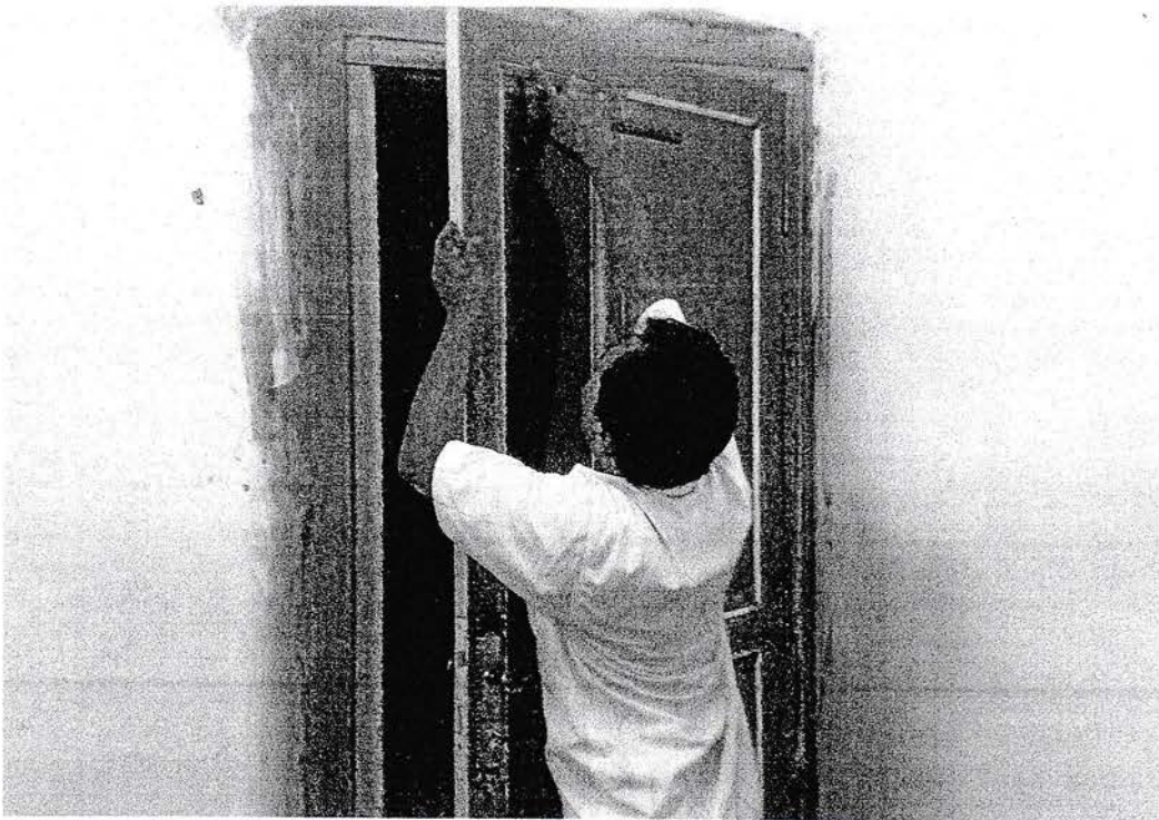
Gambar Pekerjaan Pemasangan Pintu
