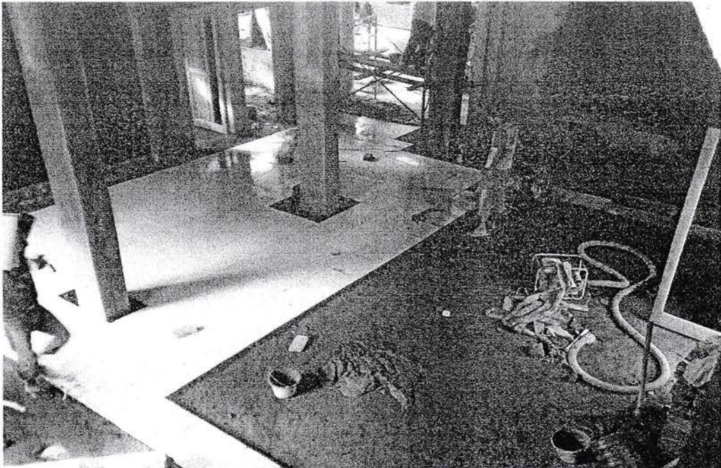
Gambar Pekerjaan Lantai Keramik
