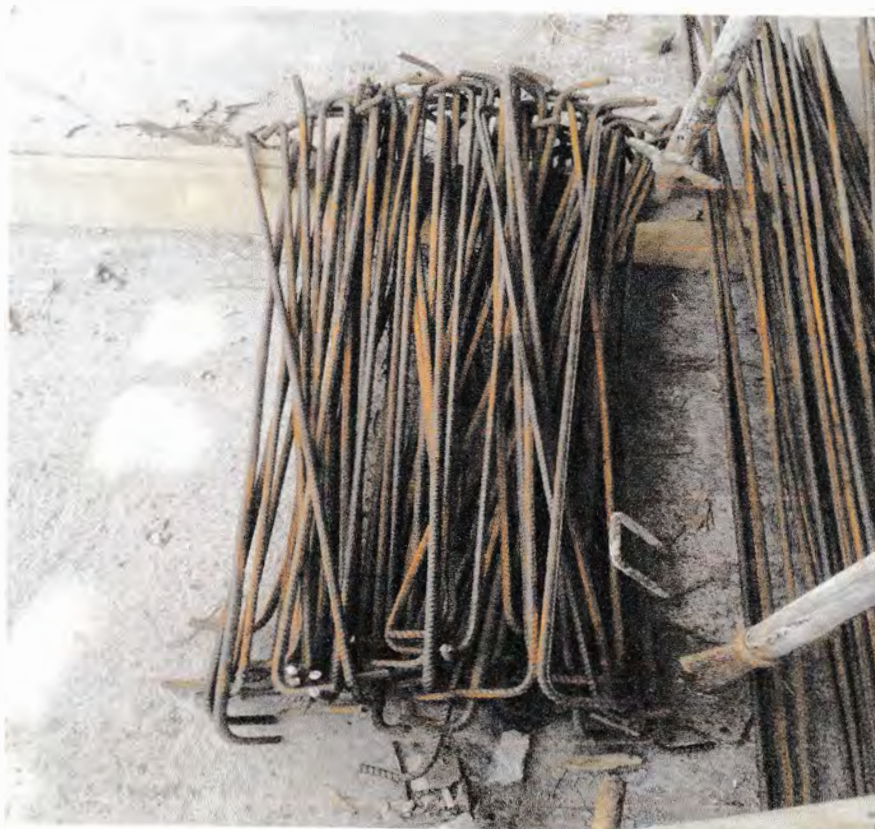
Gambar. Besi tisi yang dikerjakan di Pabrikasi Lokasi : Jalan Setia Budi No. 75 Helvetia Medan
