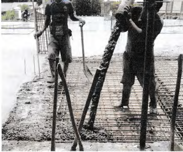
Gambar 3.15 Pengecoran Plat Lantai
