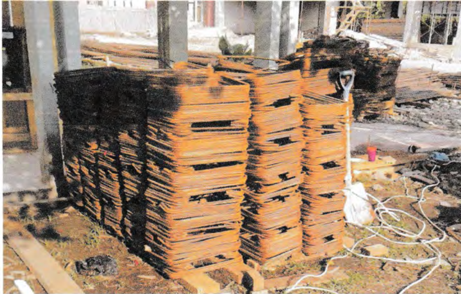
Gambar. Besi Sengkang yang dikerjakan di Pabrikasi Lokasi : Jalan Setia Budi No. 75 Helvetia Medan
