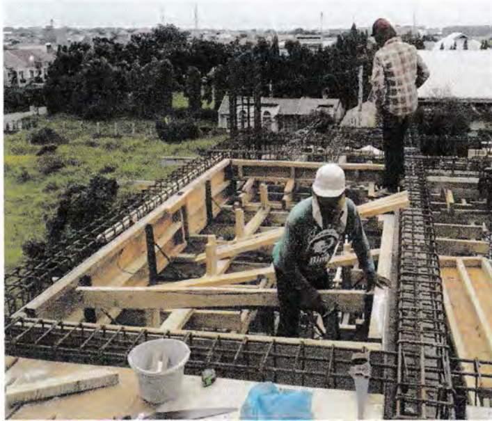
Gambar 3.13 Pemasangan Bekisting Balok dan Plat Lantai
