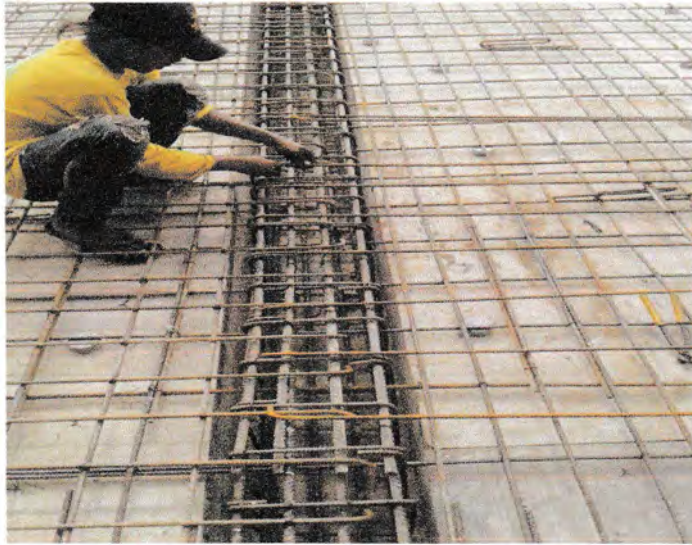
Gambar 3.14 Pembesian Plat Lantai
