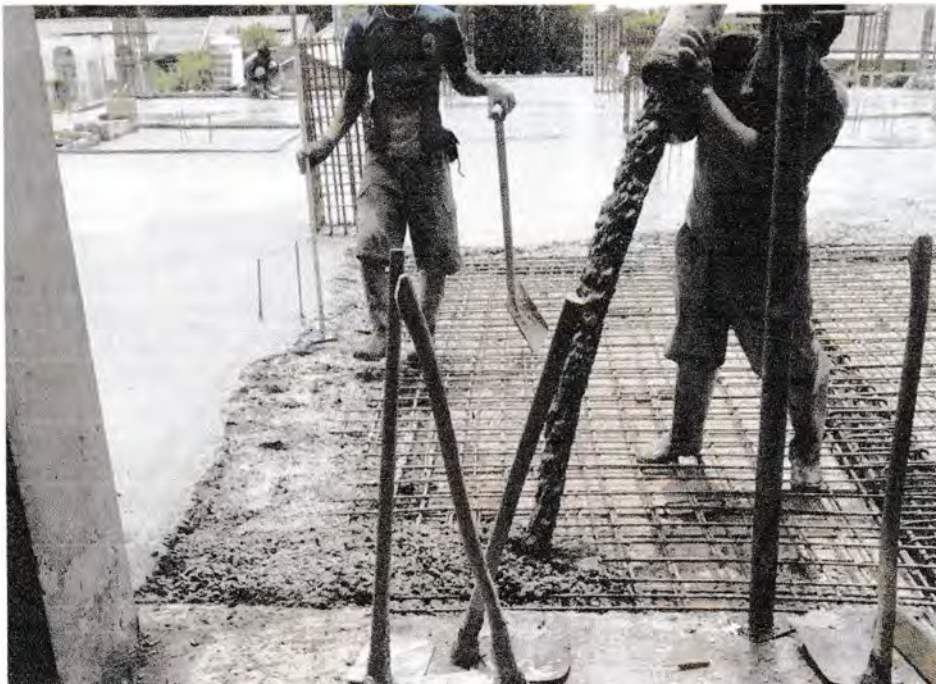
Gambar Penulangan Plat Lantai dan tahanan beton Lokasi : Jalan Setia Budi No. 75 Helvetia Medan
