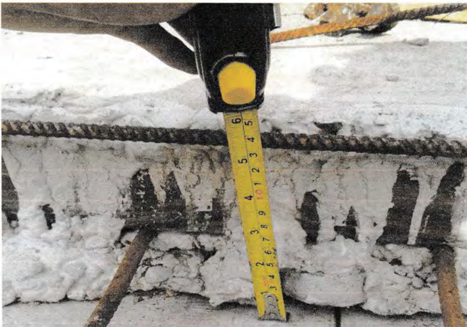
Gambar Plat Lantai yang Telah dikerjakan Lokasi :Jalan Setia Budi No. 75 Helvetia Medan
