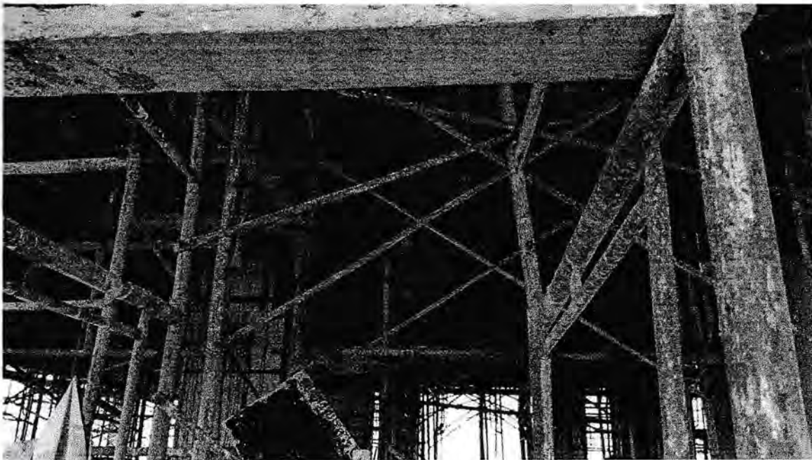
Gambar 4.6 : proses pelepasan beskisting balok dan plat Sumber : Data Lapangan 2018
