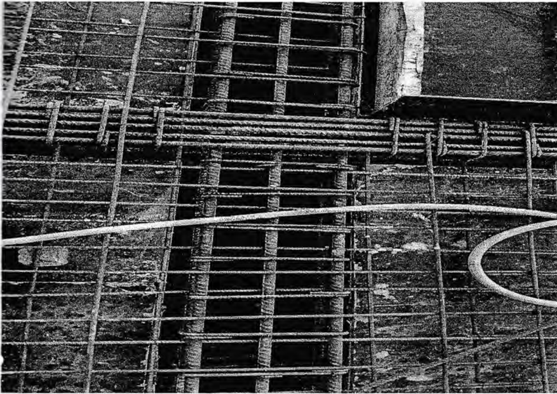
Gambar 4.5 : Tulangan balok Sumber : Data Lapangan 2018
