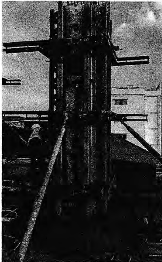
Gambar 3.1 : Cekisting atau cetakan kolom
