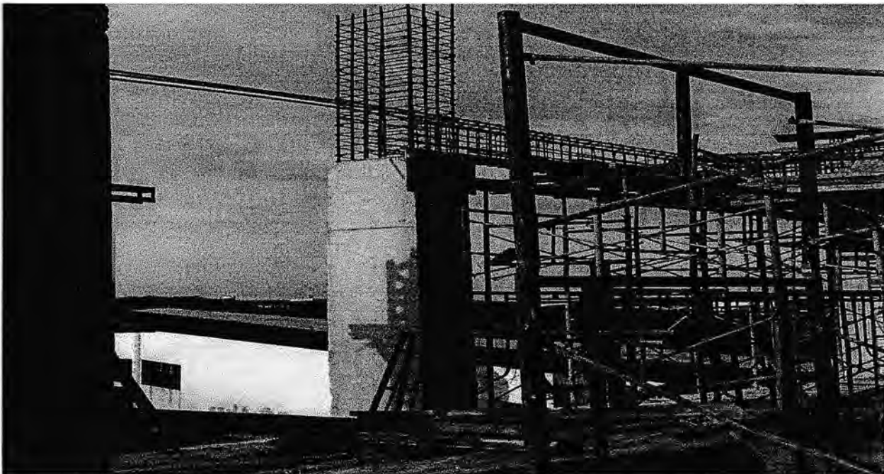
Gambar 4.2 : Pemasangan Tulangan Balok
