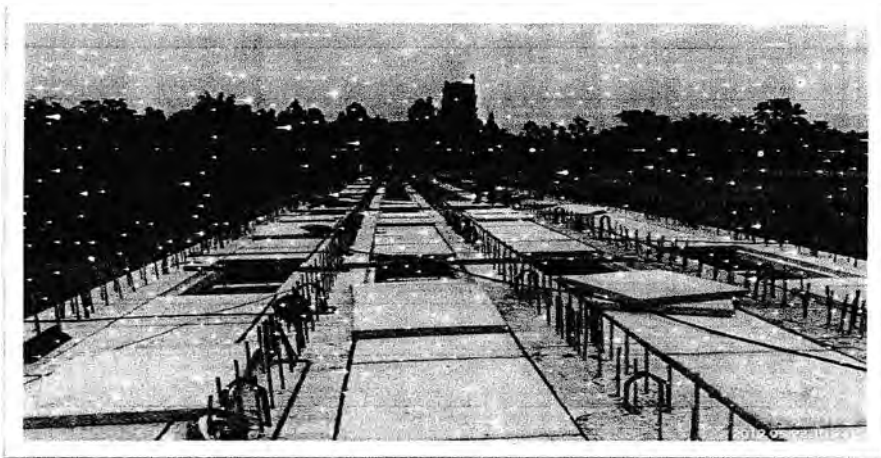
3.5.7 Bekisting plat lantai
