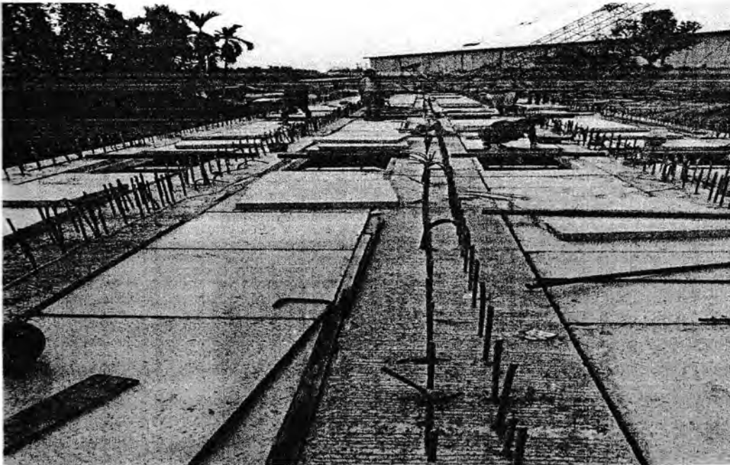
Gambar 3.5.4.1 Pemasangan RC Plat
