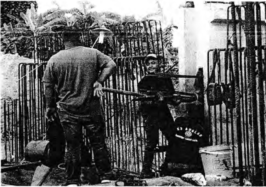
Gambar 4.3.1 Pekerjaan Stressing Balok Girder
