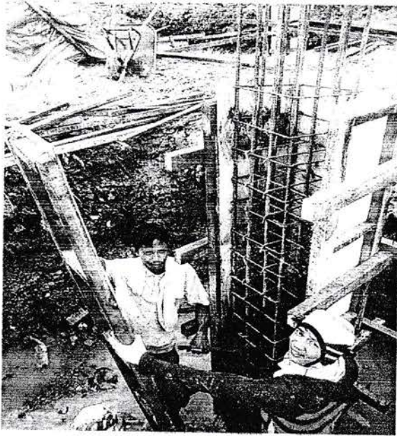
Gambar 3.2.4.1 Pemasangan Papan Kayu Bekisting
