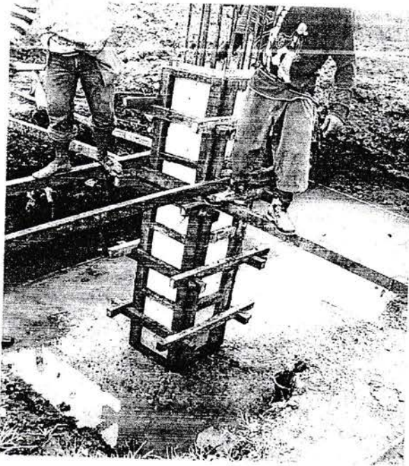
Gambar 3.2.5.2 Pengecoran Kolom
