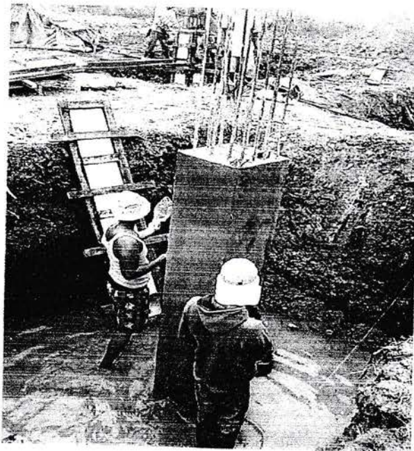
Gambar 3.2.6.1 Pembongkaran Bekisting
