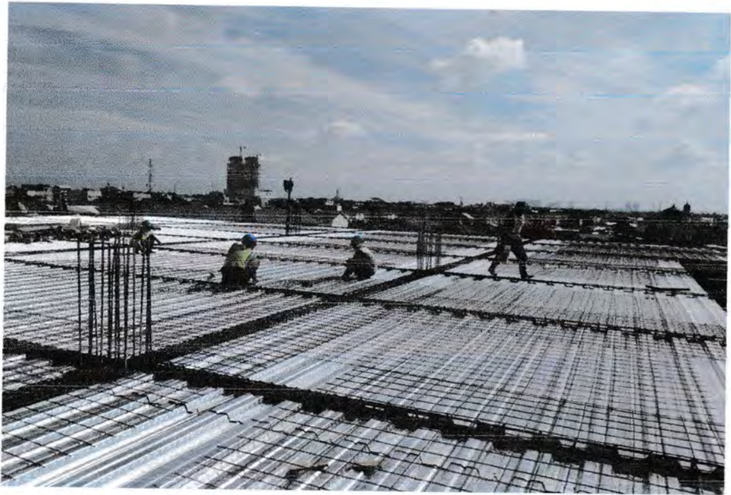
Gambar 3 : Penulangan Plat Lantai
