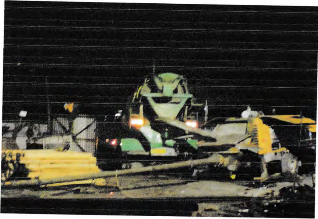
Gambar 11 : Proses Pemberian Cor-an ke Lantai Atas
