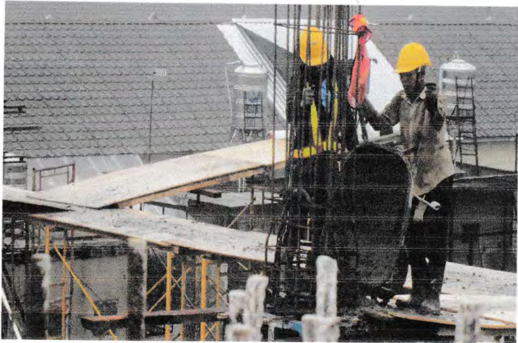
Gambar 13 : Pengecoran dan Pemasangan Kolom dengan cara manual
