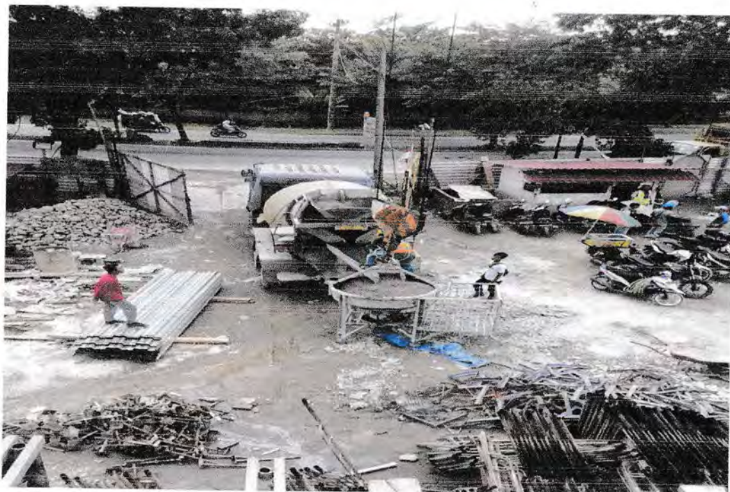
Gambar 9 : Pengisian Cor-an dari Mixer Truk ke Bucket
