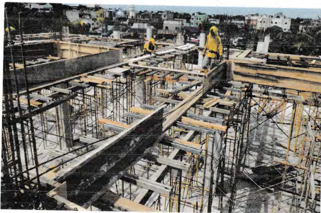
Gambar 5 : Pembuatan Bekisting Balok
