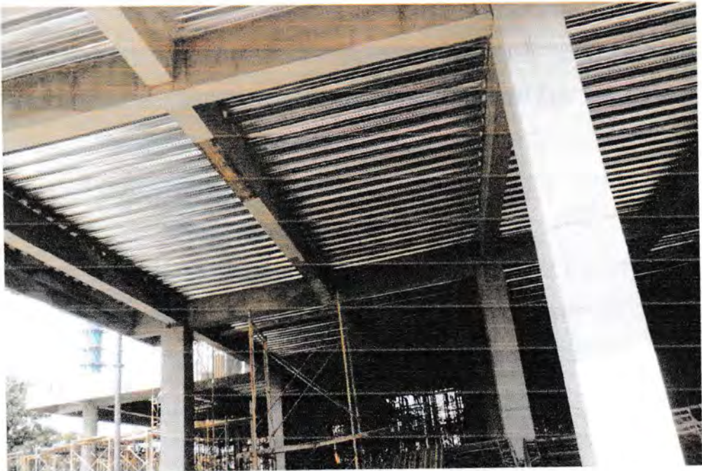
Gambar 2.22 Bondek pada bangunan
