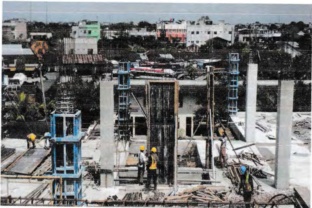
Gambar 28 : Pemasangan Bekisting Kolom untuk Lift
