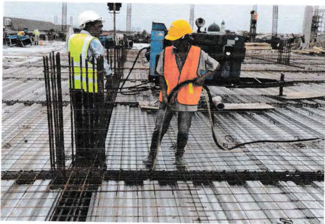
Gambar 8 : Pembersihan Plat dan Balok Menggunakan Compressor
