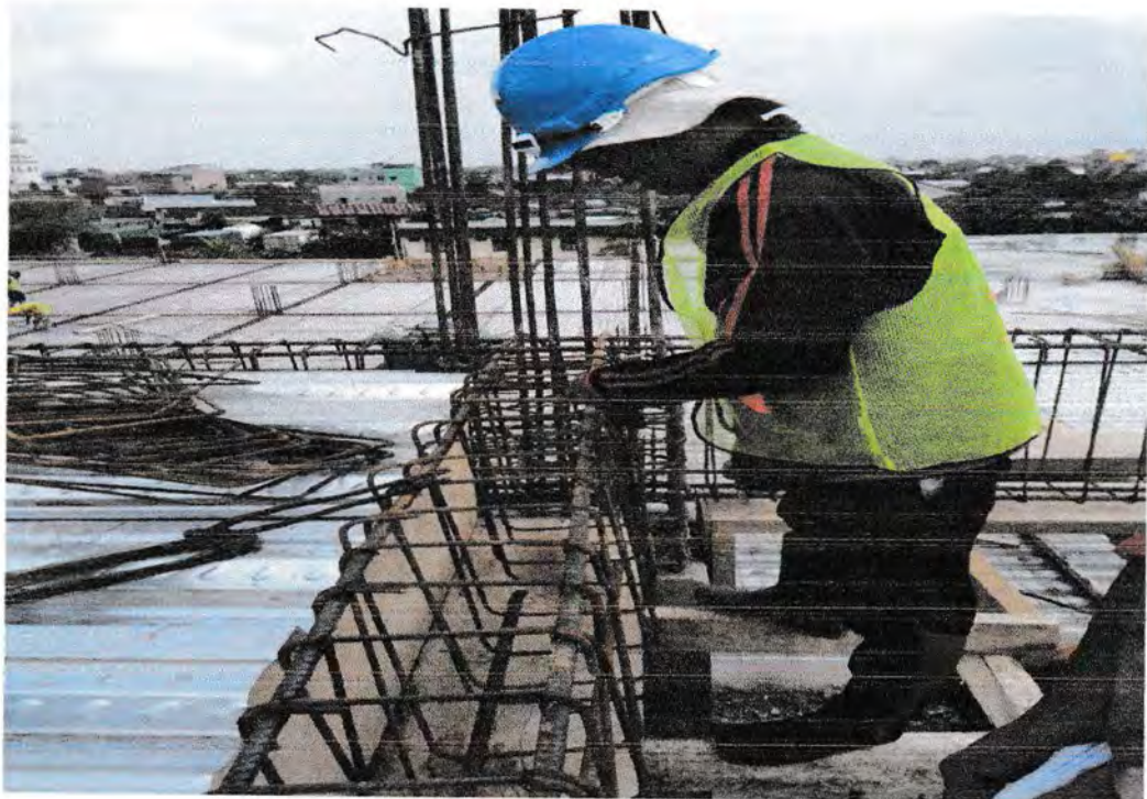
Gambar 2 : Penulangan Pada Balok
