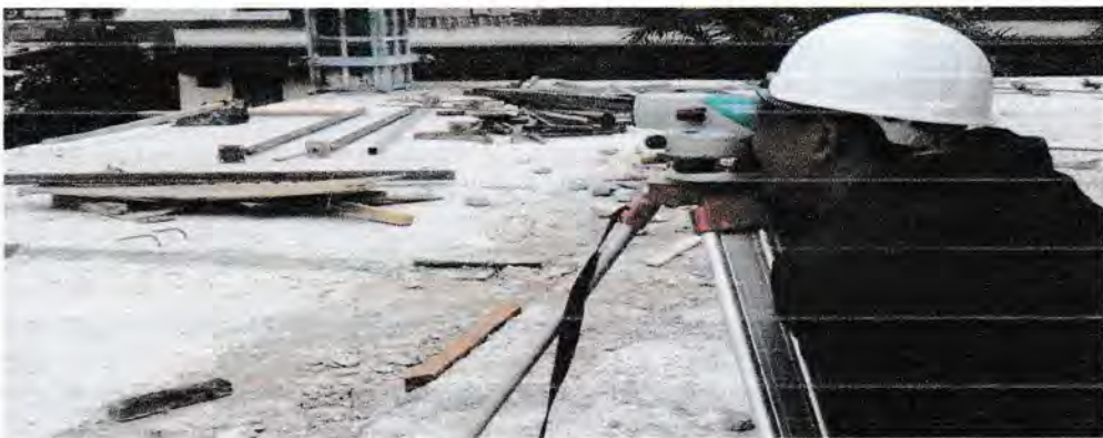
Gambar 2.22 Penentuan As dengan Waterpass
