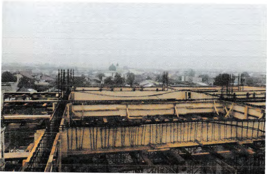
Gambar 22 : Bekisting Balok
