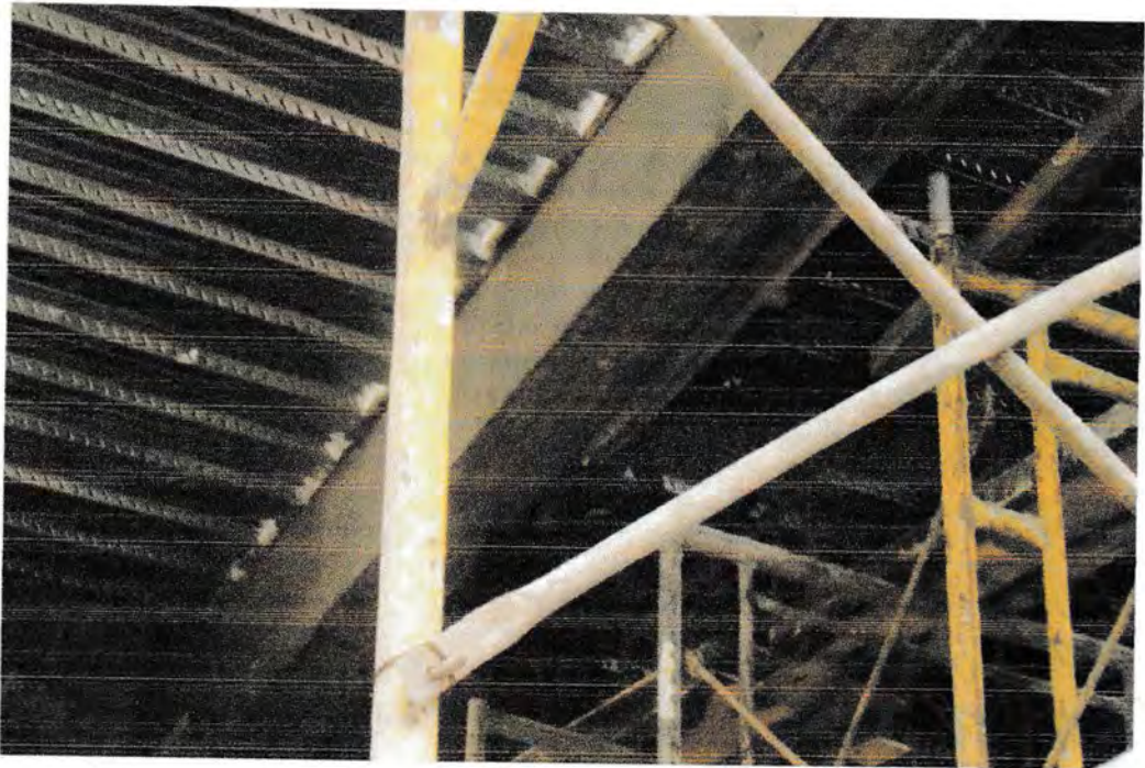
Gambar 17 : Pembongkaran Mal Pada Balok
