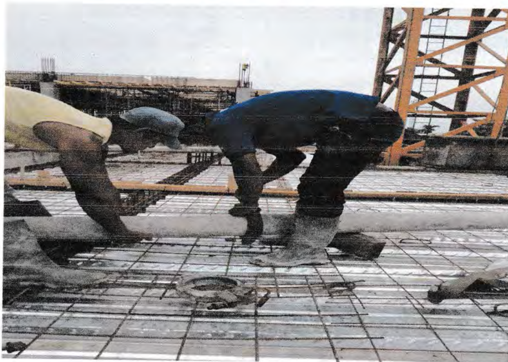
Gambar 10 : Pemasangan Pipa – Pipa Besi
