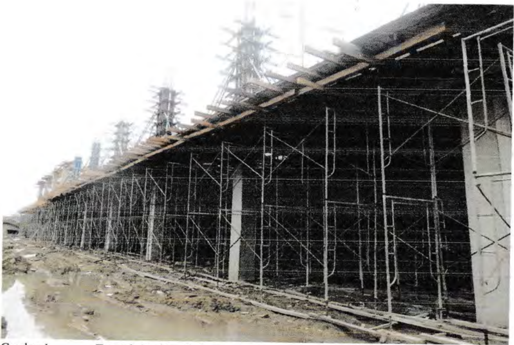
Gambar 1 : Tampak Struktur Gedung
