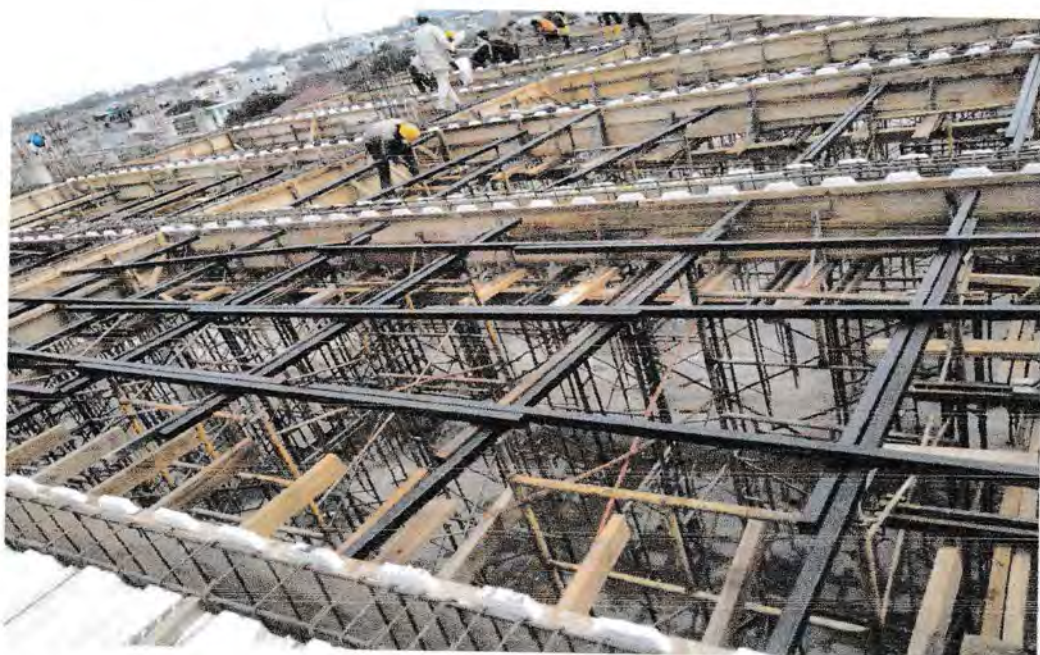
Gambar 6 : Pembuatan Bekisting Plat Lantai
