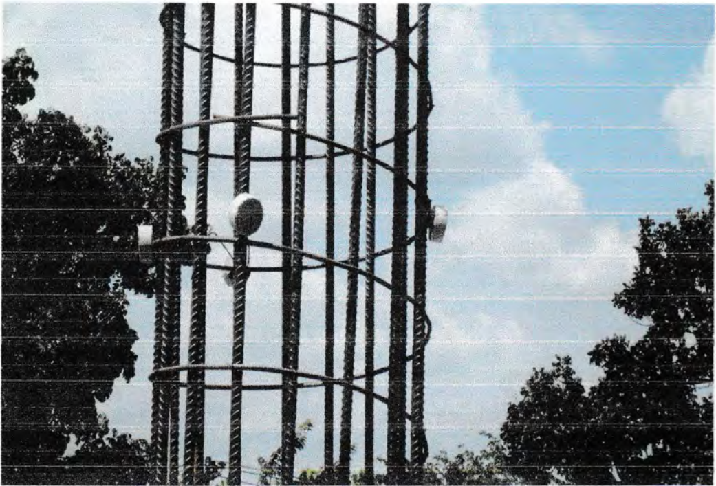
Gambar 23 : Tulangan Kolom dan Tahu Beton
