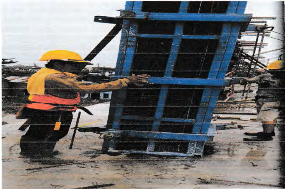
Gambar 2.29 Pembongkaran Bekisting
