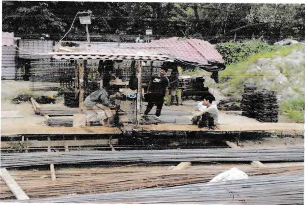
Gambar 27 : Tempat Pembuatan Tulangan
