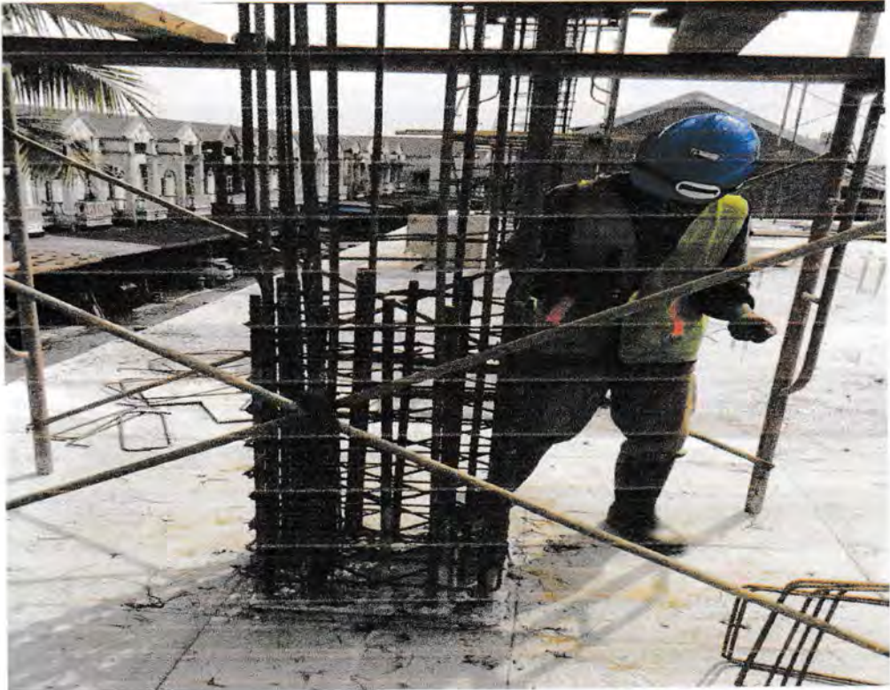
Gambar 2.24 Pembesian Kolom
