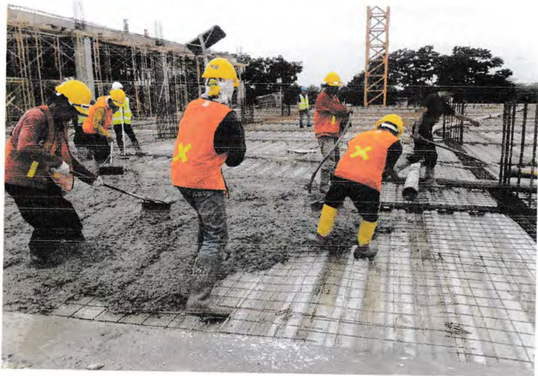
Gambar 12 : Pengecoran dan Pematatan Plat dan Balok
