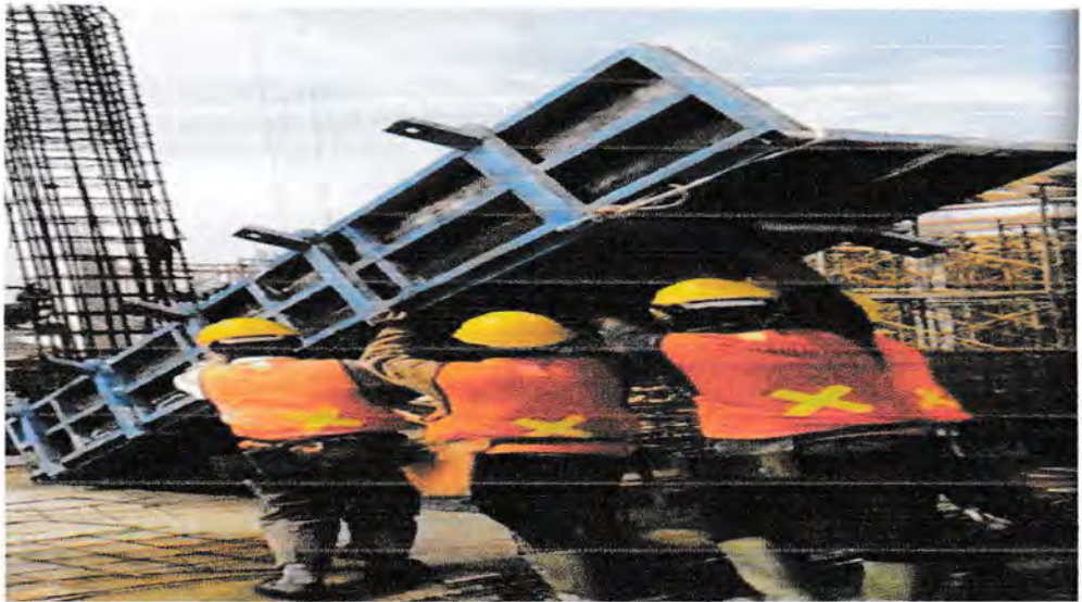
Gambar 2.26 Pemasangan Bekisting
