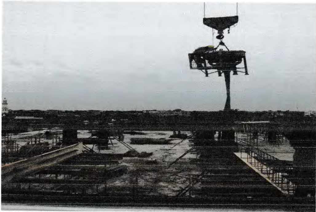
Gambar 14 : Pengecoran dan Pemasangan Kolom dengan menggunakan Bucket
