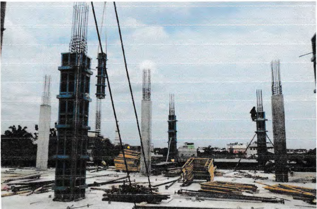
Gambar 24 : Pembongkaran Bekisting Kolom
