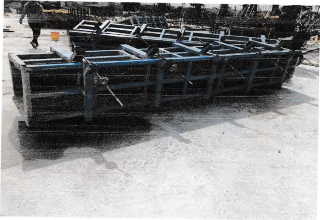
Gambar 21 : Bekisting Kolom
